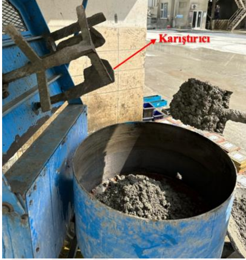
Şekil 49. Betoniyer ile HP agreganın yaş betona homojen olarak karıştırılması
