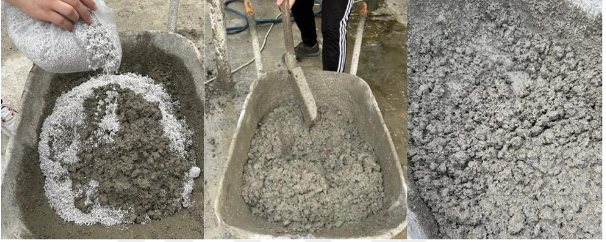
Şekil 44. Genleştirilmiş perlitli homojen beton karışımı elde etme aşamaları
