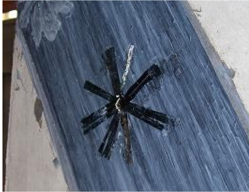
Resim 2.3. LP Bulon Uygulaması (108M397).
