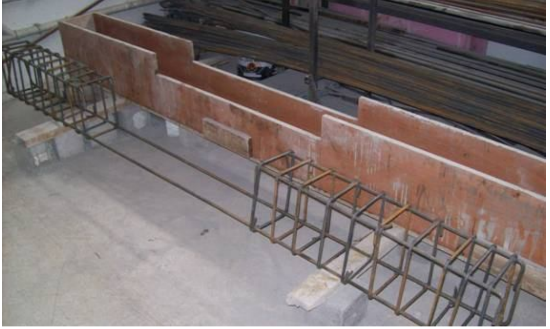
Resim 2.4. Beton dökümünde kullanılan kalıp ve demir donatı
