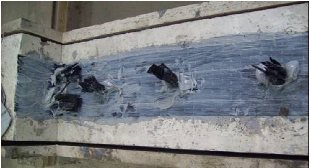
Resim 2.8. Fan ankraj ve LP Bulonların uygulanması (Deney Elemanı-2)
