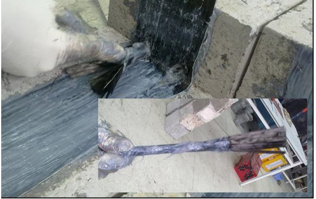
Resim 2.7. LP Ankraji (fan) ve uygulanması
