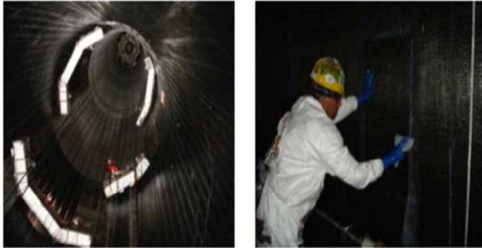
Şekil 6.4. Bacanın iç duvarının güçlendirilmesi
