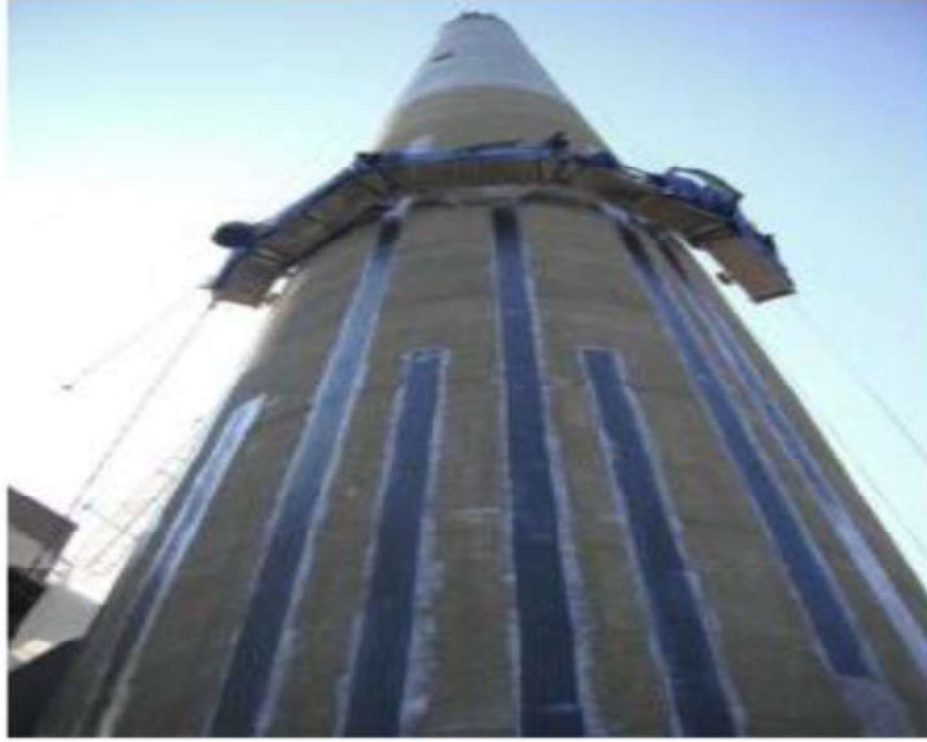
Şekil 6.3. Bir bacanın güçlendirilmesi
