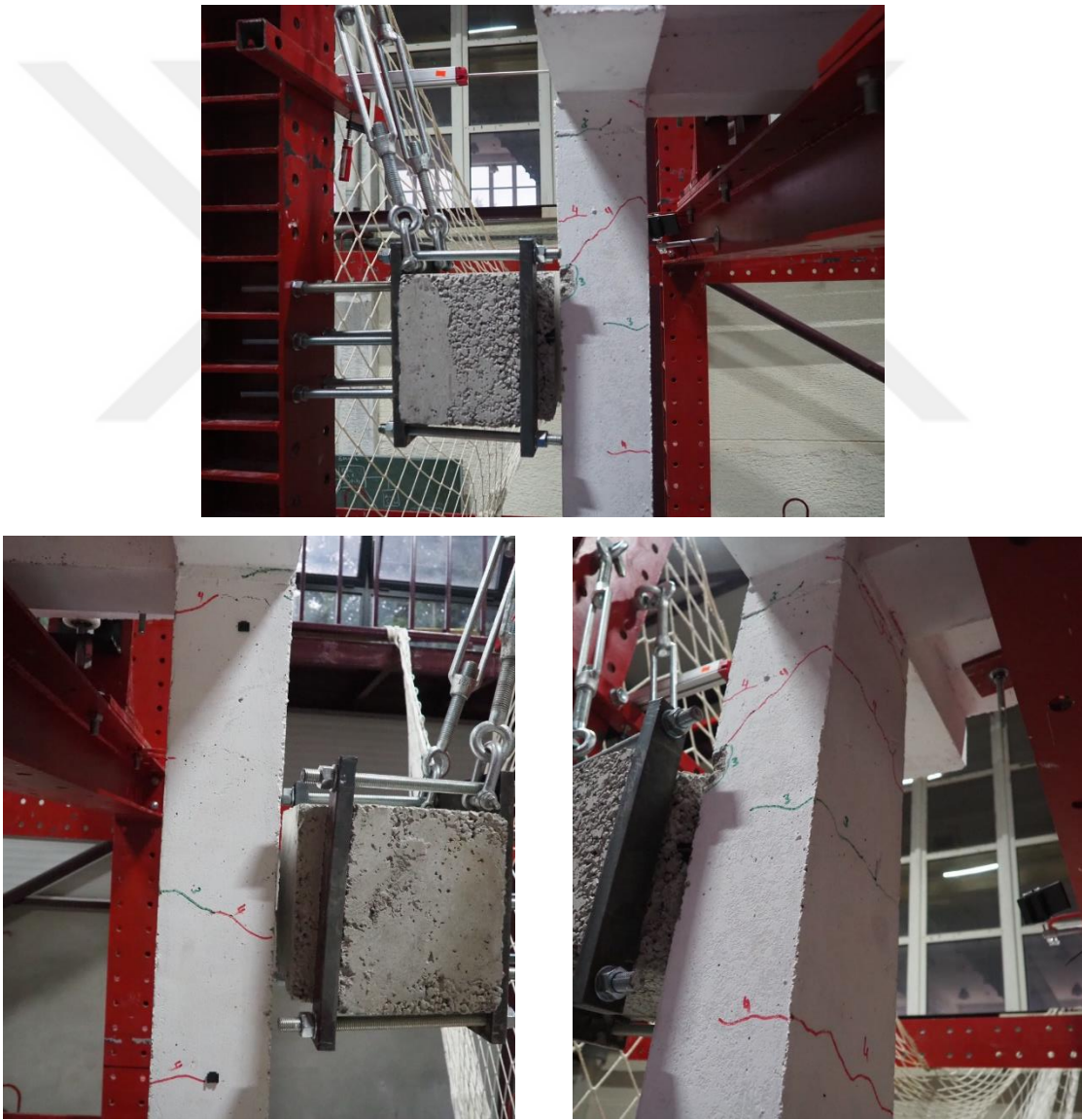
a. %75 ve %100 Erzincan depremleri sonrasında çarpışma nedeniyle oluşan hasarlar
