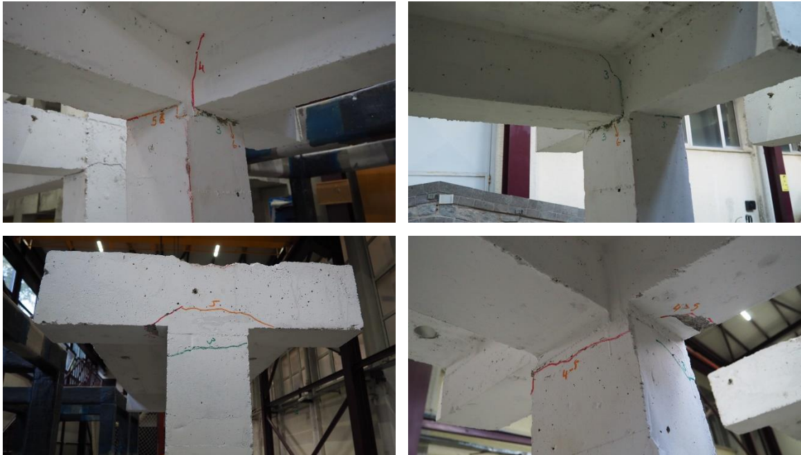
a. Sarsma masası deneyleri sonrasında kolon üst uçlarında ve birleşim bölgelerinde işaretlenen hasarlar
