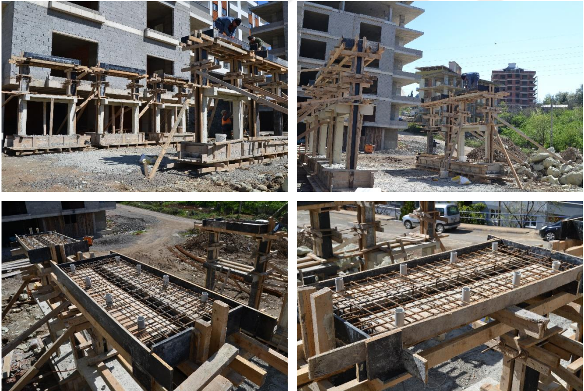
Şekil 2.11. 2. kat kalıp ve donatı imalatı, beton dökümüne ait görseller
