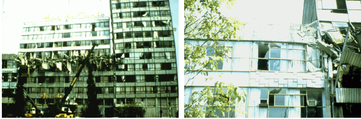
Şekil 3.64. 1985 Mexico City depreminde farklı yüksekliğe sahip binaların çarpışması nedeniyle oluşan hasarlar (URL-5; Arnold, 1985)
