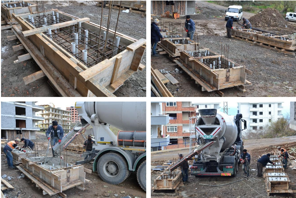
Şekil 2.9. Temel kalıbı ve donatılarının hazırlanışı, beton dökümü
