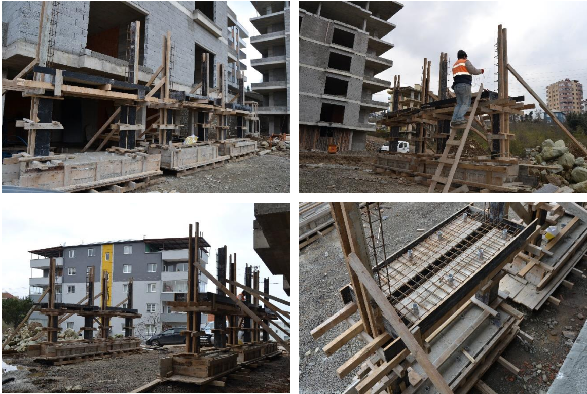
Şekil 2.10. 1. kat kalıp ve donatı imalatı, beton dökümüne ait görseller
