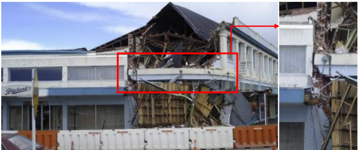
Şekil 1.12. 2010 Darfield depreminde hasar gören yığma bina (Cole vd., 2010b)
