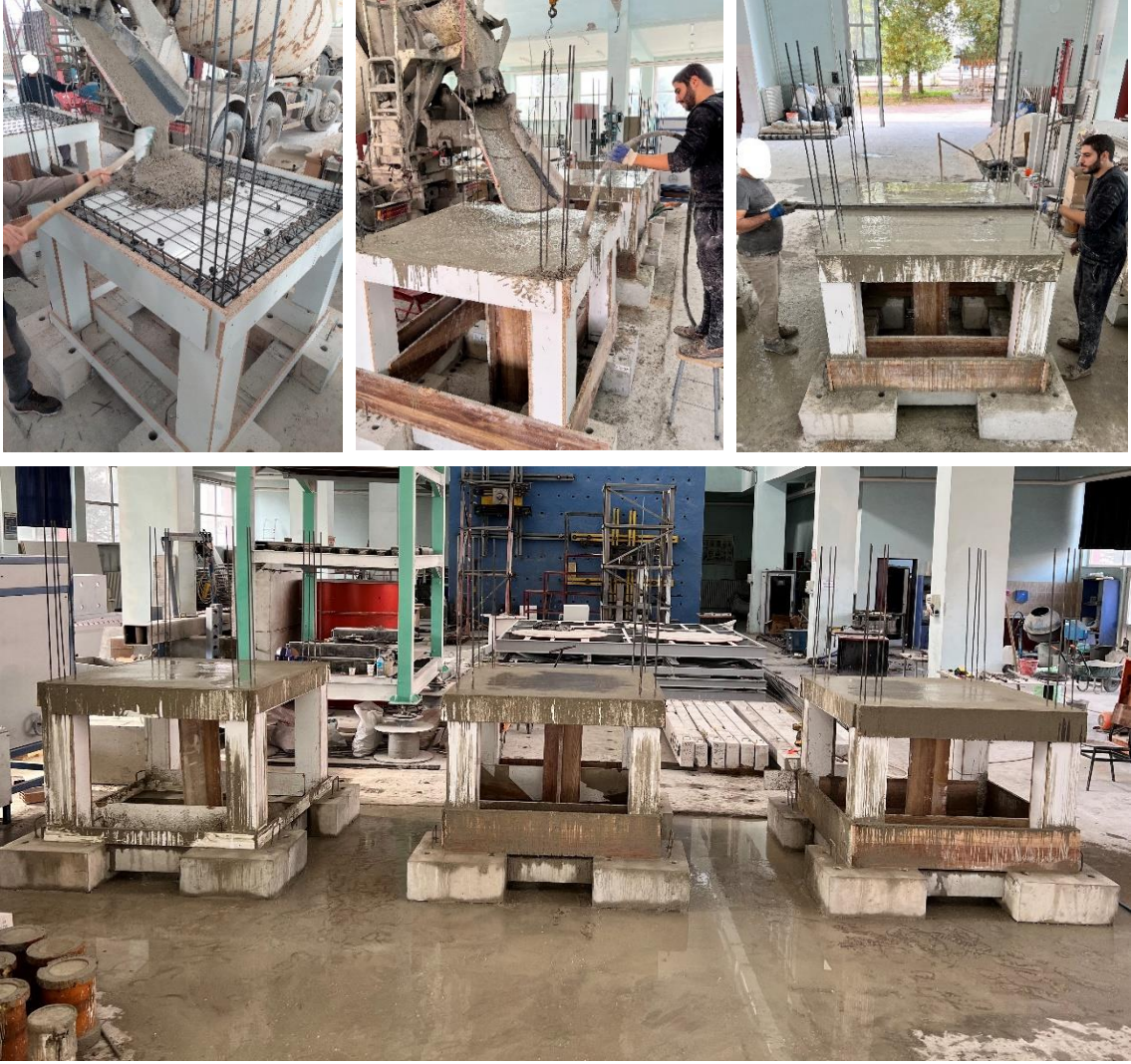
Şekil 3.18. 1. kat beton dökümü
