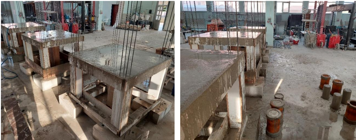
Şekil 3.19. 1. kat betonunun kürlenmesi
