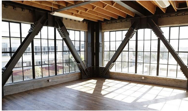
řekil 1.52. Betonarme bir binada ters V tipi elik apraz elemanlarla glendirme ( https://www.aspacelik.com.tr )
