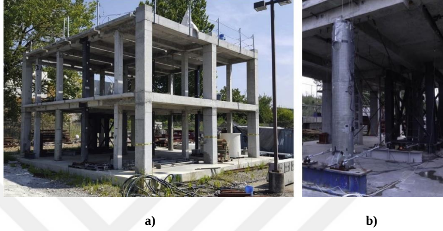
Şekil 2.7. Numuneler ve güçlendirme; a) 4 özdeş test çerçevesi, b) Güçlendirilmiş kolon (Shin ve diğ., 2016)
