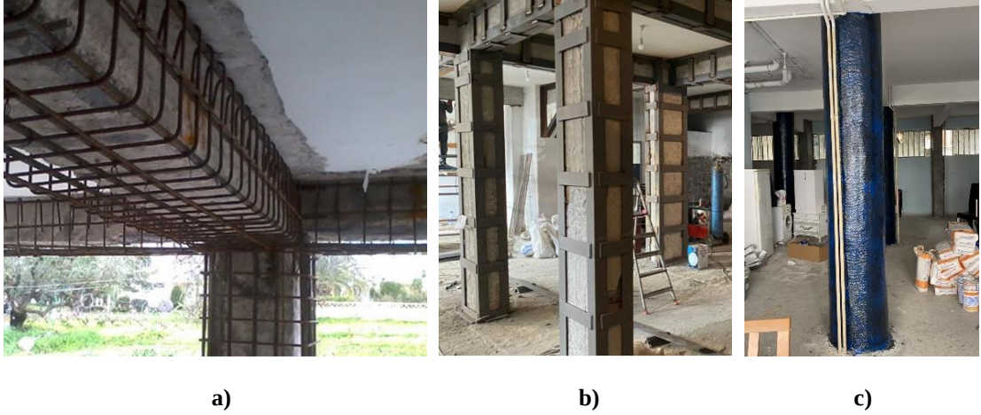
Şekil 1.47. Eleman bazında uygulanan bazı güçlendirme teknikleri; a) Betonarme mantolama ( https://aksas.istanbul ), b) Çelik mantolama ( https://www.kolonguclendirme.com.tr/ ) c) CFRP sargısı ( https://www.karadenizteknikproje.com )
