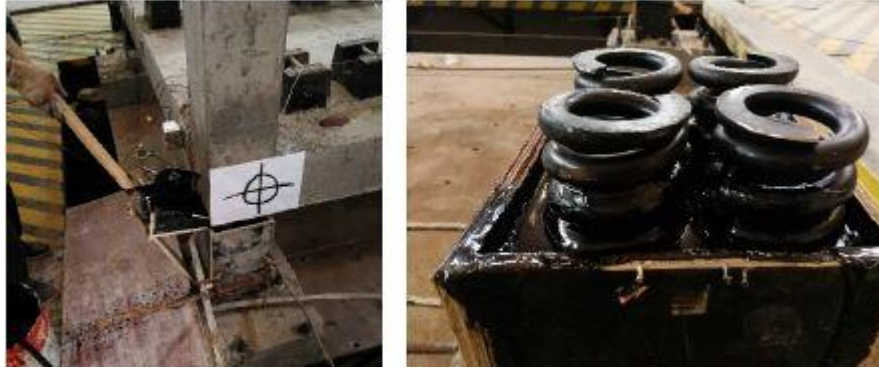
Şekil 2.24. Asfaltlı yaylı izolasyon sistemi (Shang ve Wang, 2020)
