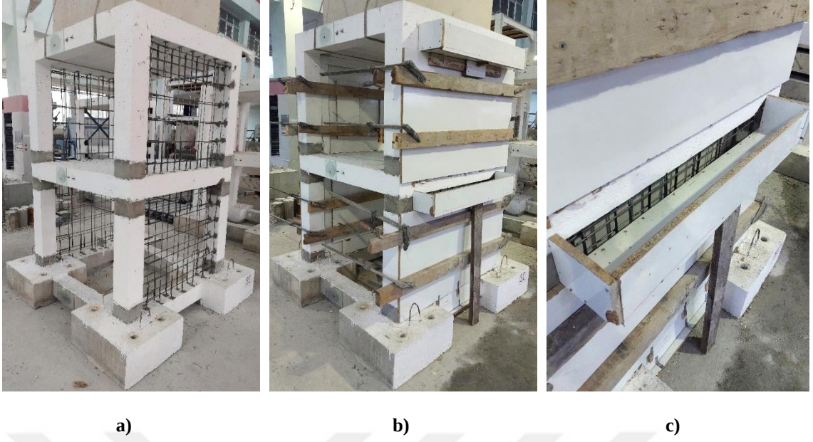
Şekil 3.62. Güçlendirme perdelerinde donatı ve kalıp montajı; a) Donatı imalatı, b) Kalıp imalatı, c) Beton döküm haznesi
