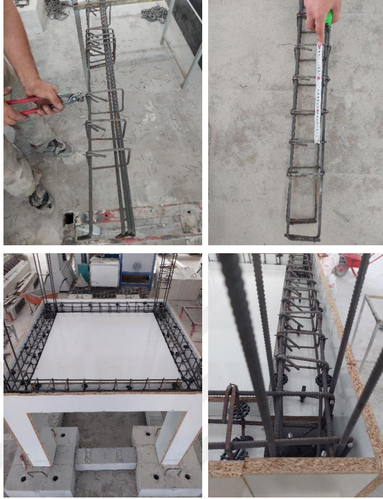
Şekil 3.15. 1. kat kiriş donatı montajı
