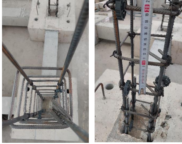
Şekil 3.13. Kolon donatılarının montajı (devamı)
