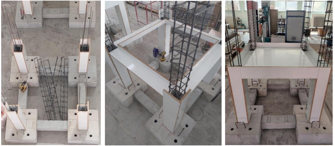
Şekil 3.14. 1. kat kalıp montajı
