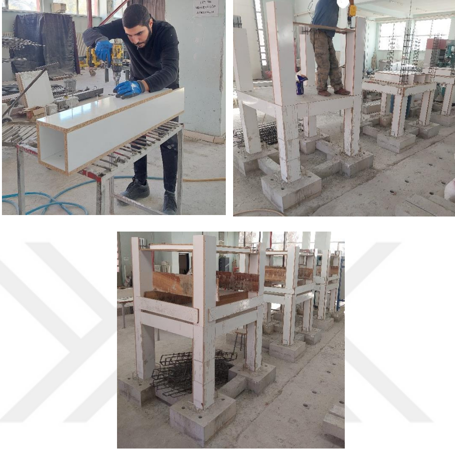
Şekil 3.21. 2. kat kalıp montajı
