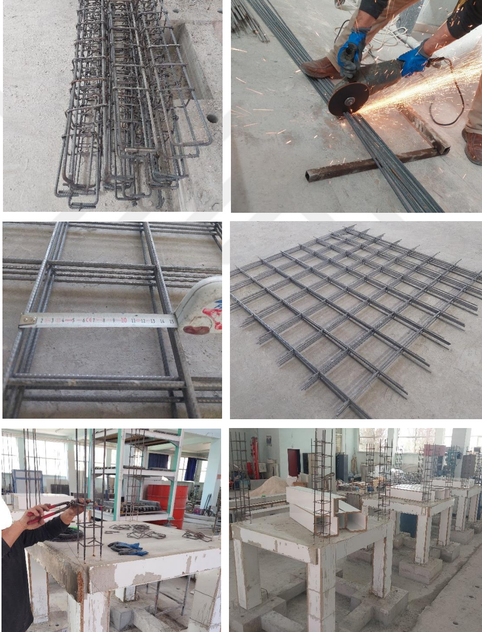
Şekil 3.20. 2. kat taşıyıcı elemanlarının donatı imalatı
