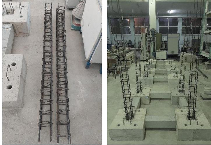
Şekil 3.12. Kolon donatılarının montajı
