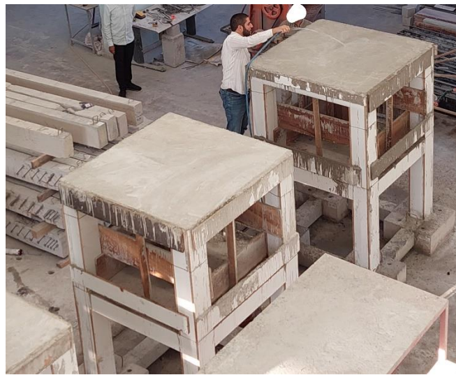
Şekil 3.25. 2. kat betonunun kürlenmesi
