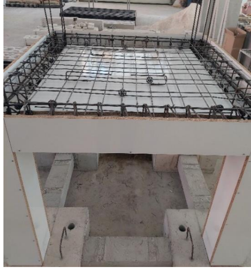
Şekil 3.16. 1. kat döşeme donatı imalatı
