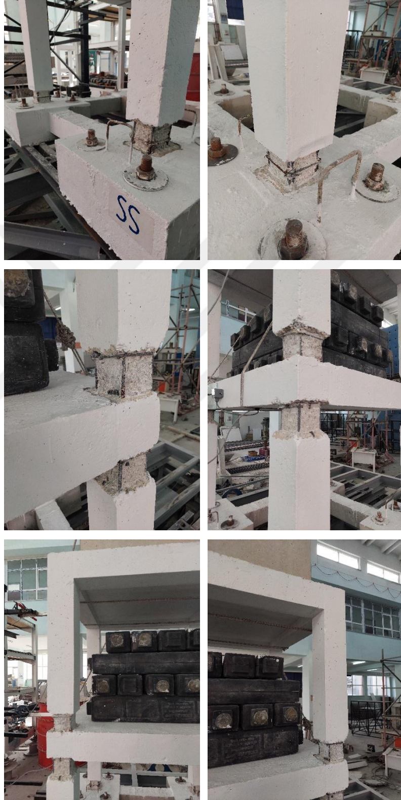
Şekil 4.6. SS numunesinin hasarlı durum deneyleri sonrasında detay görünüřleri
