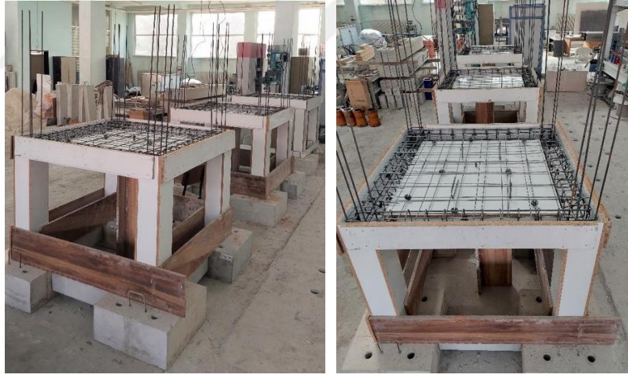
Şekil 3.17. Çerçevelerin 1. kat beton dökümü öncesi son hali
