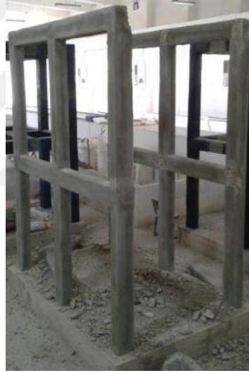
Şekil 2.48. Hasarsız durumda çerçevenin görünüşü (Altunışık ve diğ., 2018)
