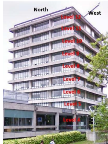
Şekil 2.66. Betonarme test binası (Beskhyroun ve diğ., 2019)
