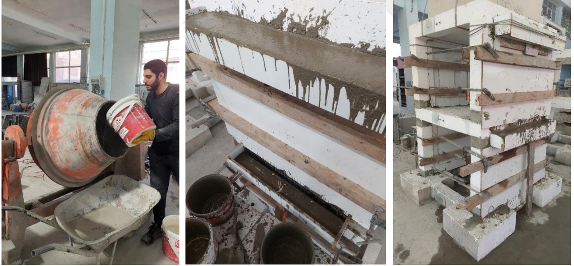
Şekil 3.63. Güçlendirme perdelerinin beton dökümü
