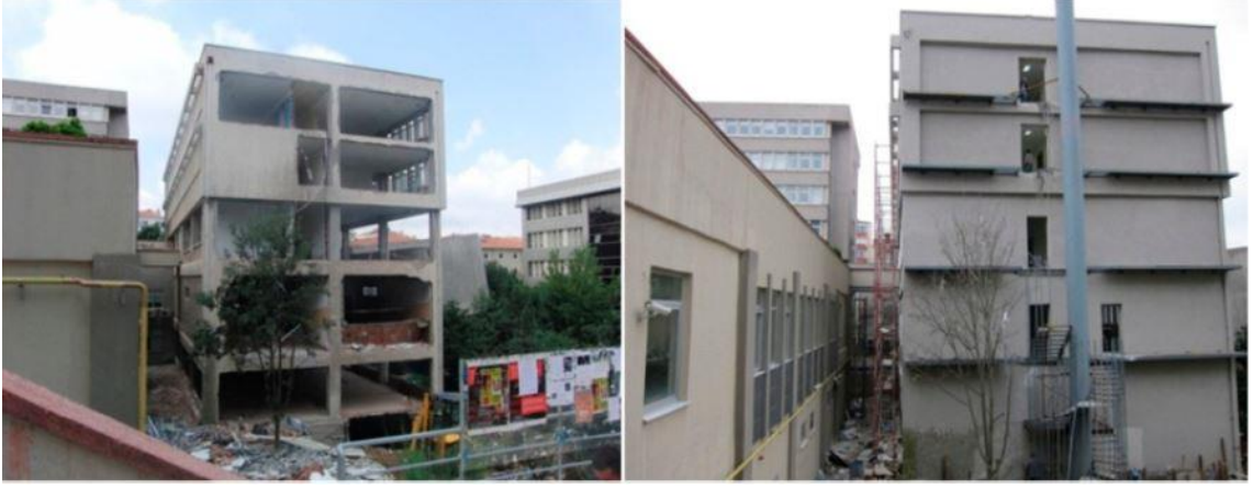
Şekil 2.60. İncelenen binanın görünüşleri; Güçlendirme öncesi (solda), Güçlendirme sonrası (sağda) (Soyoz ve diğ., 2013)
