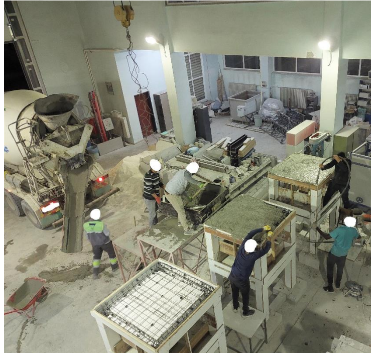
Şekil 3.23. 2. kat beton dökümü
