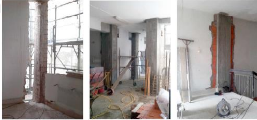
Şekil 2.46. Bazı güçlendirme uygulamaları (Pierdicca ve diğ., 2017)
