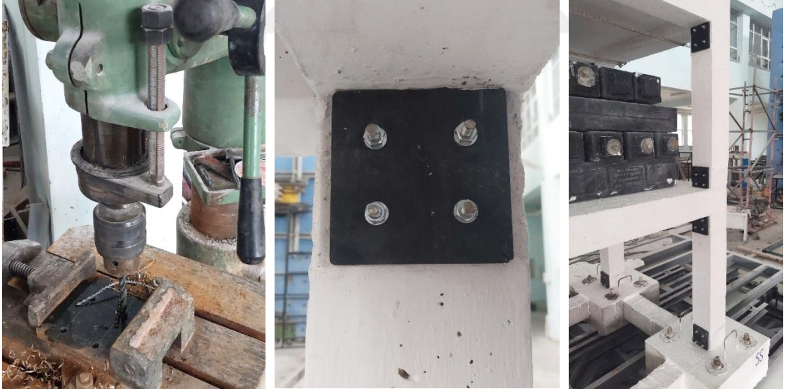
Şekil 3.55. Çelik plakaların delinip kolon uçlarına sabitlenmesi
