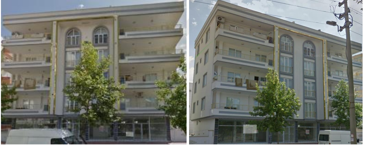
Şekil 24. Seçilen binanın 2023 Kahramanmaraş depremleri öncesi ve sonrasına ait görseller
