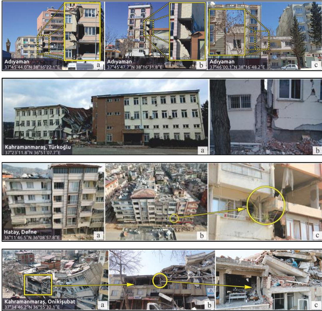
Şekil 1. 2023 Kahramanmaraş depremlerinde meydana gelen çarpışma kaynaklı hasarlar (Damcı vd. ,2025)
