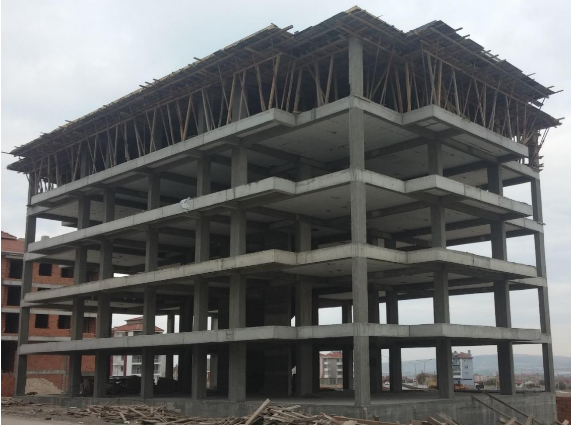
Görsel 5.1. Binanın karkas halinin görüntüsü
