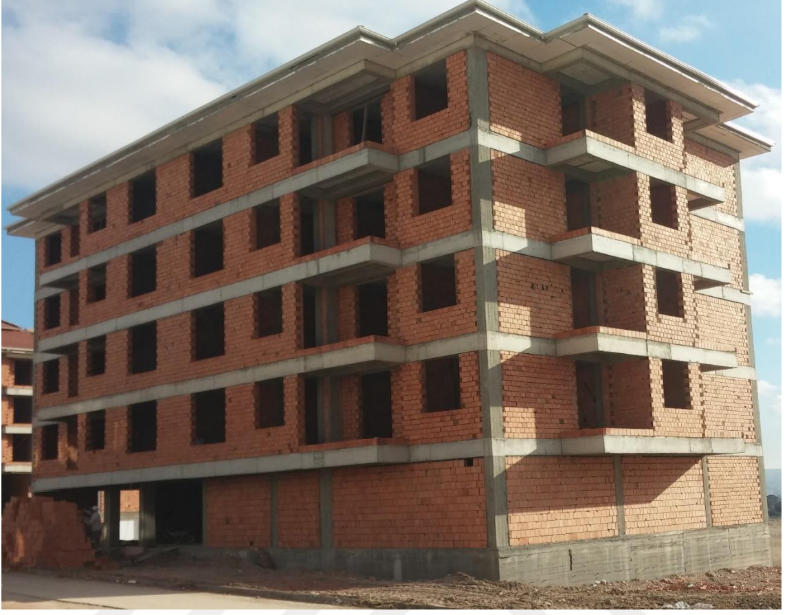
Görsel 5.2. Binanın sıvasız bitmiş dolgu duvarlı halinin görüntüsü
