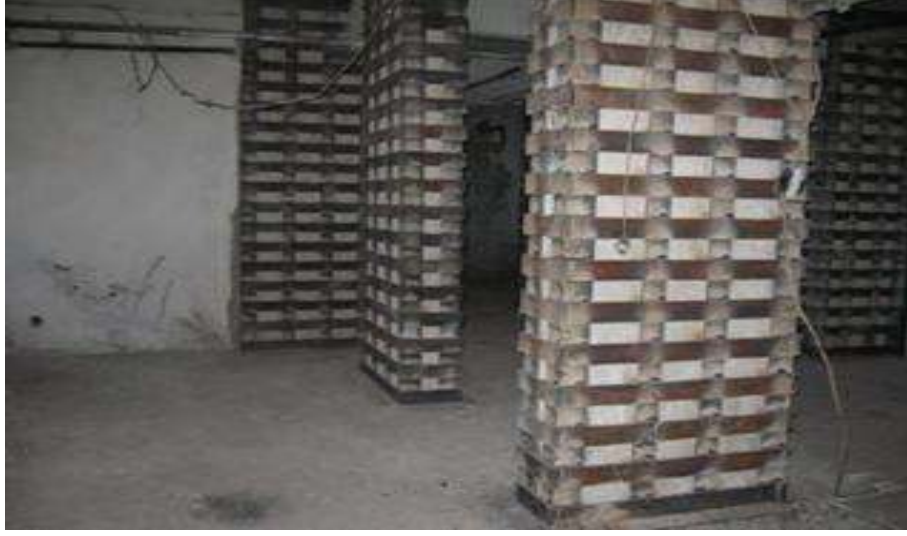
Şekil 3.3. Kolonların çelik ile sarılması [50]
