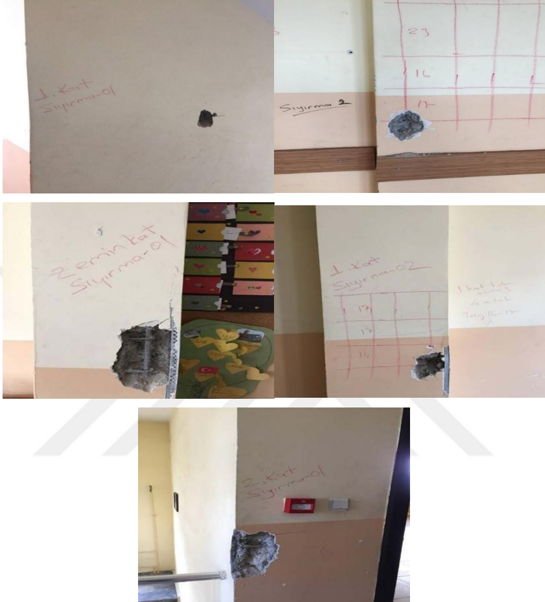
Şekil 4.6. Yapılan sıyrma işlemleri
