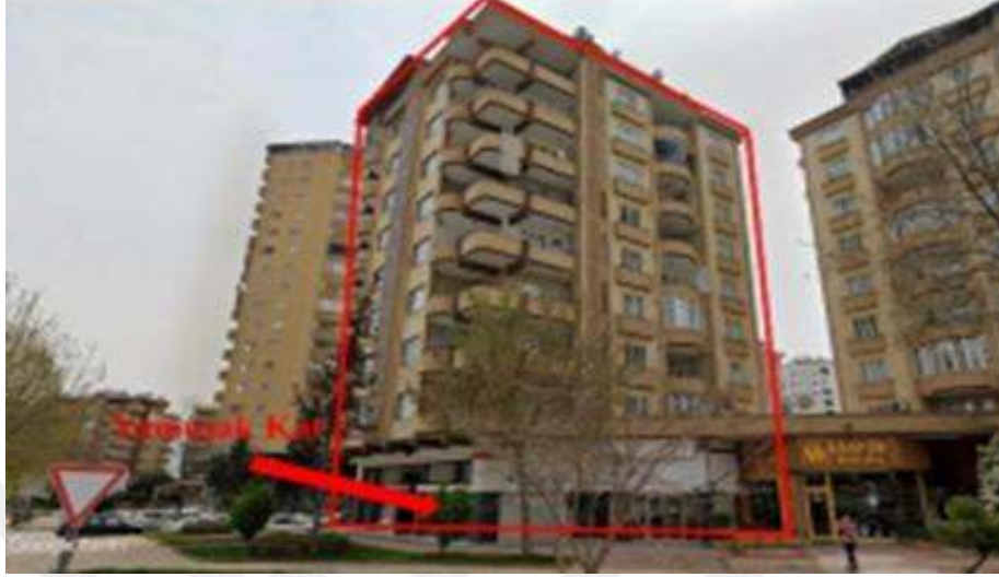
Şekil 2.5. Yumuşak kat bulunan bir bina [38]
