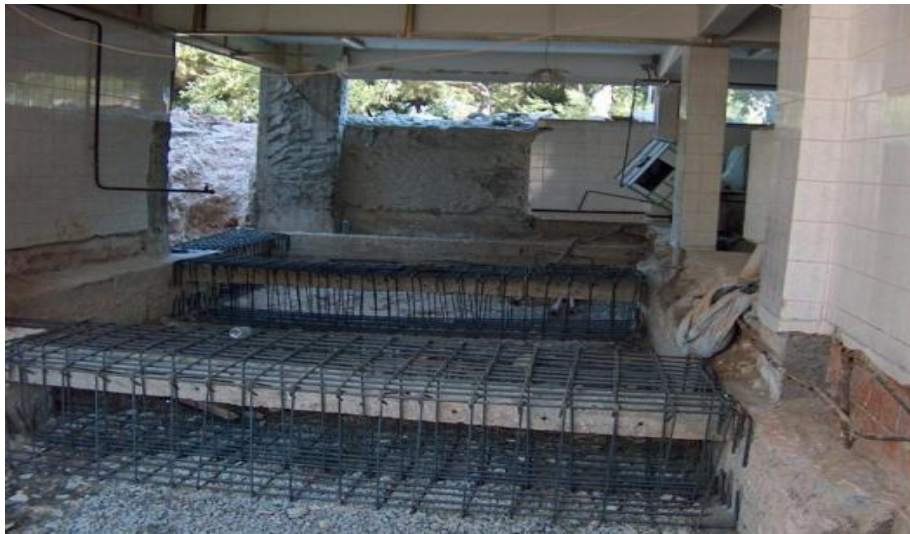
Şekil 3.8. Temellerin güçlendirilmesi [50]
