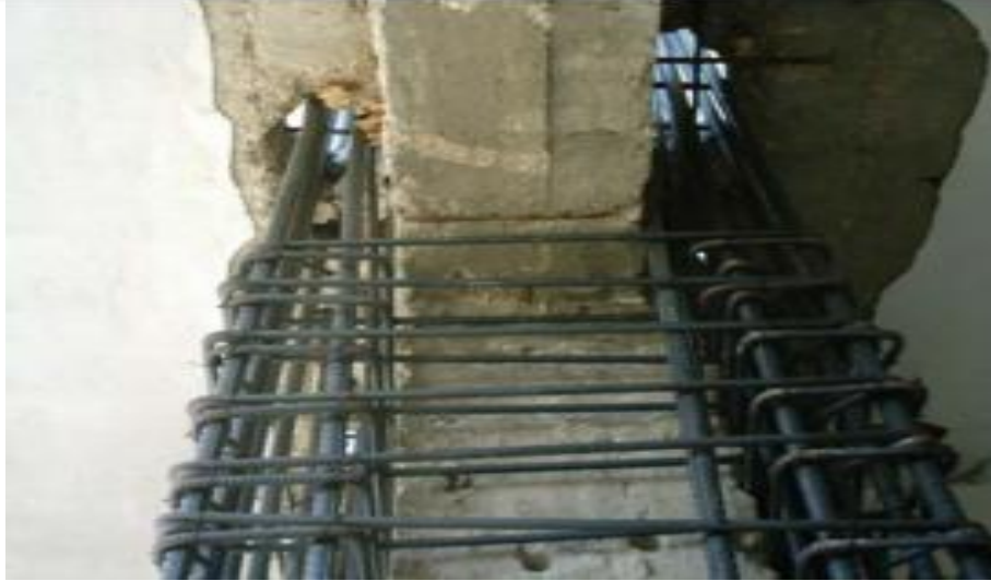
Şekil 3.6. Kolonun betonarme ile mantolanması [51]
