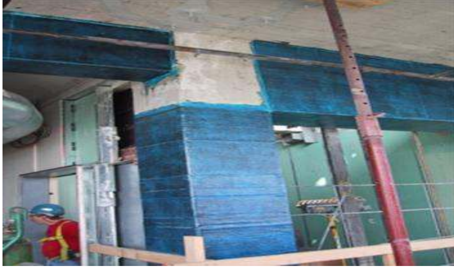
Şekil 3.7. Karbon Lifli Polimerle (FRP) kiriş kapasitelerinin arttırılması [51]
