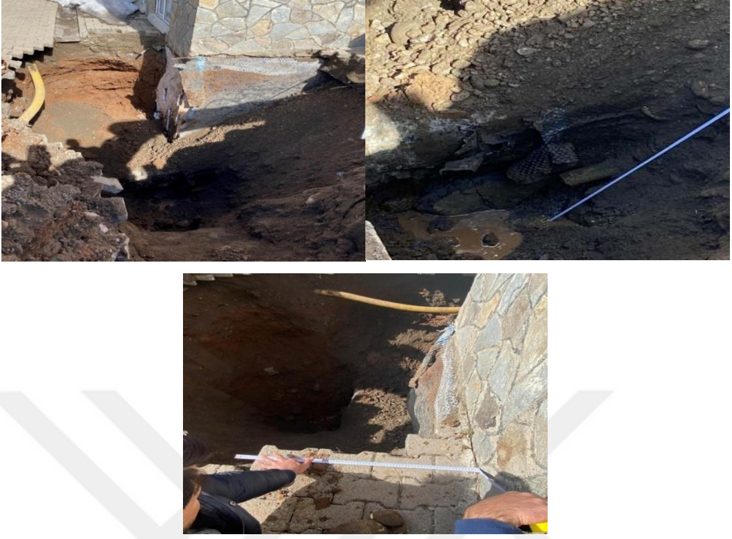
Şekil 4.8. Yapıya ait gözlem çukurları
