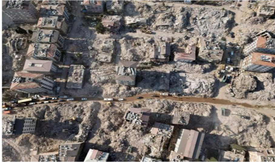
Şekil 2.2. Depremde hasar betonarme konut yapıları [30]
