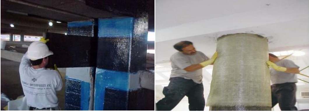
Şekil 3.2. Kolonun sarılarak güçlendirilmesi [51]
