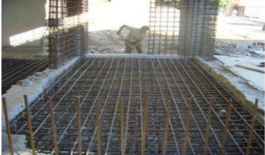
Şekil 3.5. Perde güçlendirmesi için yapılan temel güçlendirme işlemi [50]
