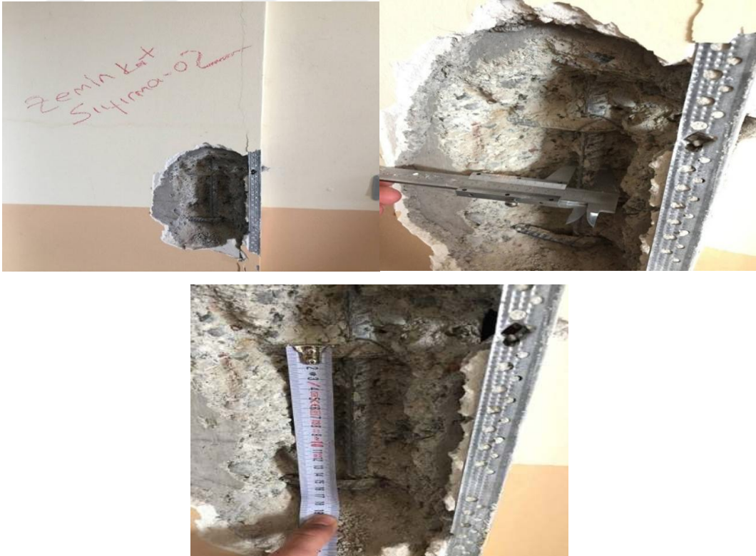
Şekil 4.5. Yapılan donatı testleri
