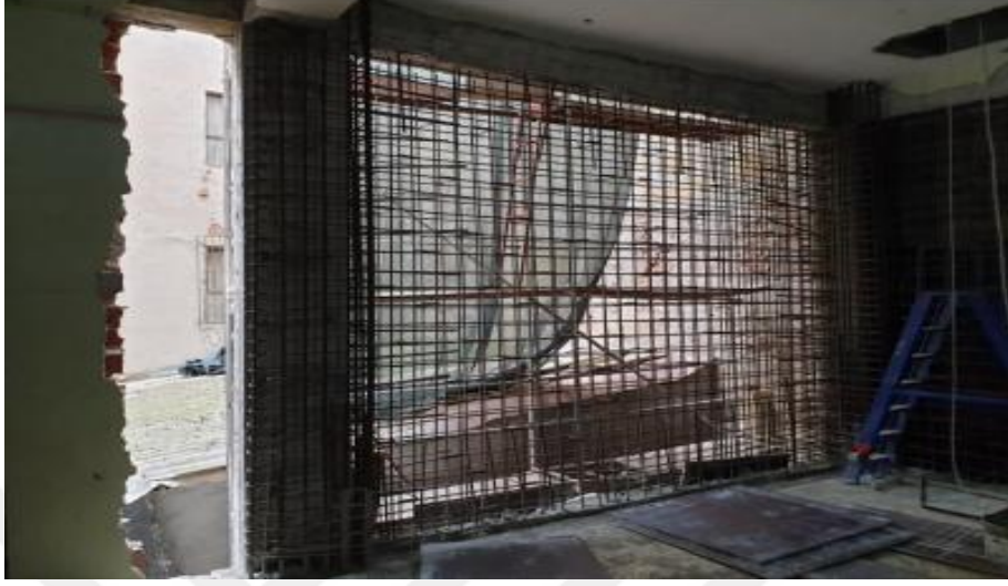
Şekil 3.4. Yeni betonarme perde eklenmesi [53]
