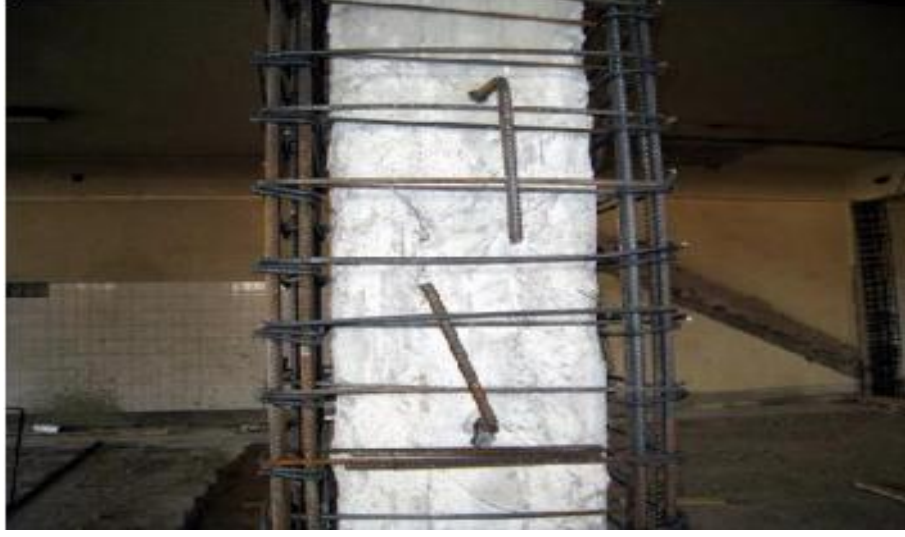
Şekil 3.1. Mantolamada donatı uygulaması [50]
