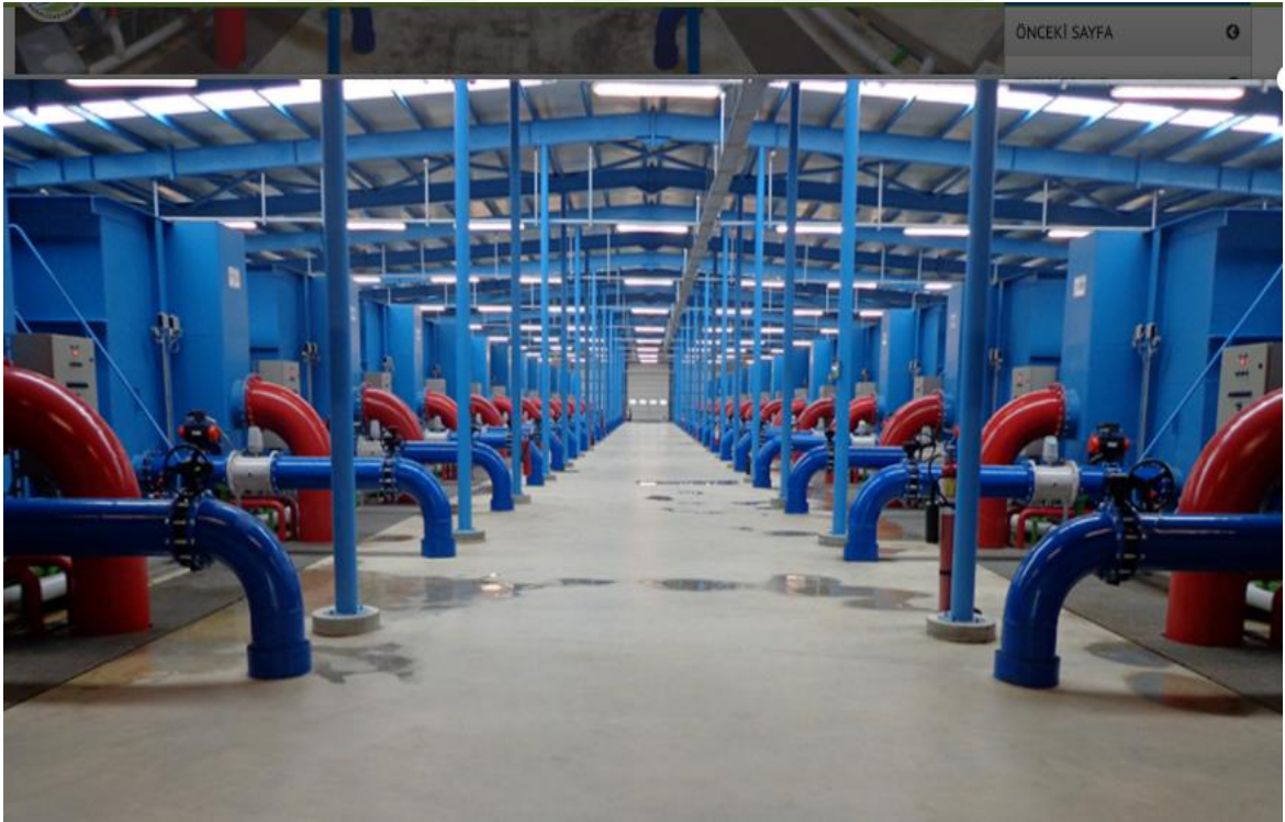
Şekil 11: Hızırilyas İçmesuyu Arıtma Tesisi
