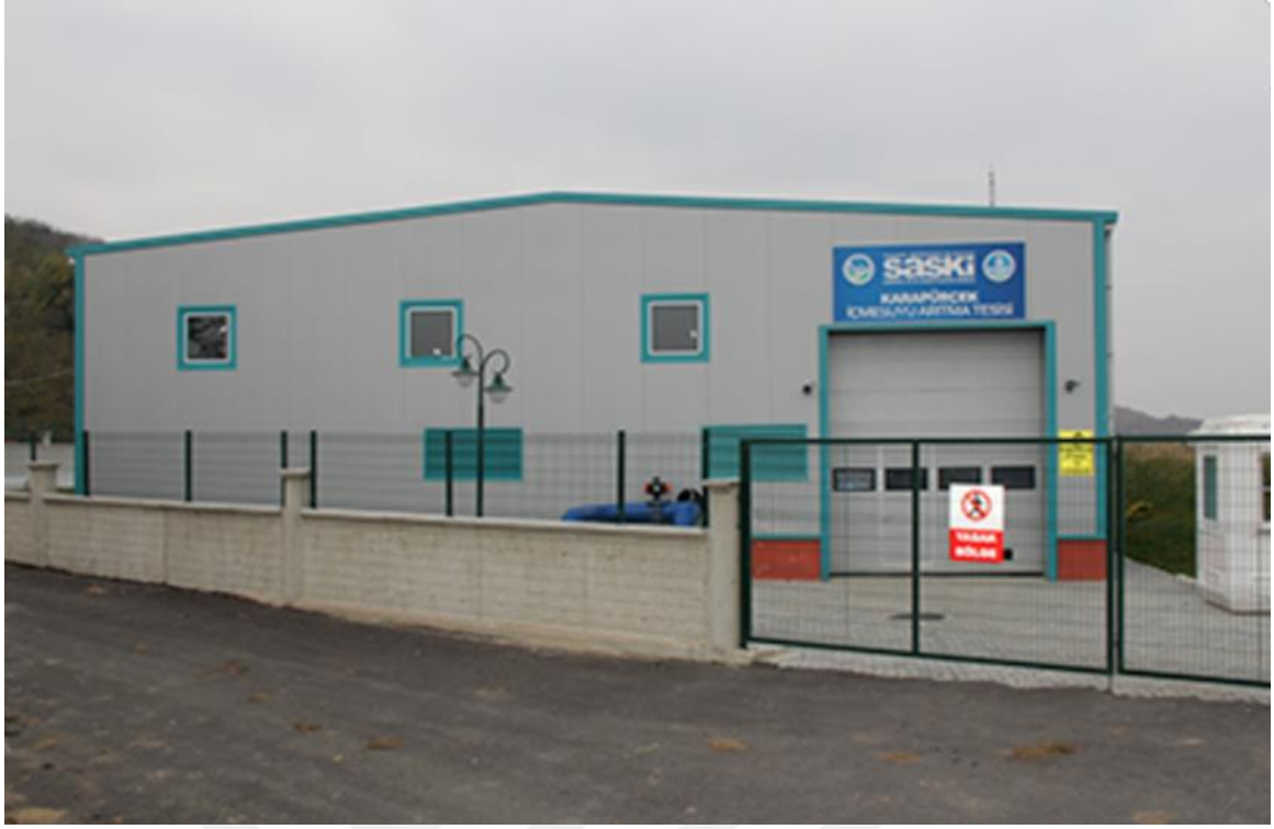
Şekil 10: Karapürçek İçmesuyu Arıtma Tesisi - 2
