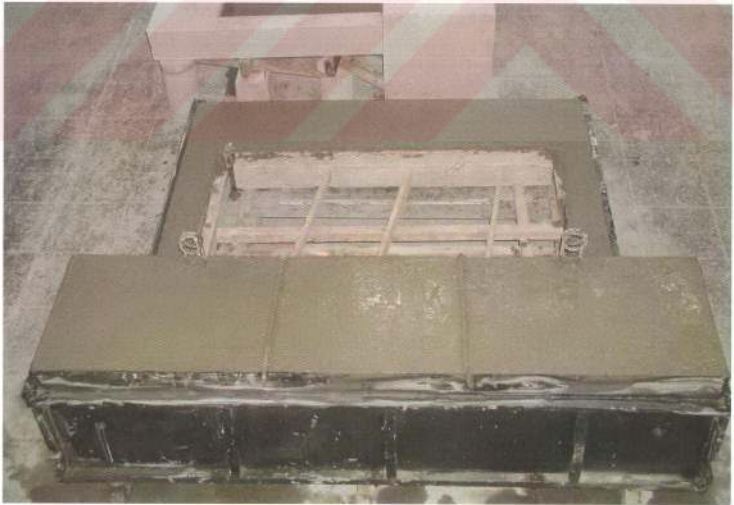
Şekil 4.11. Beton dökümü tamamlanmış çerçeve
