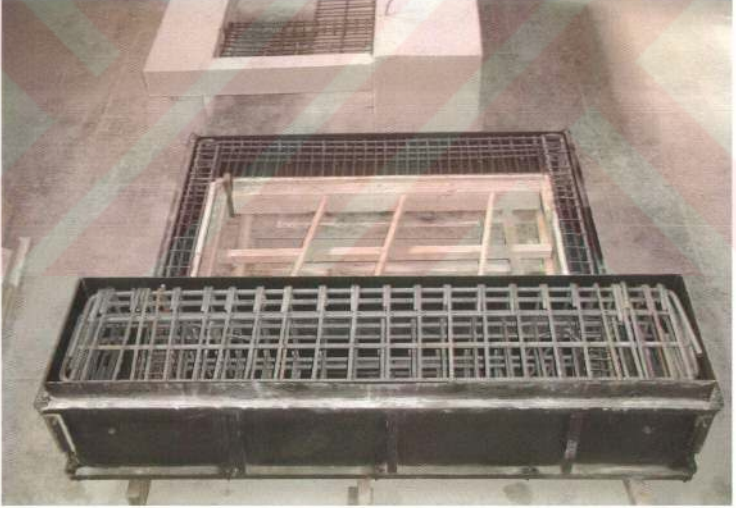
Şekil 4.10. Kalıp içine yerleştirilmiş çerçeve donatısı
