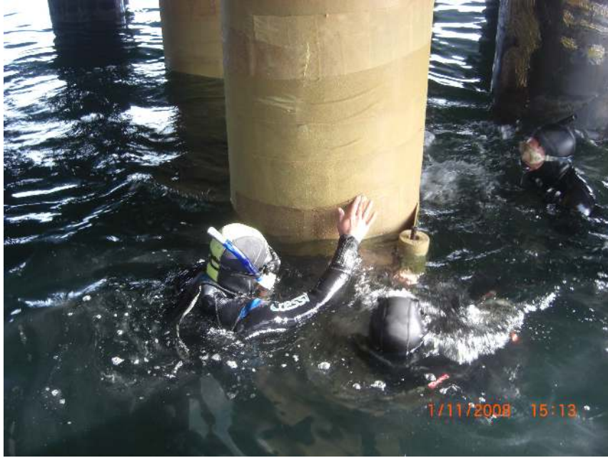
Şekil 5.4 Kaplama uygulama örneği 1. aşama
