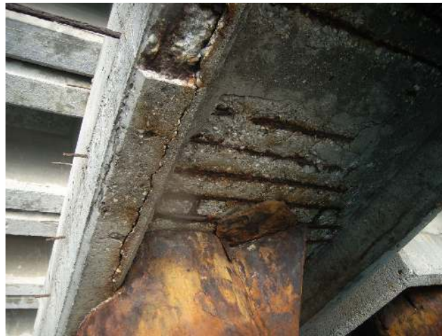
Şekil 5.12 Başlık içine düzgün oturmeyen kazık örneği
