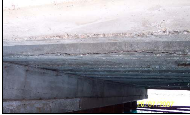
Şekil 5.11 Döşeme altı betonarme prekast elemanlar
