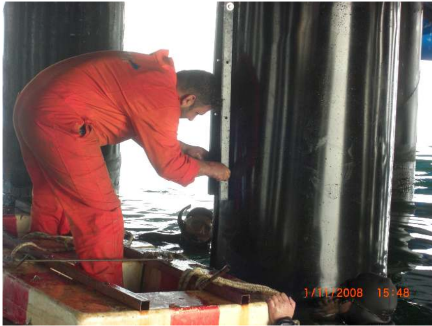
Şekil 5.5 Kaplama uygulama örneği 2.aşama
