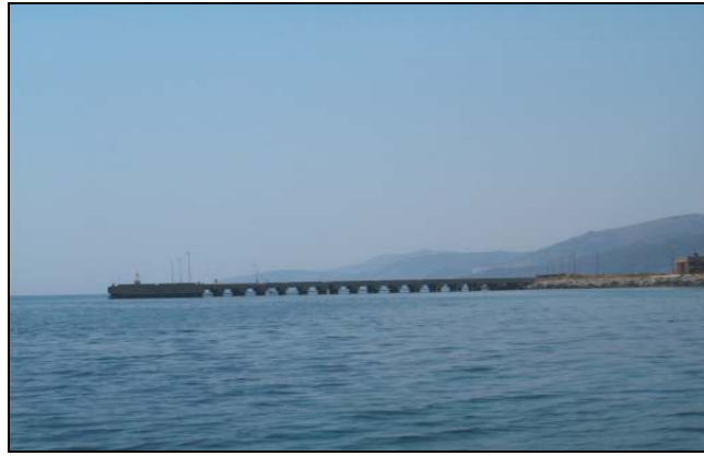
Şekil 5.8 Kemerköy ağır yük iskelesi genel görünümü
