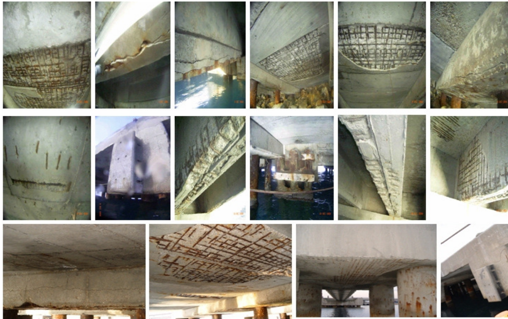
Şekil 5.3 Betonarme korozyon
