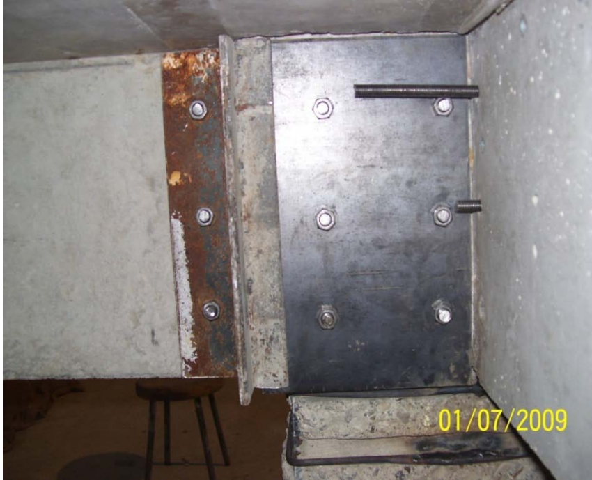
Resim 3.44. F1 ve G2 elemanlarında dikdörtgen bölgelerin güçlendirilmesi
