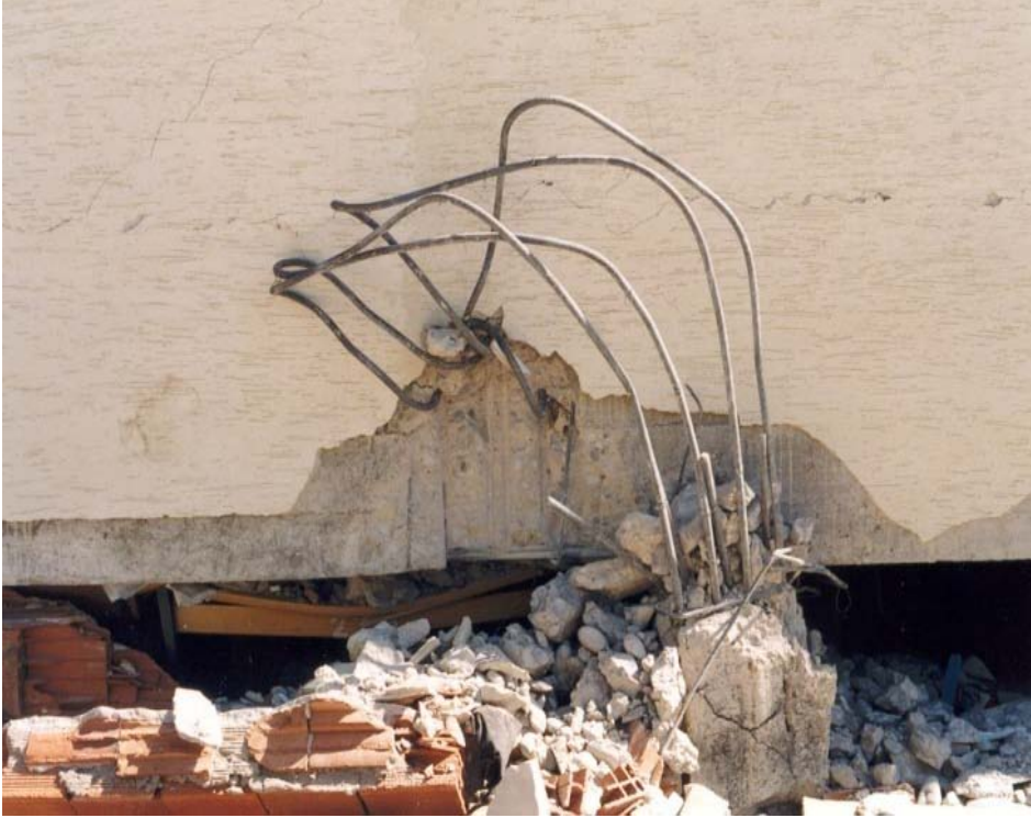
Resim 1.5. Yapının diğerk yöndeki dış cephesinde düğüm bölgesinden çıkan kolon
