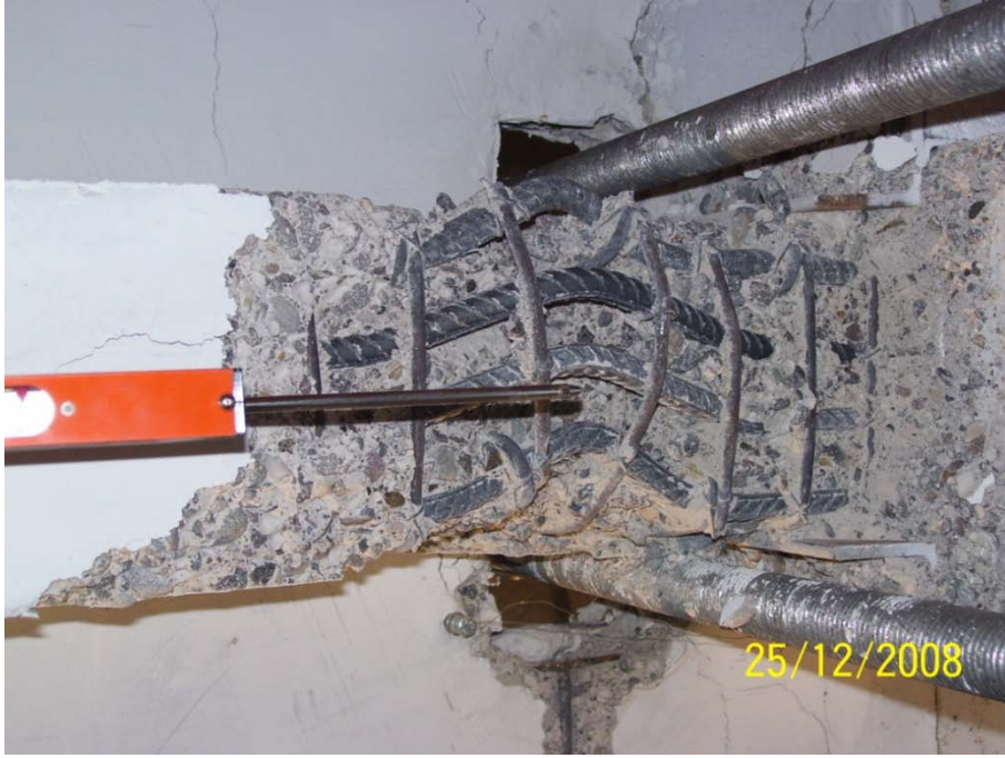
Resim 3.27. E2 elemanında kiriş alt donatılarının burkulması
