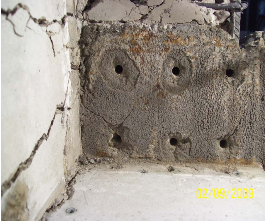
Resim 3.39. F1 güçlendirmesinde kabuk betonu ve çelik plaka kaldırıldıktan sonra düğüm bölgesi ön yüz görünüşü
