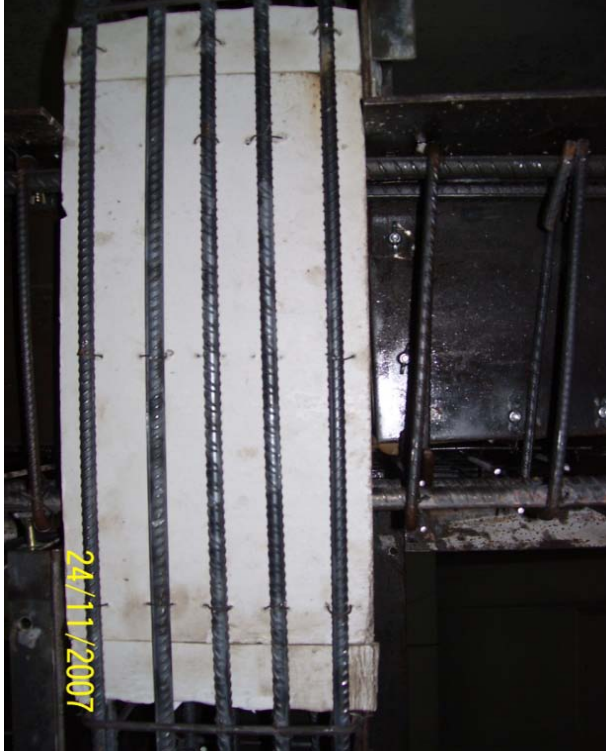
Resim 3.5. Zayıf elemanlarda kolondaki etriyesiz bölgeler
