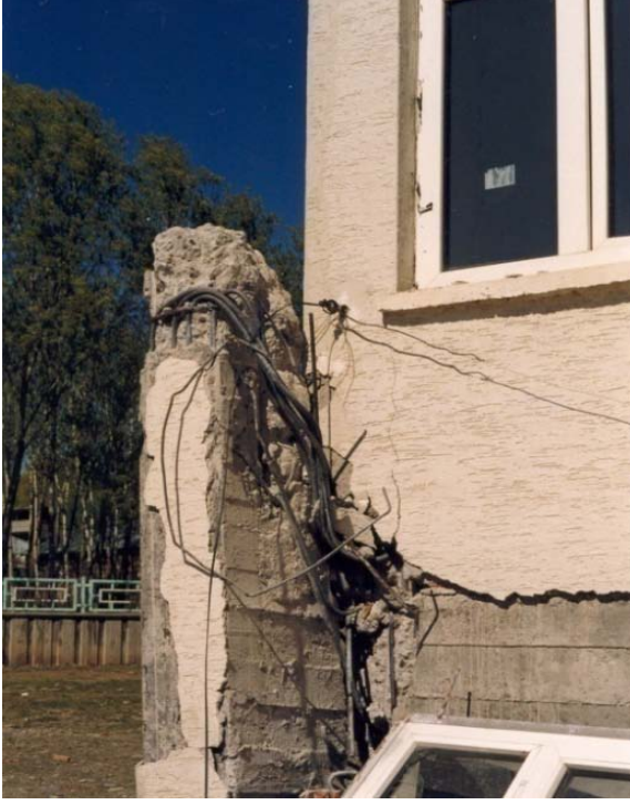
Resim 1.3. Yapının dış cephesinde düğüm bölgesinden çıkan kolon
