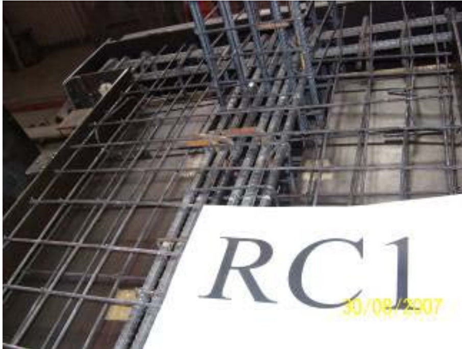
Resim 3.2. Deney elemanı kiriş ve döşeme donatıları
