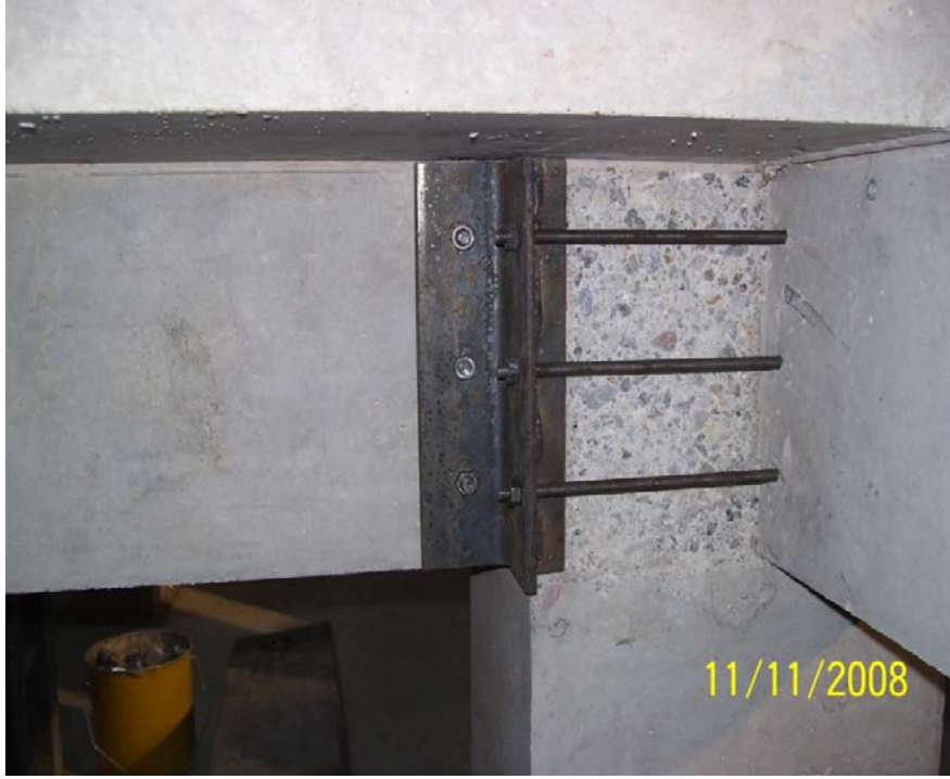
Resim 3.25. C ve E tipi güçlendirmelerde beton kaplanmadan önceki görünüm
