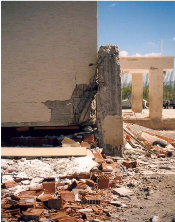
Resim 1.2. Yapının dış cephesinde düğüm bölgesinden çıkan kolon
