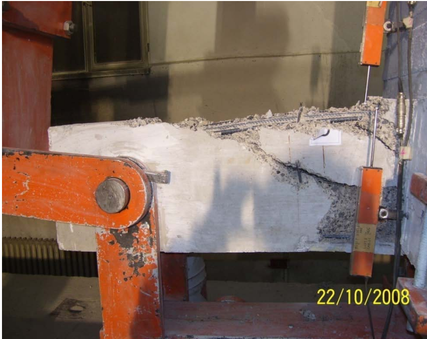
Resim 3.16. WC1d elemanı üst kolon hasarı
