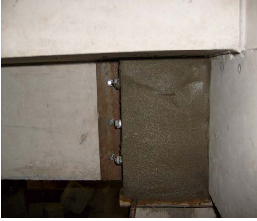
Resim 3.35. F1 ve G2 elemanlarında düğümdeki kuşatılmamış bölgenin üzerine yapılan sıva
