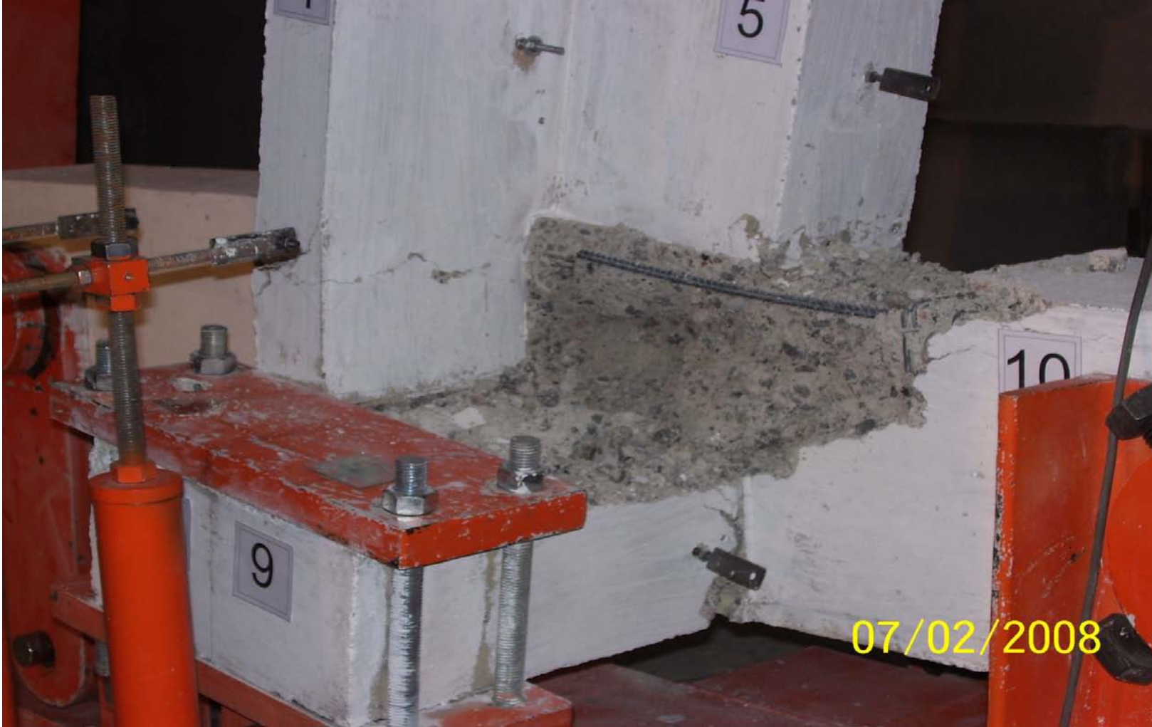
Resim 4.6. WC1a elemanında düğüm bölgesi ve kolon hasarı
