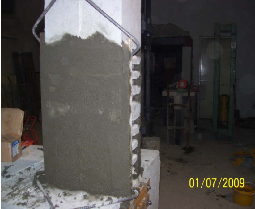
Resim 3.36. G2 elemanının kolonuna güçlendirme sonrası yapılan sıva
