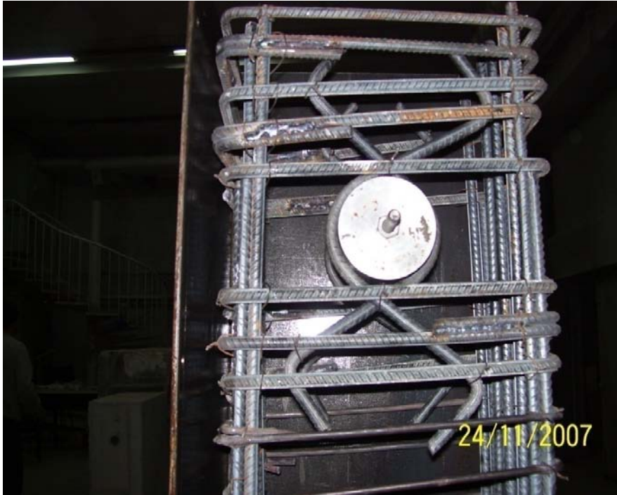
Resim 3.4. Kolonda bırakılan deliklerin etrafında alınan önlemler
