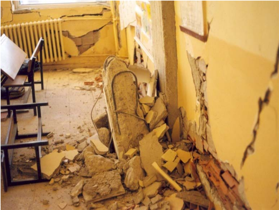
Resim 1.6. Kolonun düğüm bölgesinden ayrılıp döşemeyi zımbalaması
