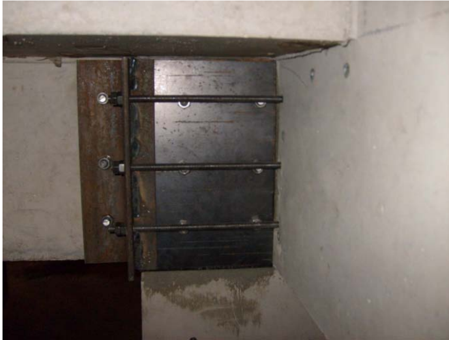
Resim 3.38. F1 ve G2 güçlendirmelerinde kuşatılmamış bölgedeki çelik plakalar ve ard germe bulonları
