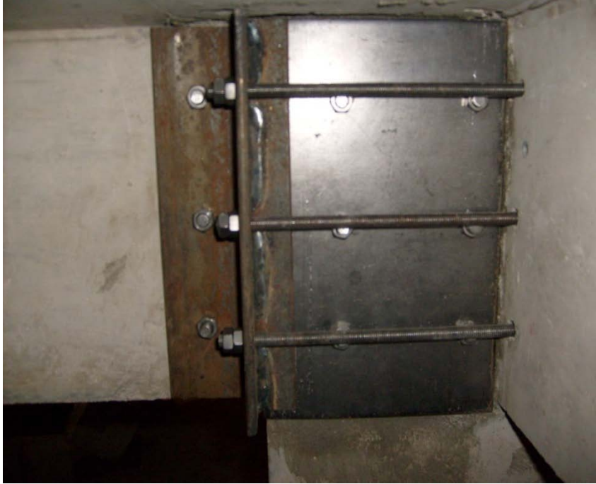
Resim 3.34. F1 ve G2 elemanlarında düğümdeki kuşatılmamış bölgeye bağlanan kapaklar
