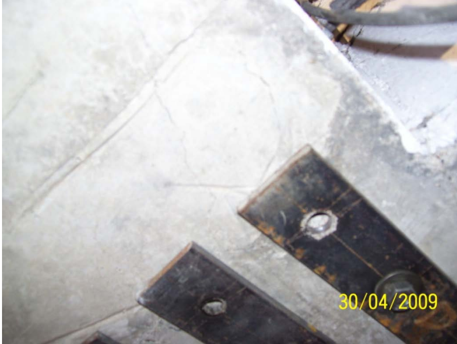
Resim 3.32. E1 elemanında sıyrılan somunların dış kenardan görünüşü
