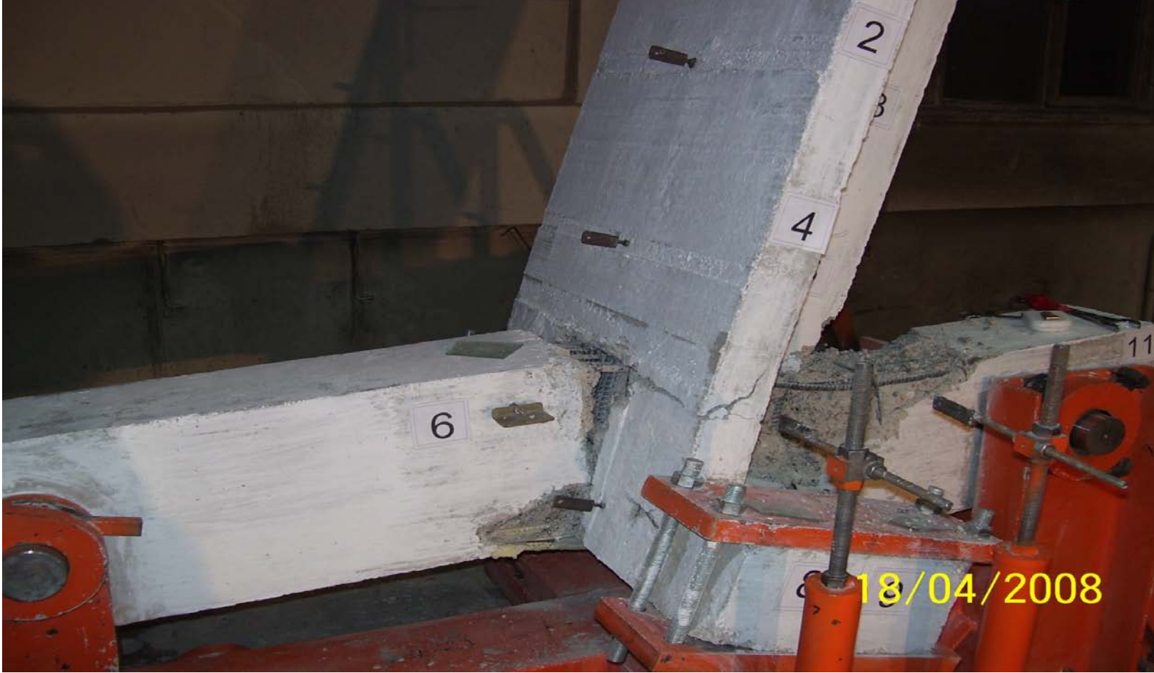
Resim 4.8. WC1b elemanında üst kolon, düğüm ve alt kolon hasarı
