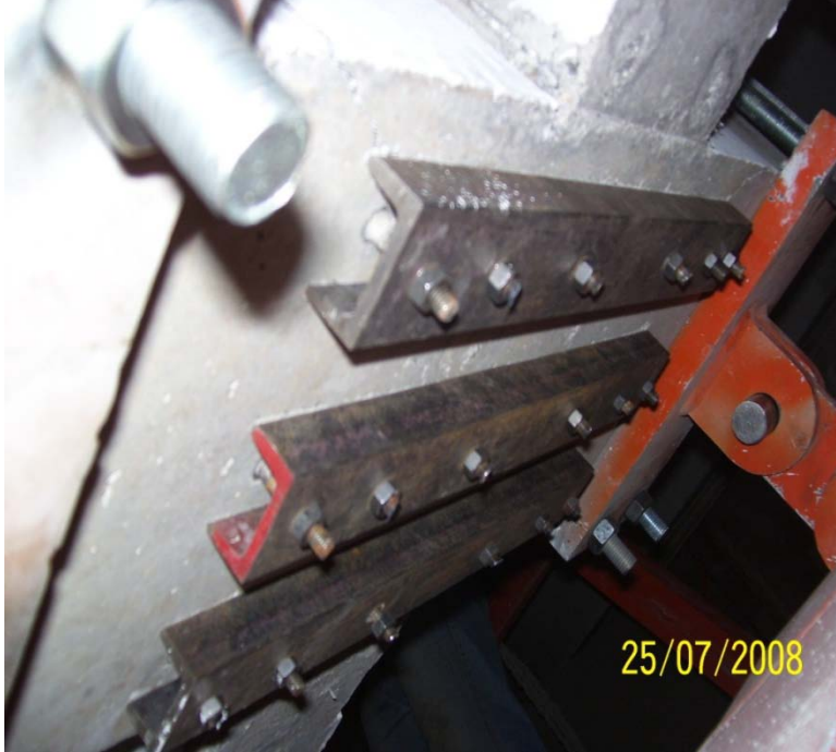
Resim 3.22. B1 güçlendirmesinde düğüm bölgesinin dış cepheden görünüşü
