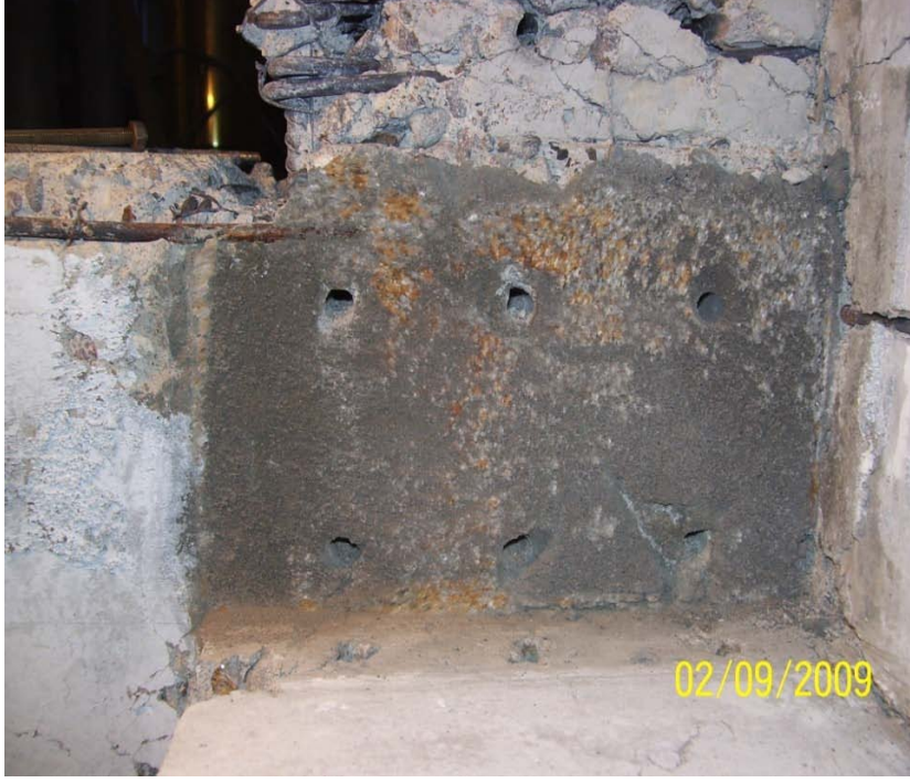
Resim 3.41. G2 güçlendirmesinde kabuk betonu ve çelik plaka kaldırıldıktan sonra düğüm bölgesi ön yüz görünüşü
