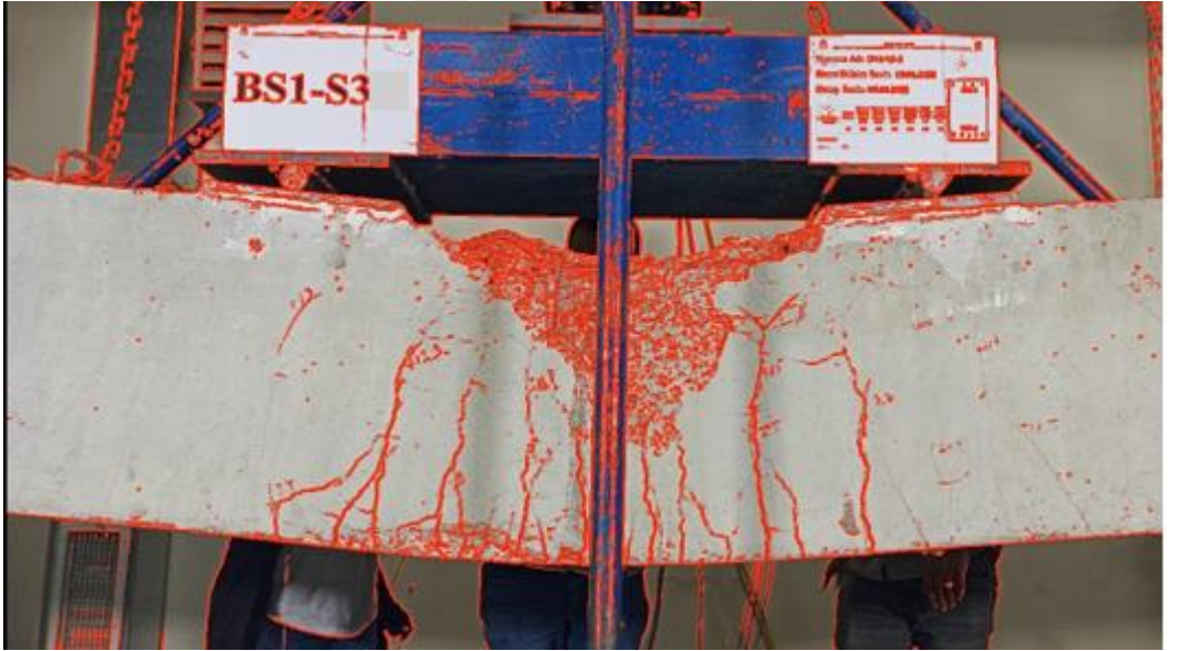
Şekil 53. BS1-S3-2 kirişi orta bölgesi vurgulu çatlak hasarı fotoğrafı
