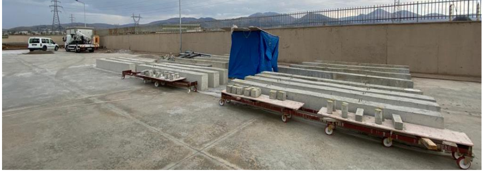
Şekil 3.16. Atmosfere açık koşullarda bekletilen betonarme kirişler
