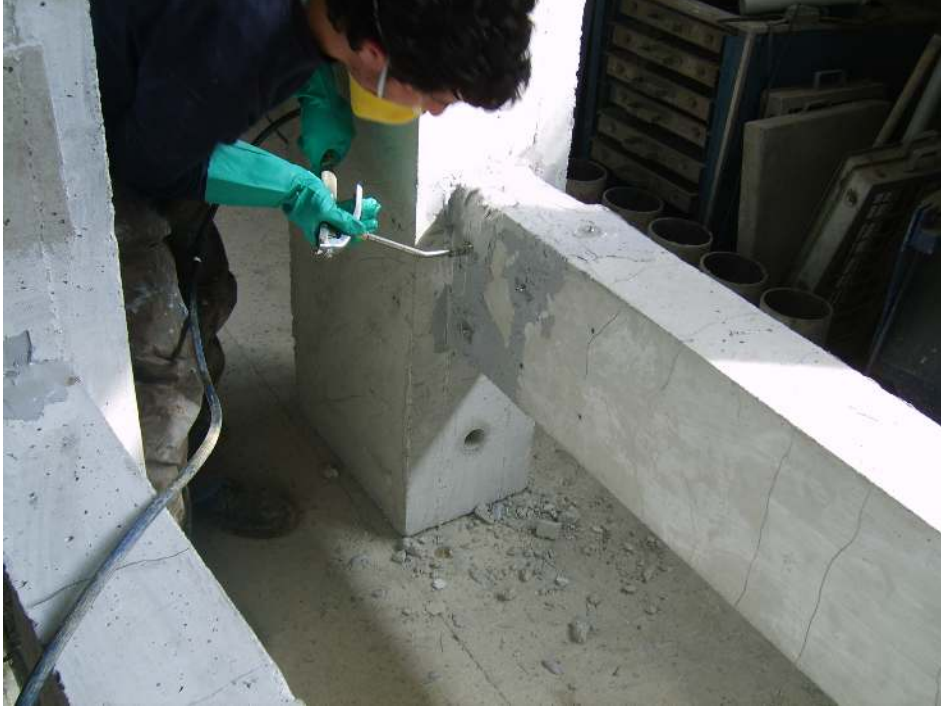
Resim 3.11. Epoksi enjeksiyonu
