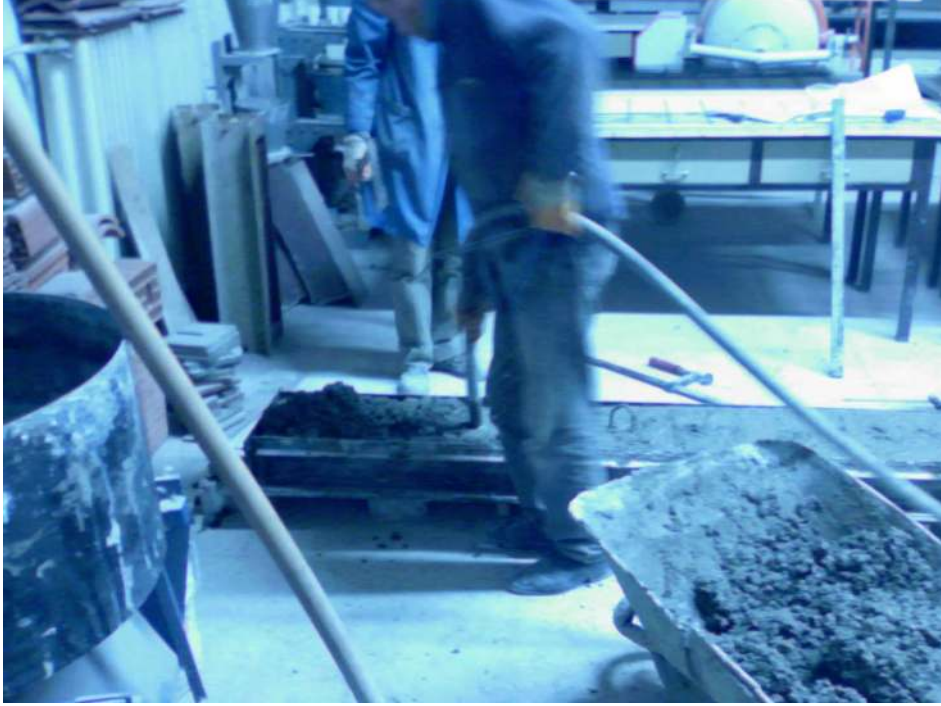
Resim 3.3. Beton dökülmesi
