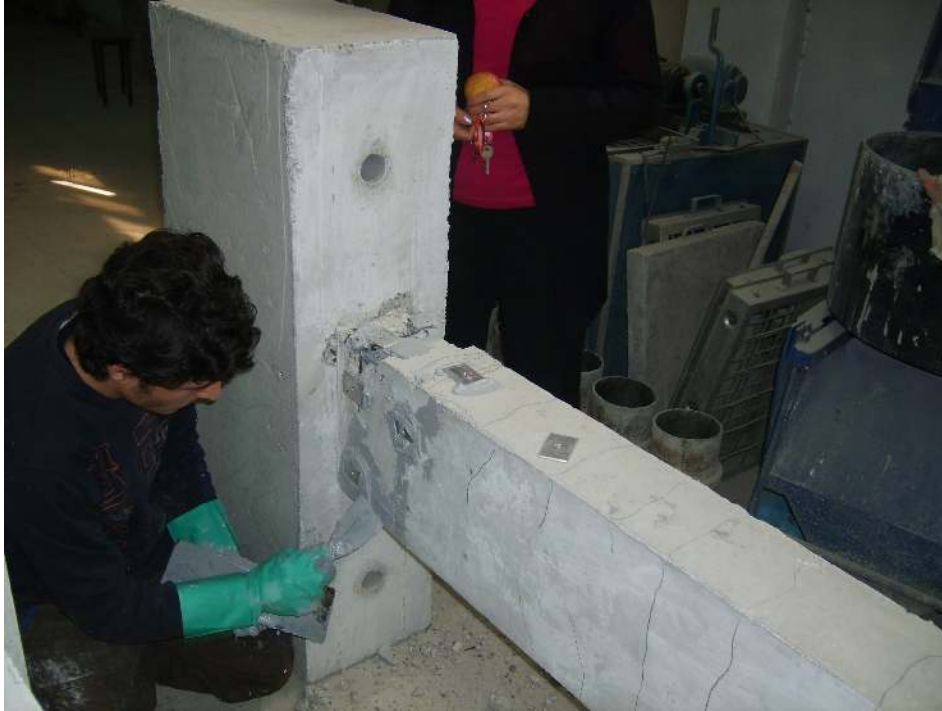
Resim 3.10. Enjeksiyon plakalarının yerleştirilmesi
