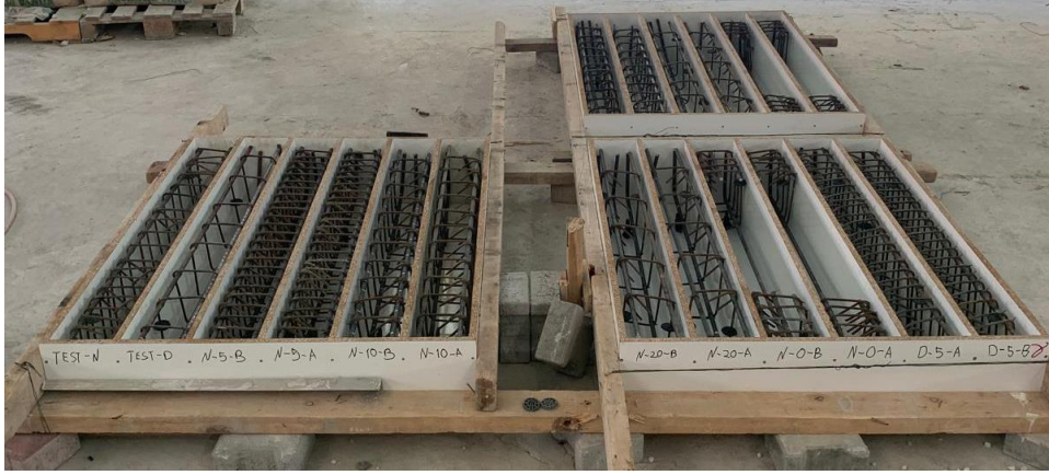
Şekil 3.6. Donatı kafeslerinin kalıplara yerleştirilmesi
