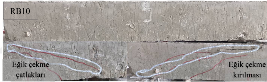
Şekil 4.6. RB10 referans kiriş numunesine ait göçme sonrası hasar detayları
