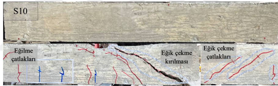
Şekil 4.45. S10 kiriş numunesine ait göçme sonrası hasar detayları
