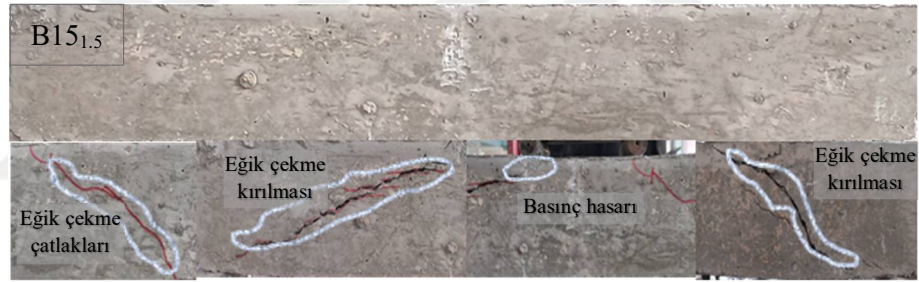
Şekil 4.33. B15_{1.5} kiriş numunesine ait göçme sonrası hasar detayları
