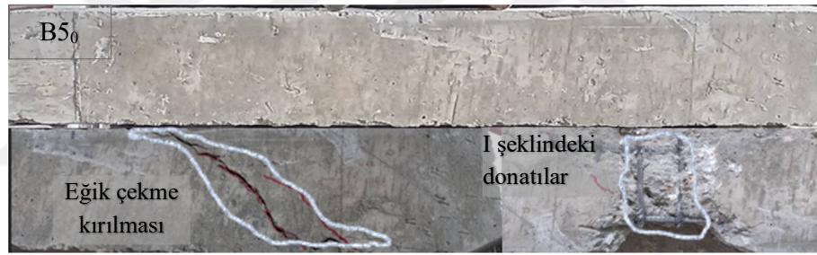
Şekil 4.12. B5 0 kiriş numunesine ait göçme sonrası hasar detayları
