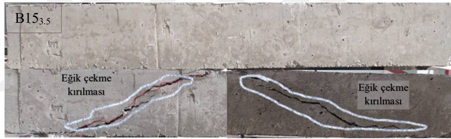
Şekil 4.36. B15 3.5 kiriş numunesine ait göçme sonrası hasar detayları
