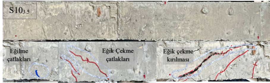
Şekil 4.48. S10 3.5 kiriş numunesine ait göçme sonrası hasar detayları
