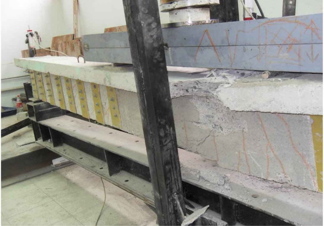
Resim 3.10. Tabla betonunda ezilme, deney elemanı 5
