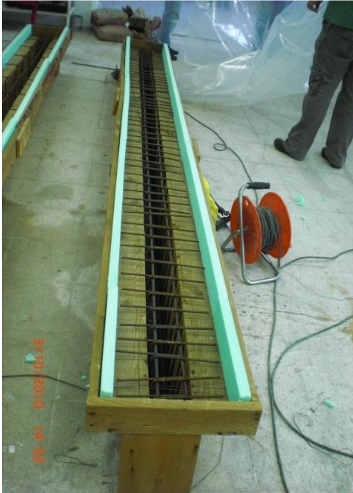
Resim 2.2. Donatı kafesi yerleştirilmiş deney elemanı 1
