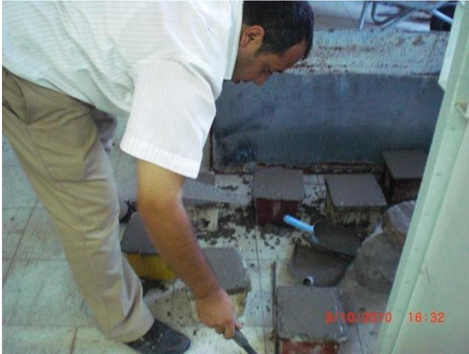
Resim 2.1. Beton numunesi alınması
