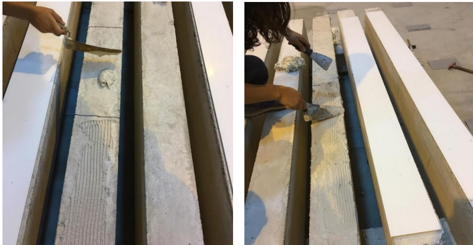
Şekil 3.17. Honeycomb panellerin Sikadur-31 ile kiriş yüzeyine yapıştırılması
