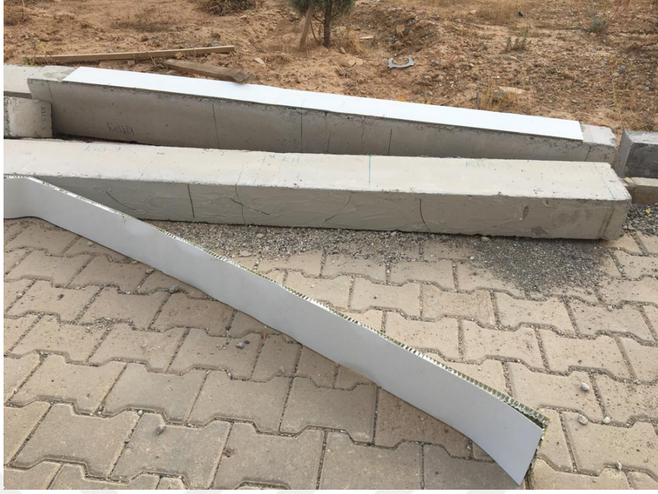
Şekil 4.18. Deney sonrası honeycomb panelin (Panel 3) kiriş yüzeyinden kaldırılması
