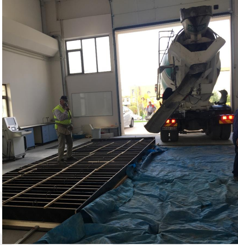
Şekil 3.9. Beton dökümü öncesi hazırlık aşaması
