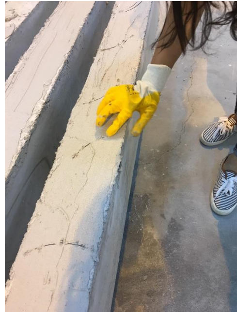
Şekil 3.15. Hazırlanan Sikadur-31 epoksi yapıştırıcının kiriş yüzeyine sürülmesi
