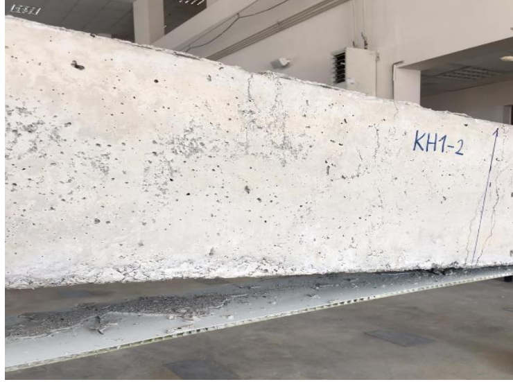
Şekil 4.10. Honeycomb panelin kiriş yüzeyinden ayrılması
