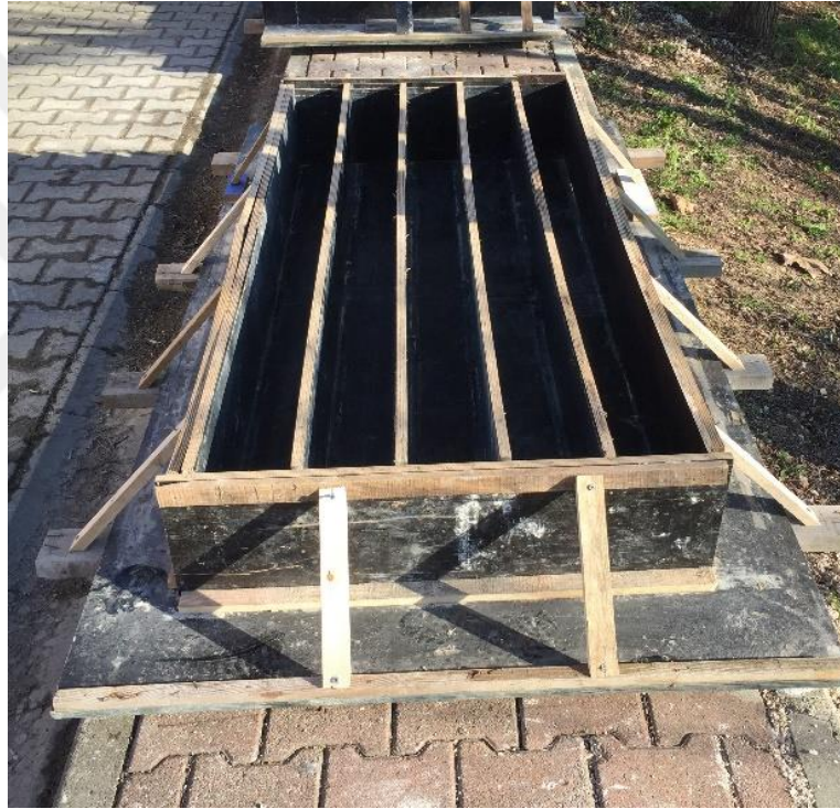
Şekil 3.11.Kiriş numuneleri için üretilen kalıp sistemi
