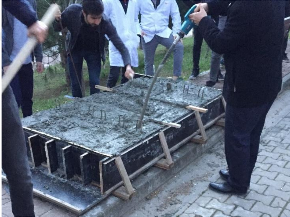
Şekil 3.14. Beton yerleştirme işlemi
