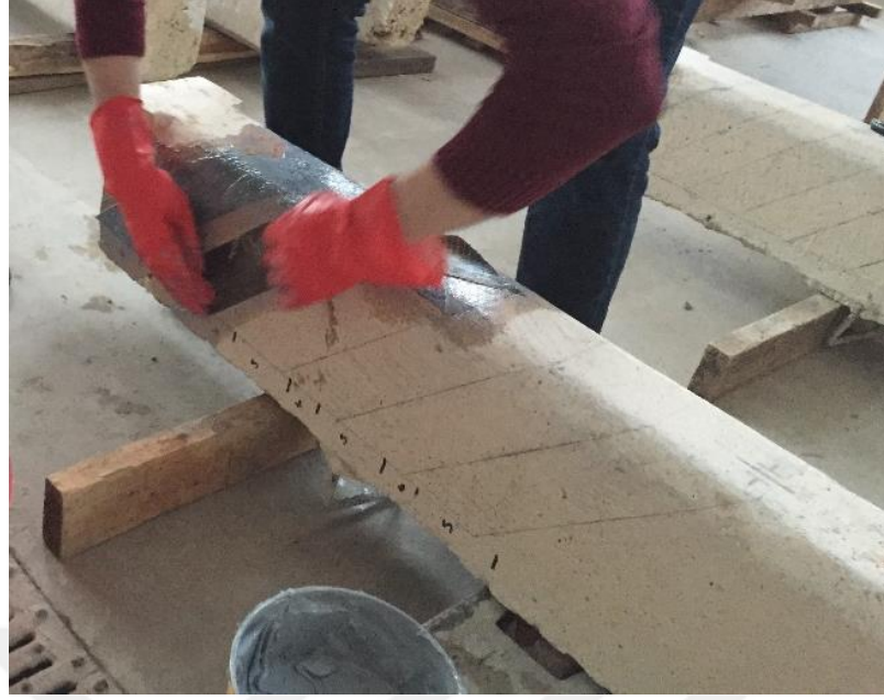
Şekil 3.20. BFRP şeritlerin yapıştırılması
