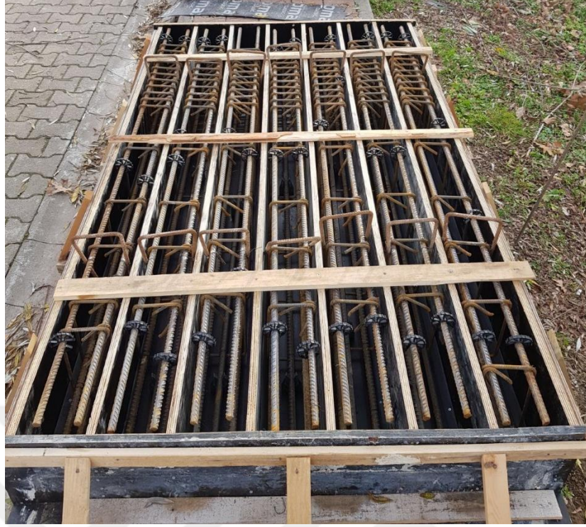
Şekil 3.12. Beton dökümünden önce kalıp ve donatı görünümü
