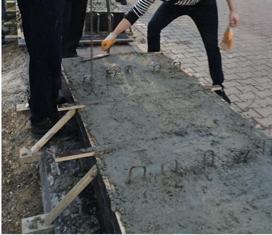
Şekil 3.15. Beton yüzeyi tesviye işlemi
