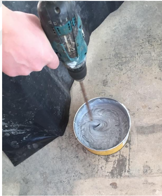
Şekil 3.18. Epoksi karıştırma işlemi
