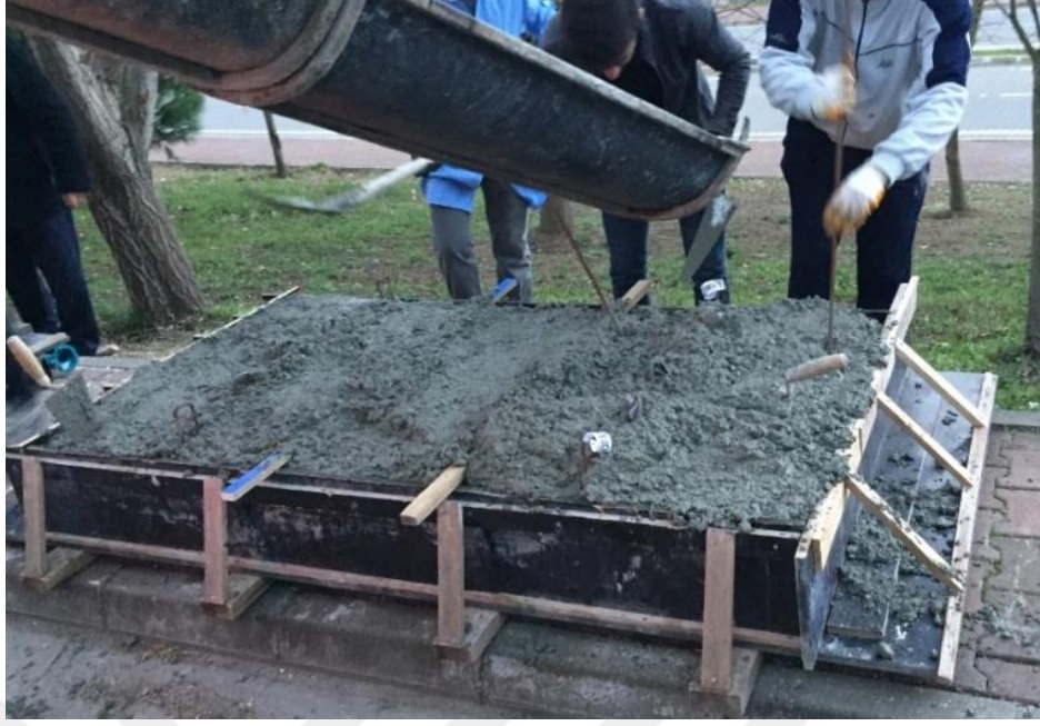
Şekil 3.13. Beton dökümü işlemi
