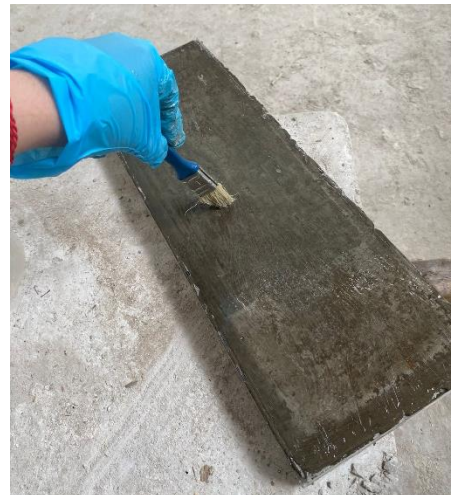
Şekil 3.27 Kiriş ve blok yüzeylerine epoksi astarının uygulanması
