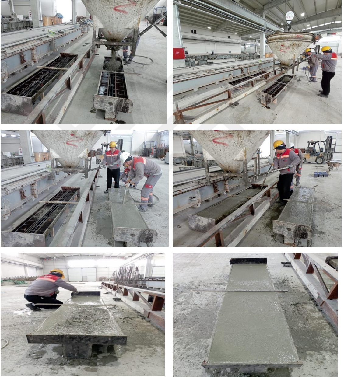
Şekil 3.13 Beton döküm aşamaları
