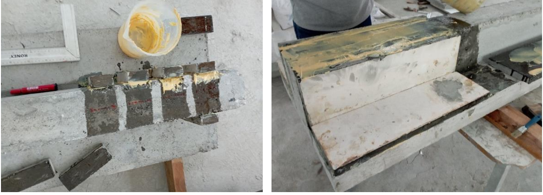
Şekil 3.29 Lifli özel blokların ve panellerin yüksek mukavemetli epoksi ile tablalı kiriş yüzeylerine yapıştırılması
