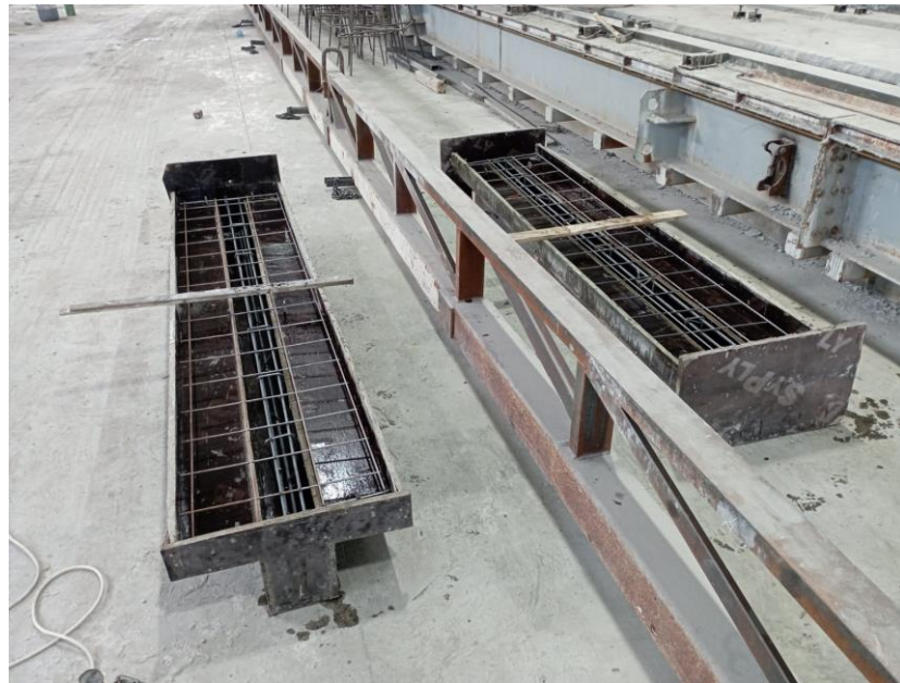
Şekil 3.12 Donatıların kalıplara yerleştirilmesi
