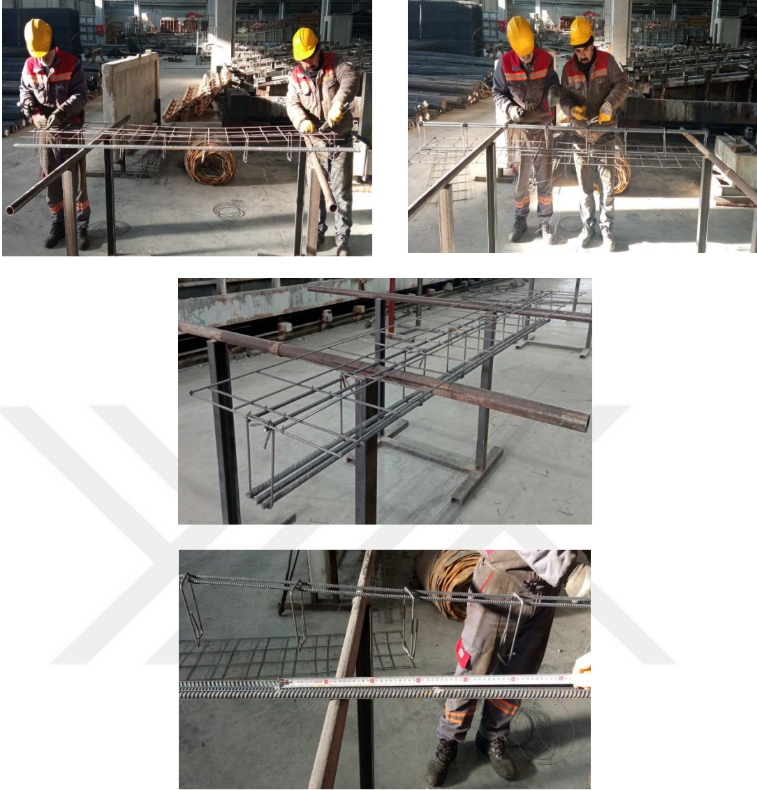
Şekil 3.6 Betonarme kirişlerin donatı iskeleti
