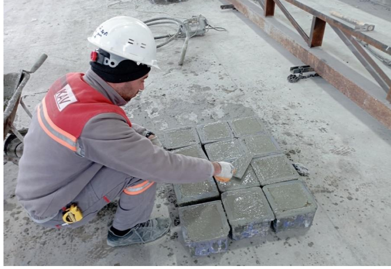
Şekil 3.3 Kirişlerin beton dökümü esnasında alınan küp numuneler
