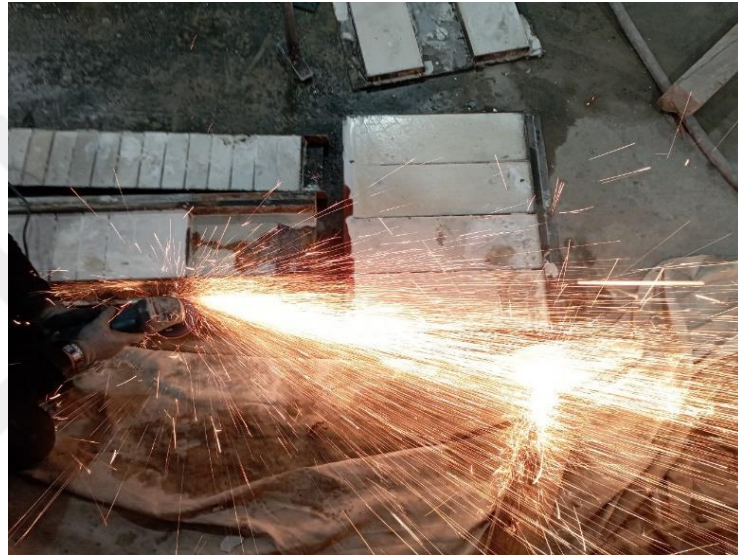
Şekil 3.20 Lifli özel blokların ve panellerin kalıplardan söküm işlemi
