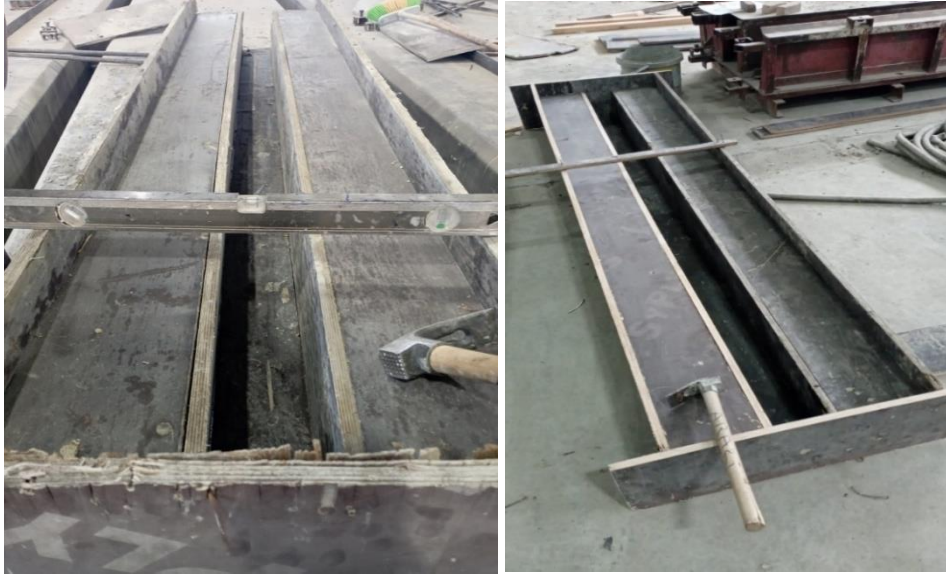
Şekil 3.11 Tablalı kiriş kalıplarının hazırlanması
