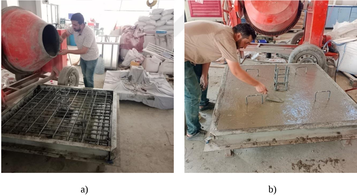
Şekil 3.17: Büyük ölçekli döşeme-kolon birleşim elemanları için beton dökümü.
