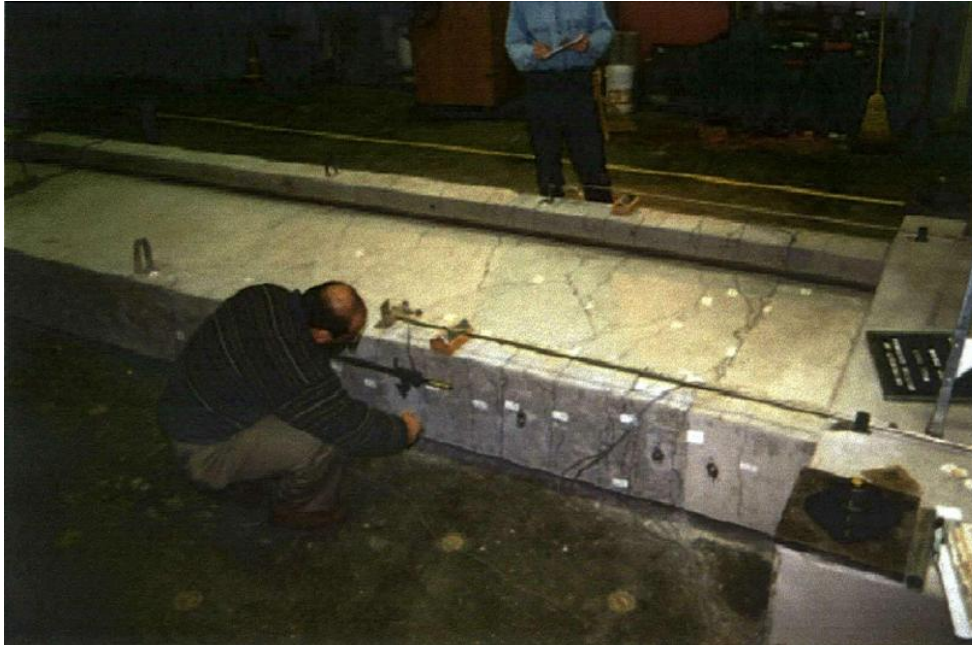
Şekil 5.1. Perdede oluşan çatlaklar (İbrahim, 2000)
