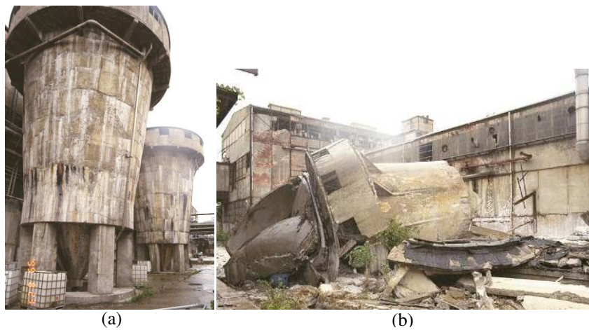
Şekil 1.20. 1999 Kocaeli depreminde SEKA kağıt fabrikasındaki hasarsız (a) ve hasarlı(b) silolardan birer görünüm (Sezen vd. 2000)
