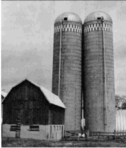
Şekil 1.16. Çakışan basınç soğanları bölgesinde düzgün olmayan oturmadan dolayı çarpışan ikiz silolardan bir görünüm (Bozozuk 1976, ASCE)
