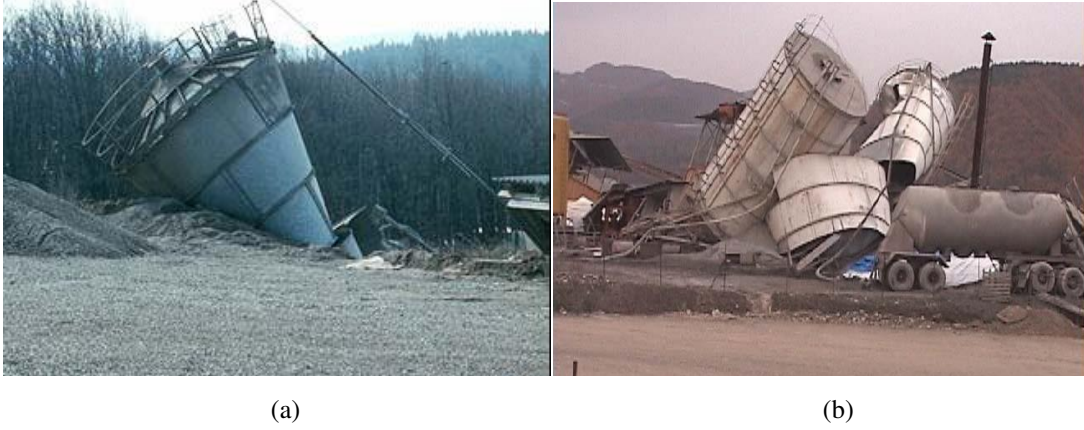
Şekil 1.19. 1999 Düzce depreminde yıkılan silolar (a), (b) (Xiao ve Yaprak 1999, GESS 1999)
