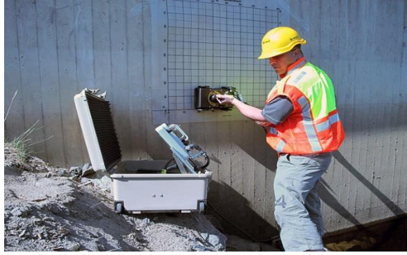
Şekil 1.3. YNR ile korozyon tespiti
