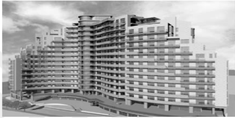
Şekil 3.10 Sismik izolasyonlu Dzorap Binası (İlerisoy vd., 2019)
