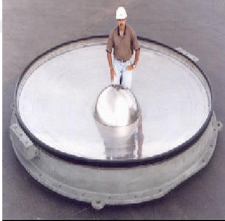
Şekil 4.26 Benicia-Martinez Köprüsü' nde uygulanan sürtünmeli sarkaç mesnetinin açık hali (Uz, 2007)
