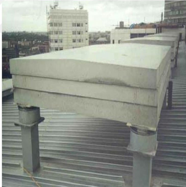
Şekil 4.16 Ayarlı kütle sönümleyici (TMD) tipleri (Özpalanlar, 2004)
