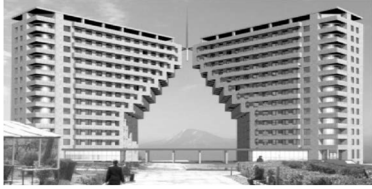
Şekil 3.9 Sismik izolasyonlu Northern Ray Binası (İlerisoy vd., 2019)
