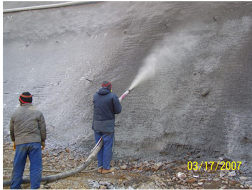
Şekil 3.2. Püskürtme beton uygulaması
