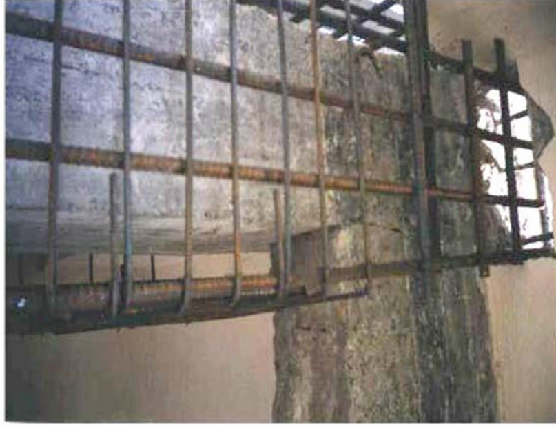
Şekil 3.12. Kiriş mantolanmasında donatılarda sürekliliğin sağlandığı bir kiriş
