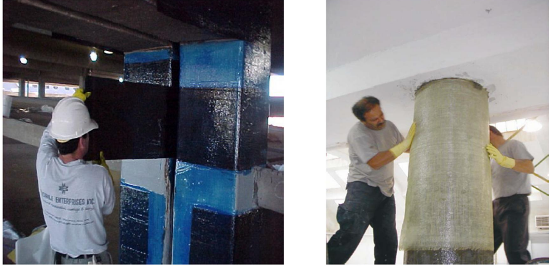
Şekil 3.10. Kolonun lifli polimer (LP) ile sarılması
