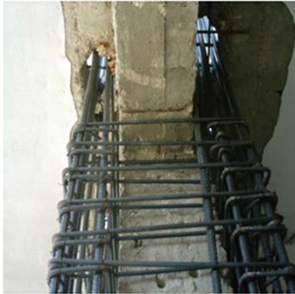
Şekil 3.4. Kolonun betonarme ile mantolanması uygulaması
