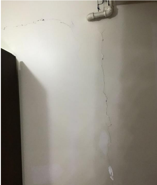
Şekil 5.8. İstanbul (Silivri) depremi sırasında meydana gelen yapısal olmayan eleman hasarları
