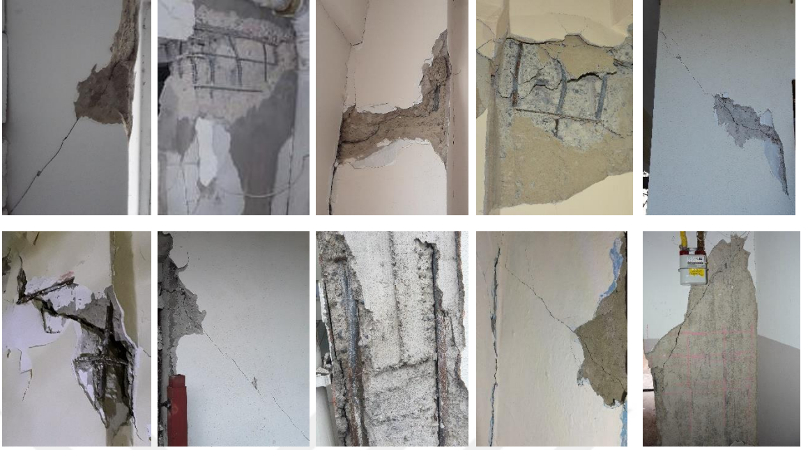
Şekil 5.59. Veri setinde kullanılan kolon hasarı görüntüleri örnekleri
