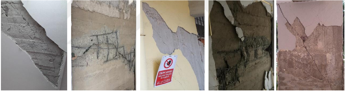
Şekil 5.60. Veri setinde kullanılan perde hasarı görüntüleri örnekleri
