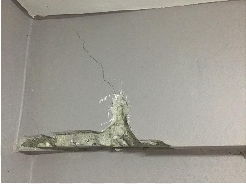
Şekil 5.7. İstanbul (Silivri) depreminde hasar alan kolon (a), İstanbul (Silivri) depreminde hasar alan kiriş (b)
