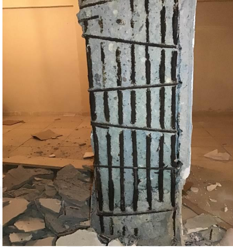
Şekil 5.9. Korozyon hasarları
