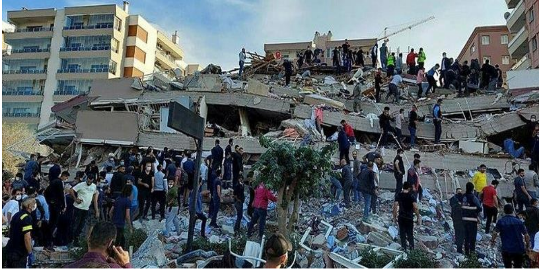
Şekil 5.40. Yıkılan yapıların görüntüleri
