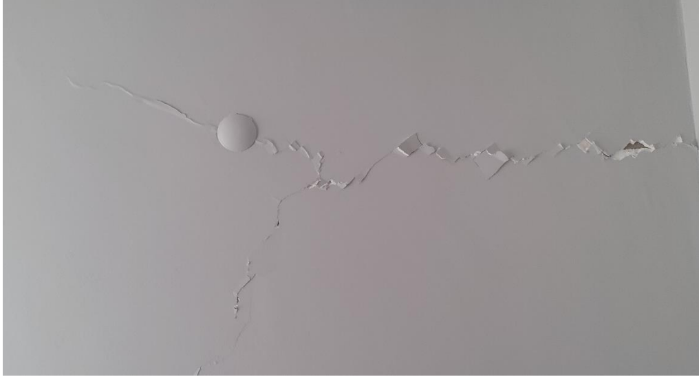
Şekil 5.56. Dolgu duvar ile taşıyıcı sistem arasında oluşan sıva çatlakları(a), tesisat boşlukları nedeniyle oluşan sıva çatlakları (b)
