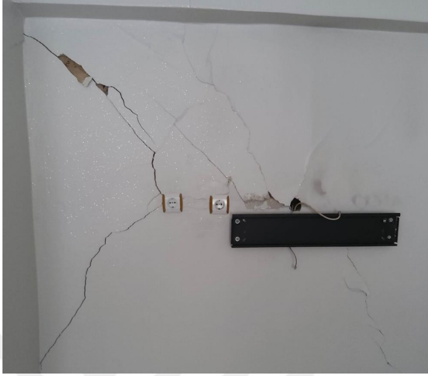
Şekil 5.31. Dolgu duvar ile taşıyıcı sistem çerçevesi arasında oluşan sıva çatlağı (a); tesisat boşluğu dolayısıyla oluşan sıva çatlağı (b)
