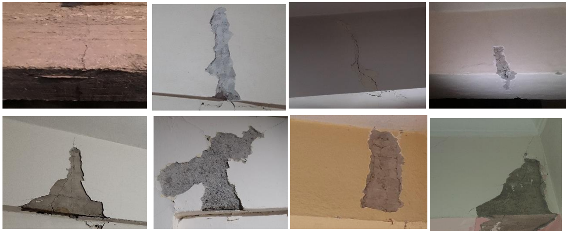
Şekil 5.58. Veri setinde kullanılan kiriş hasarı görüntüleri örnekleri
