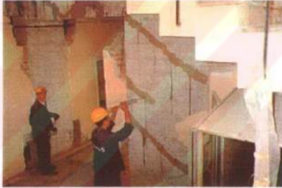
Şekil 7.17-İzo-BTS ve Epoksi Kaplama ile Tamir
