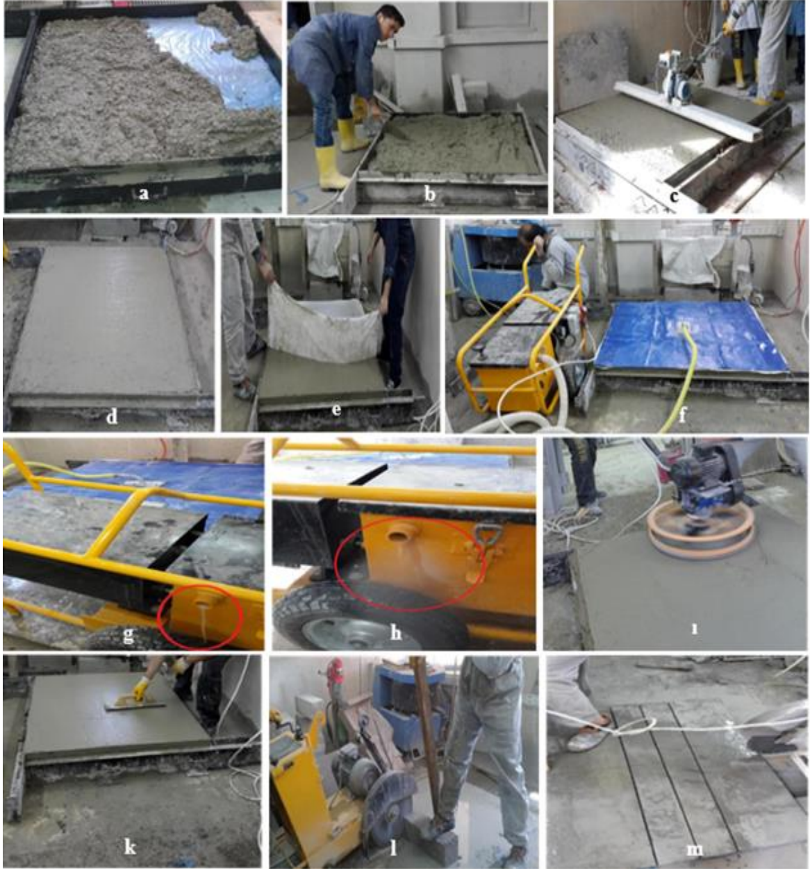
Şekil 3.3. Vakumlu beton üretimi
