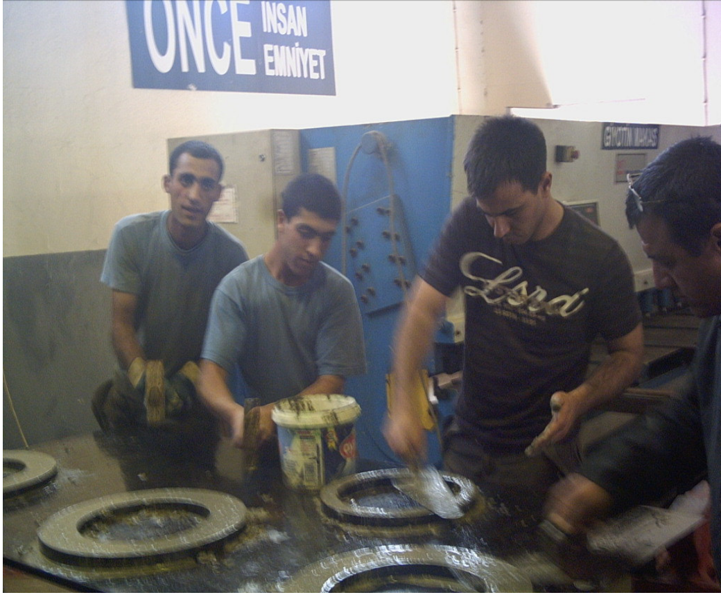
Resim 7.9. Karışımın kalıplara yerleştirilmesi
