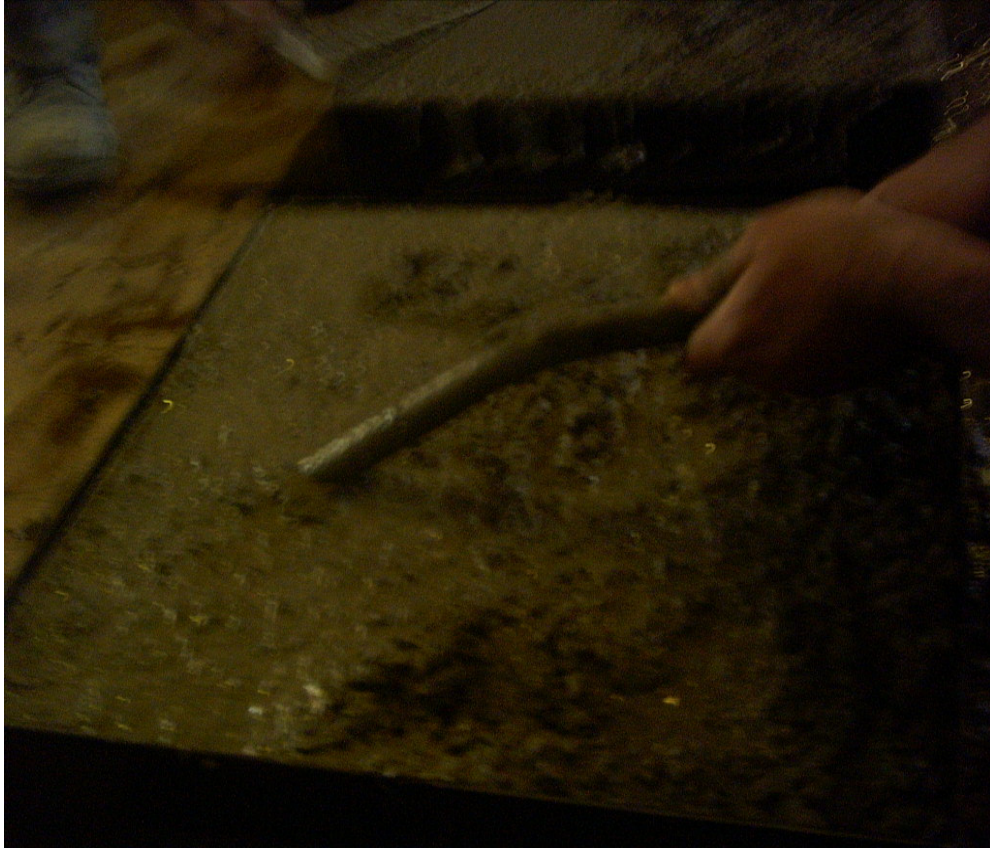
Resim 7.5. Beton numune dökümünde vibratör kullanımı
