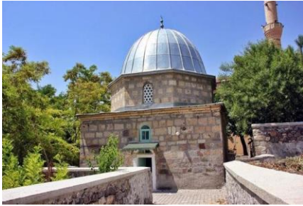
Karadavut Türbesi Dış Görünüm
