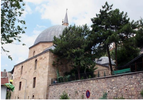
Kurşunlu Cami Dış Görünüm
