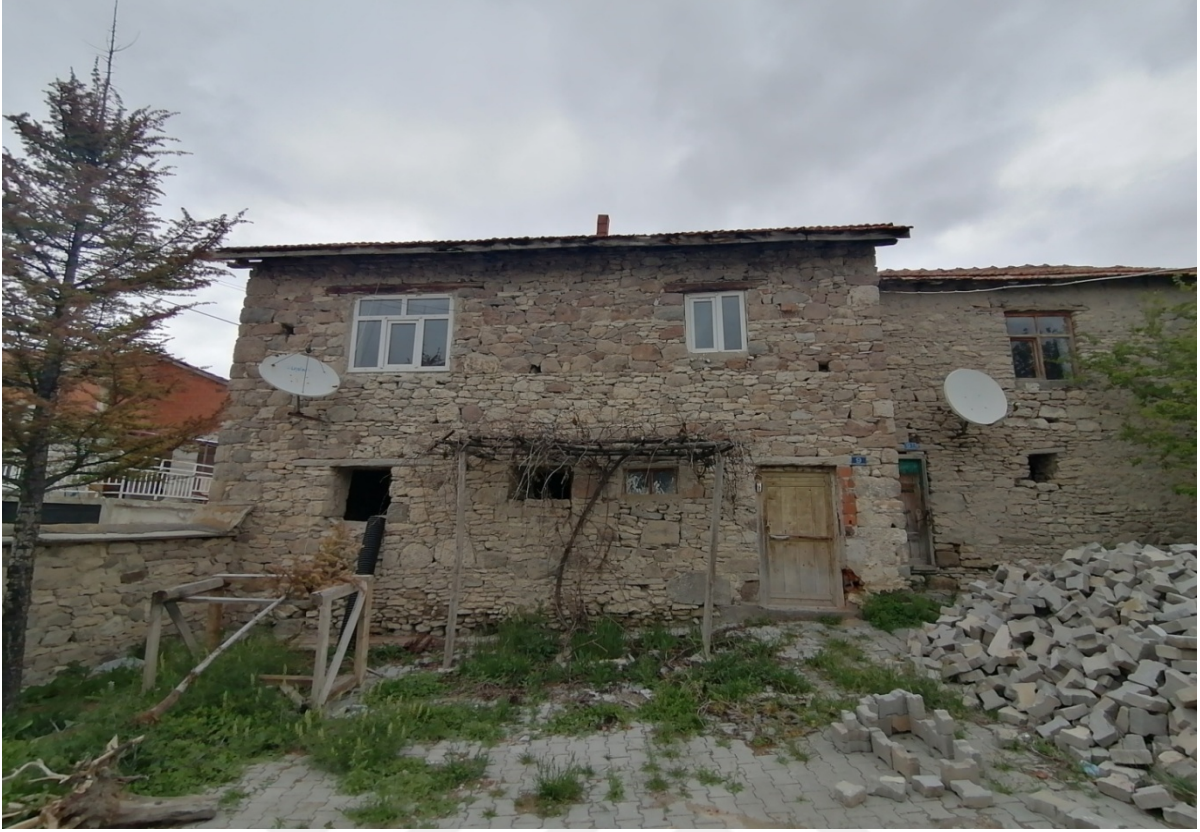
Fotoğraf 2.43. İmamların Odası Giriş Cephesi Genel Görünüş
