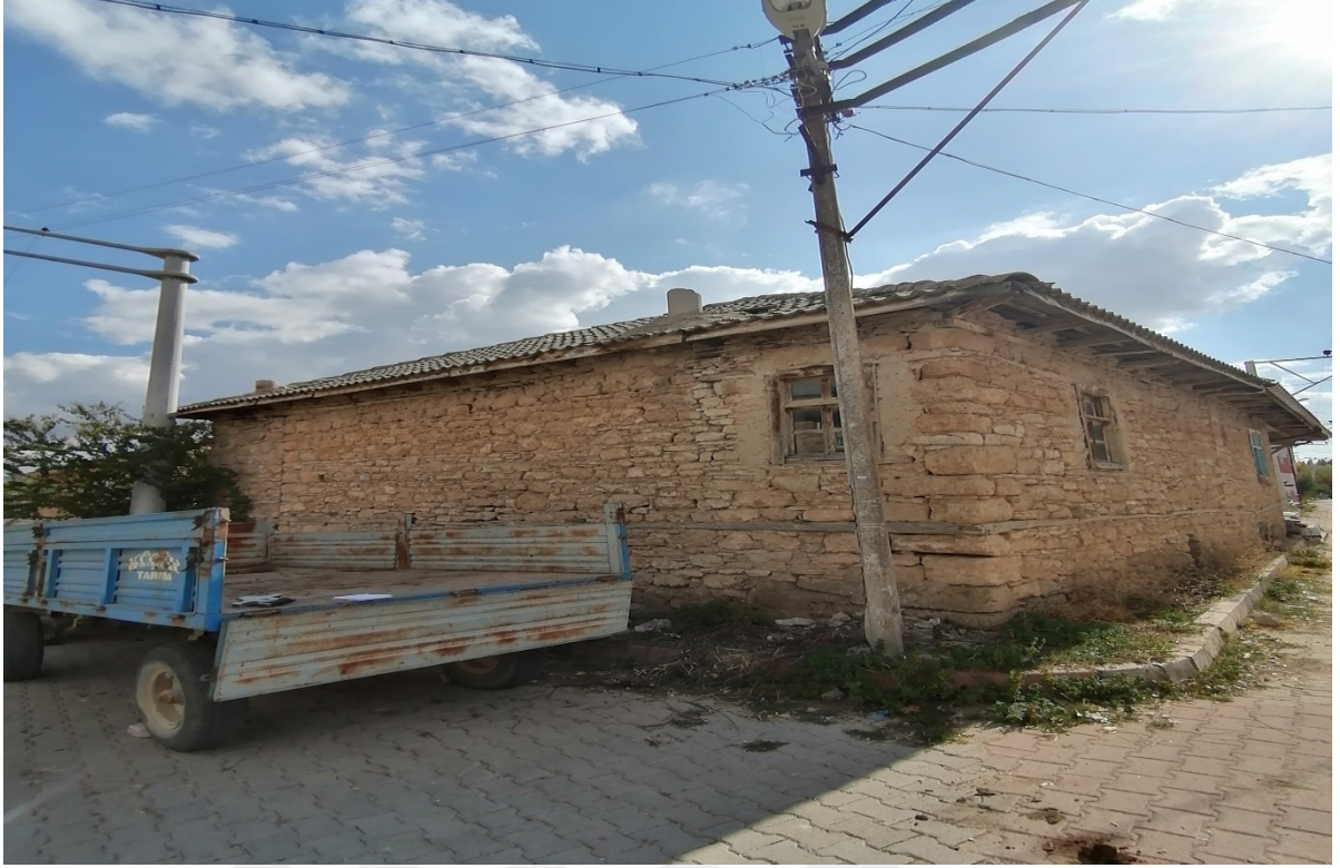
Fotoğraf 2.24. Kara Ömer Odası Kuzey Cephesi Genel Görünüş
