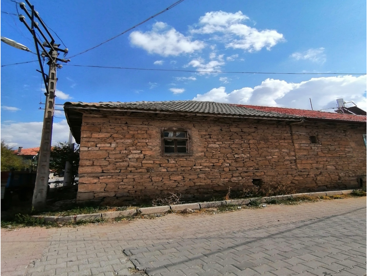
Fotoğraf 2.25. Kara Ömer Odası Batı Cephesi Genel Görünüş
