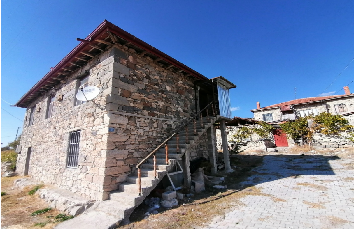
Fotoğraf 2.40. Çivril Köy Odası Genel Görünüş
