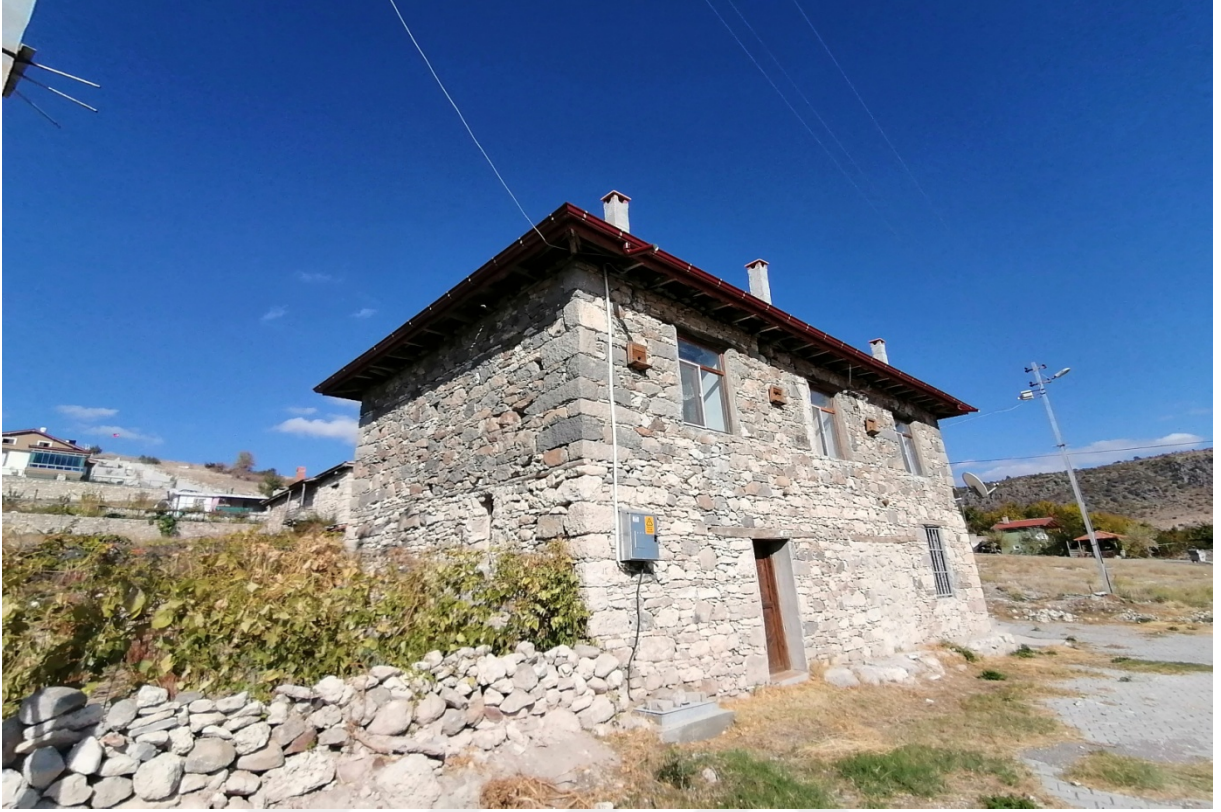
Fotoğraf 2.39. Çivril Köy Odası Genel Görünüş
