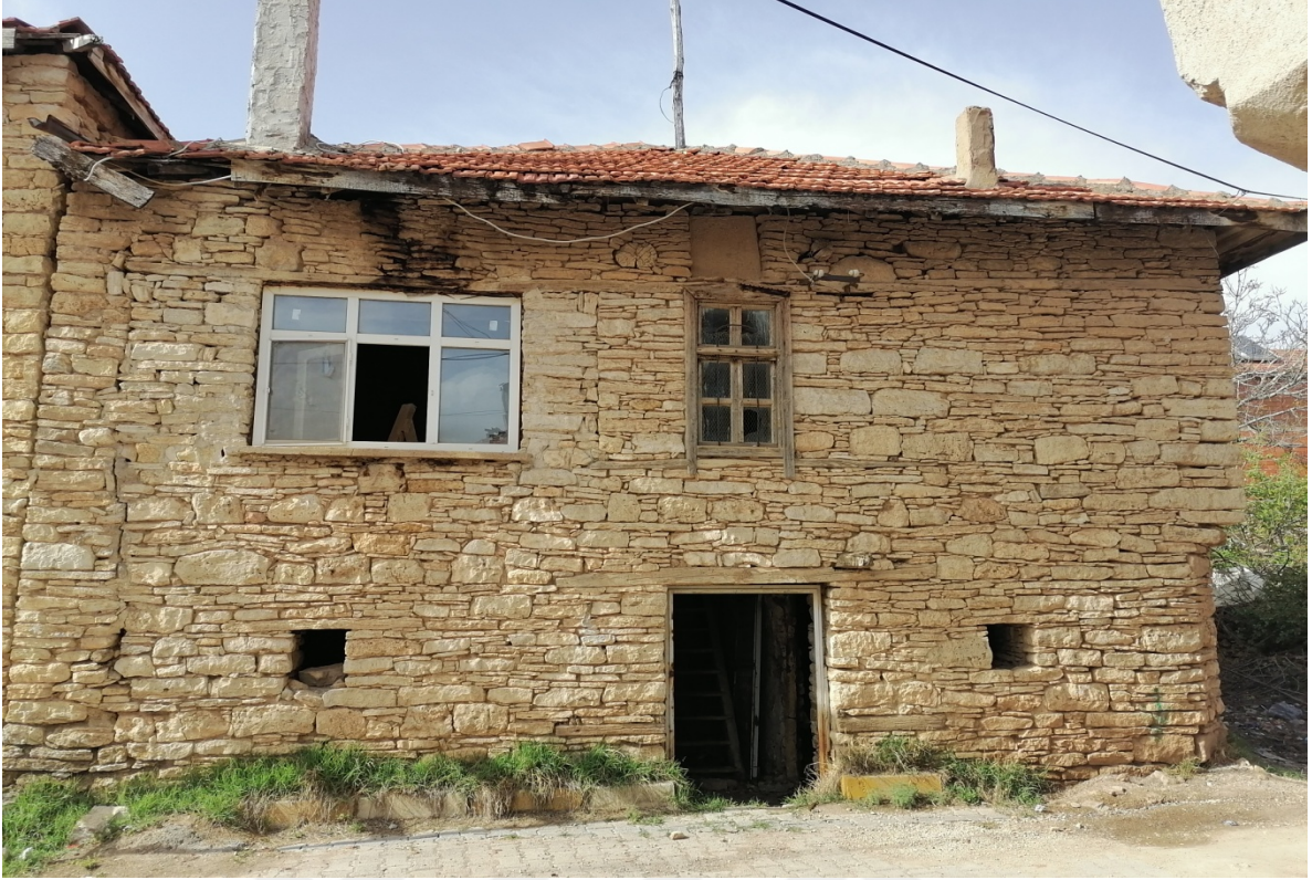
Fotoğraf 2.66. Karaböcüler Odası Giriş Cephesi Genel Görünüş
