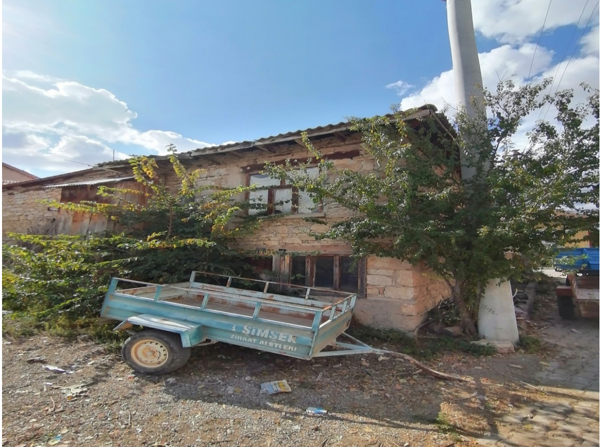
Fotoğraf 2.23. Kara Ömer Odası Giriş Cephesi Genel Görünüş
