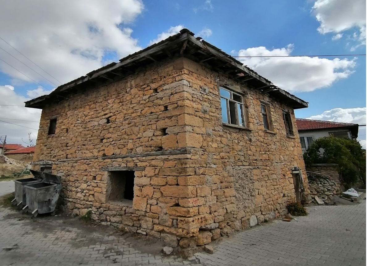
Fotoğraf 2.31. Eyüp Ağa Odası Kuzeybatı Cephesi Genel Görünüş
