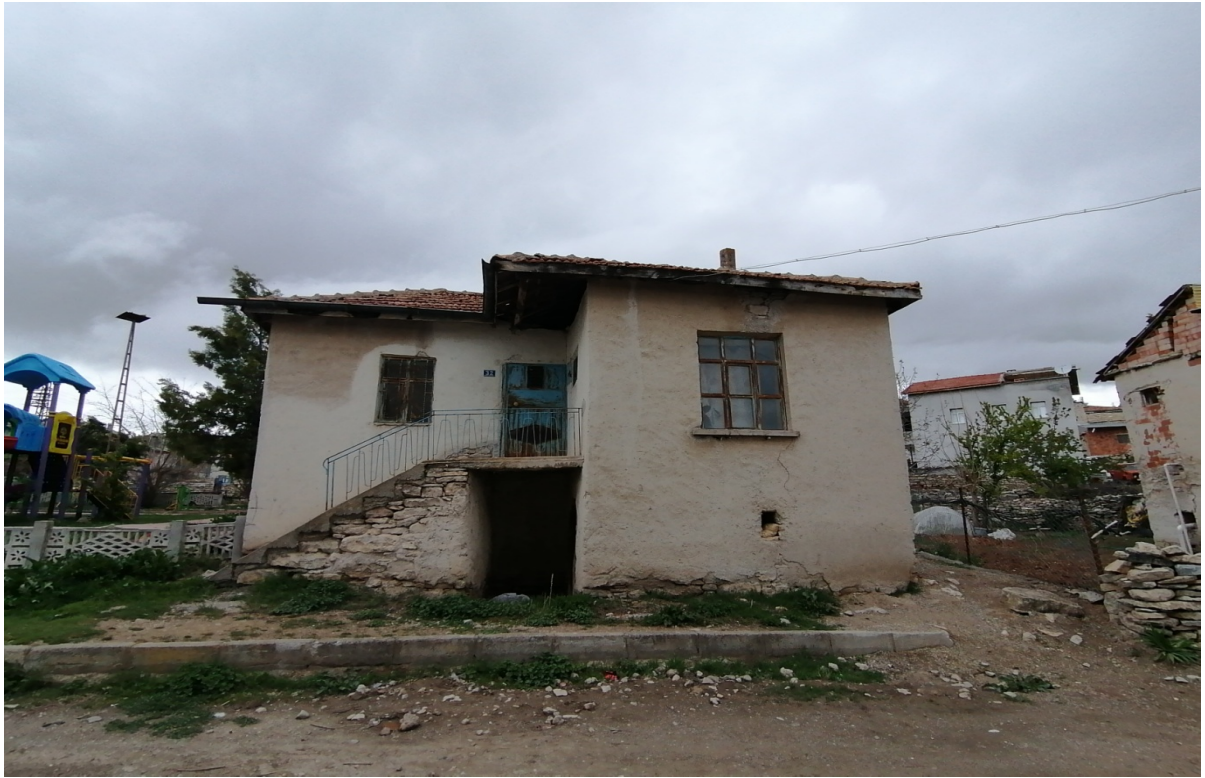
Fotoğraf 2.63. Kel İbrahim Odası Giriş Cephesi Genel Görünüş
