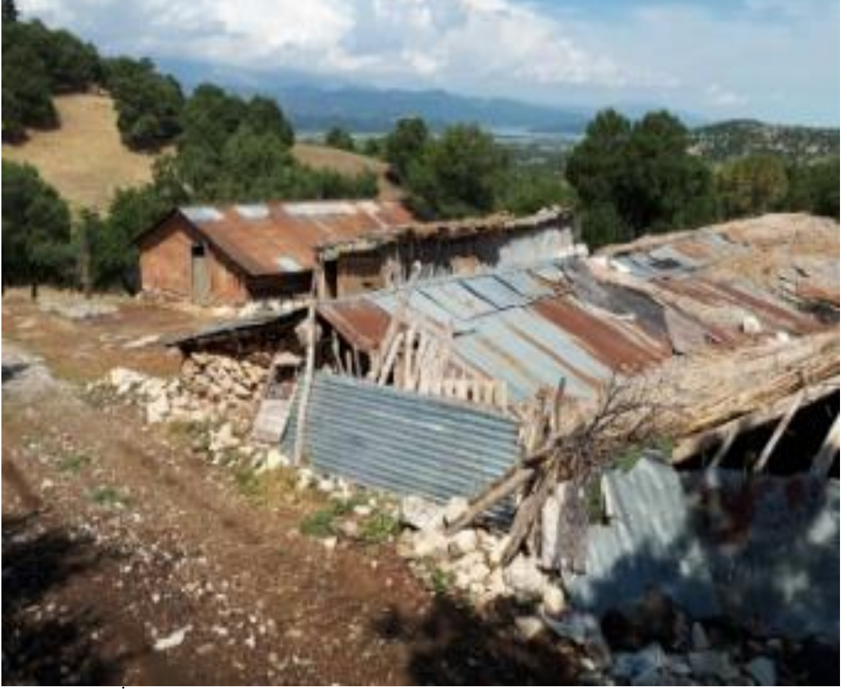
Fotoğraf 4.83: İvrin Ağılı Mesken ve Eklentilerinin Çatılarında Çoğunlukla Saç Malzeme Kullanılmıştır
