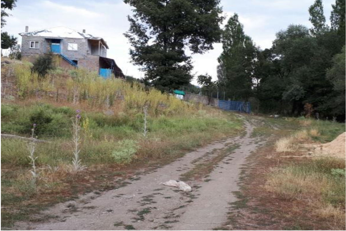
Fotoğraf 4.79: Aldede(Elmalıpınar) Ağılı Stabilize Yolu Kış Aylarında Kayganlaşır ve Ulaşımı Olumsuz Etkiler
