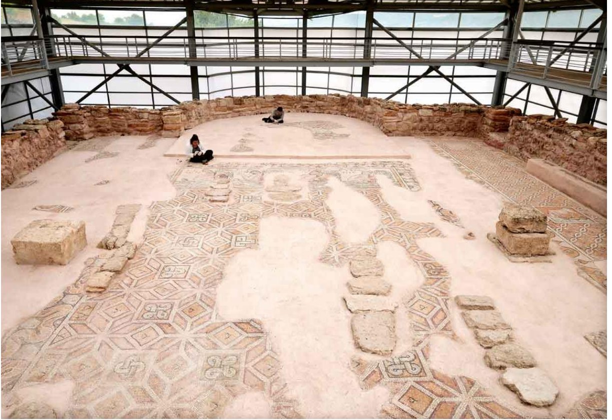
Resim 9: Karabük İli'ndeki Hadrianapolis Kilise B mozaiklerinin yerinde korunması ve dışarıdan daha rahatça görülebilmesi için yapılmış geçici çatı.
