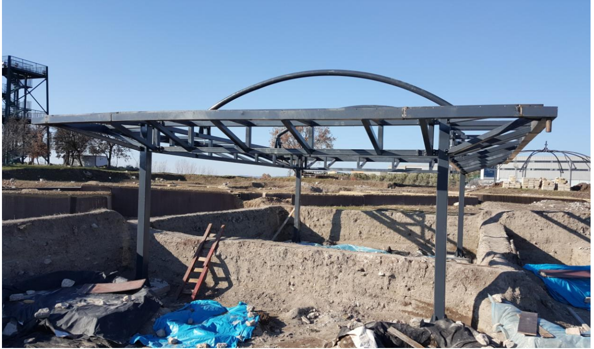
Resim 20: Üst örtü sisteminin metal iskeleti
