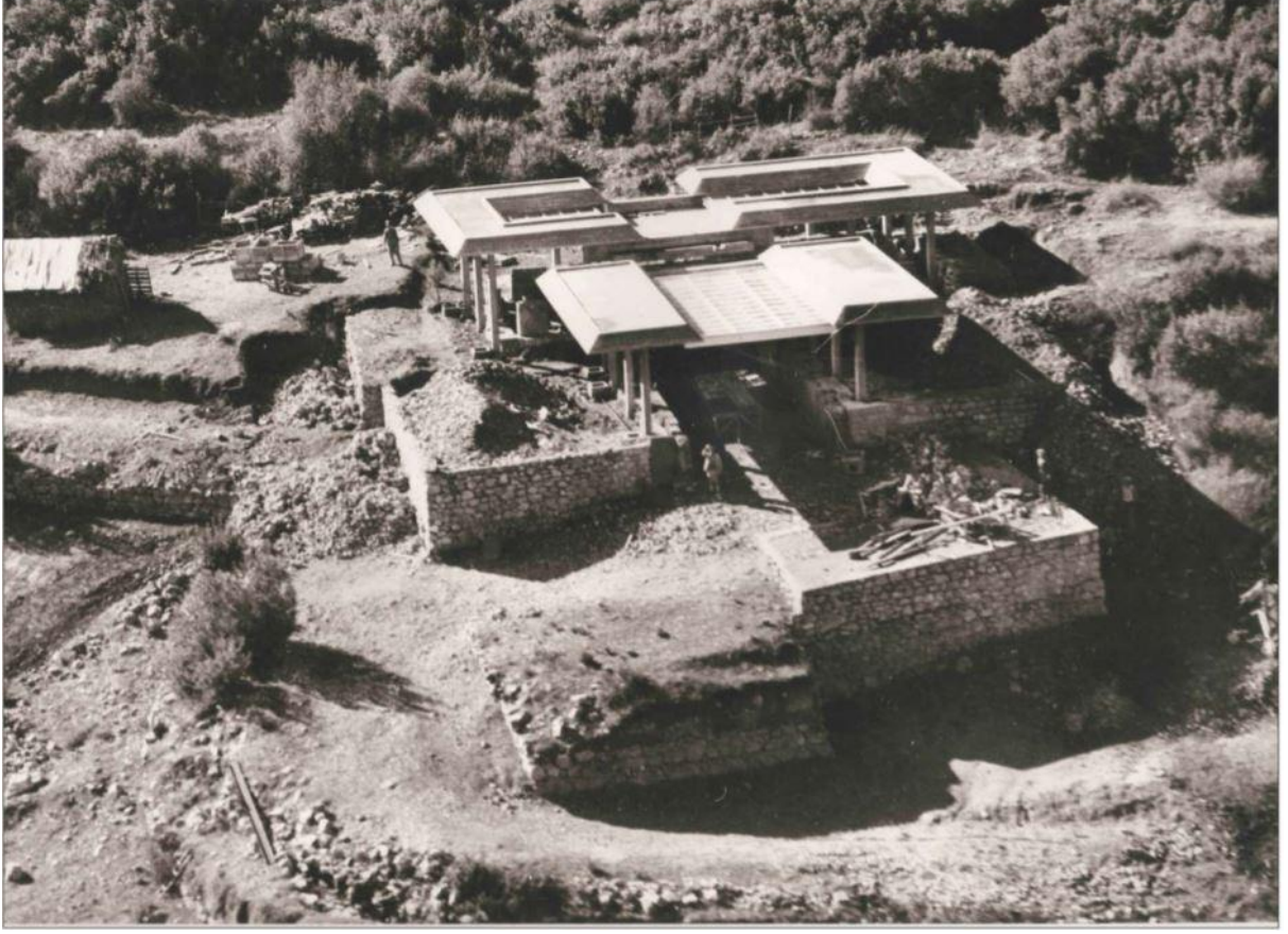
Resim 13: Karatepe-Aslantaş'da “ Turgutun saçakları ” diye tanınan üst örtü koruma çatısı uygulama projesi (kuzey kapı).
