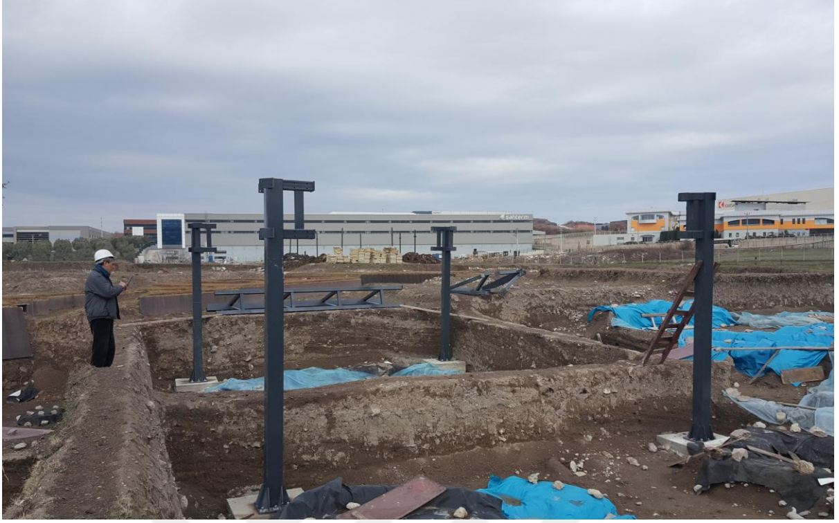
Resim 19: Üst örtü sistemini taşıması için dikilen dört adet metal ayak.
