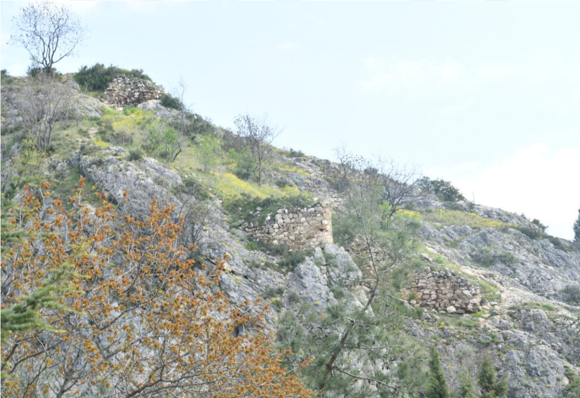
Resim 44: Belekoma Kalesi'nin günümüzdeki mevcut durumu.
