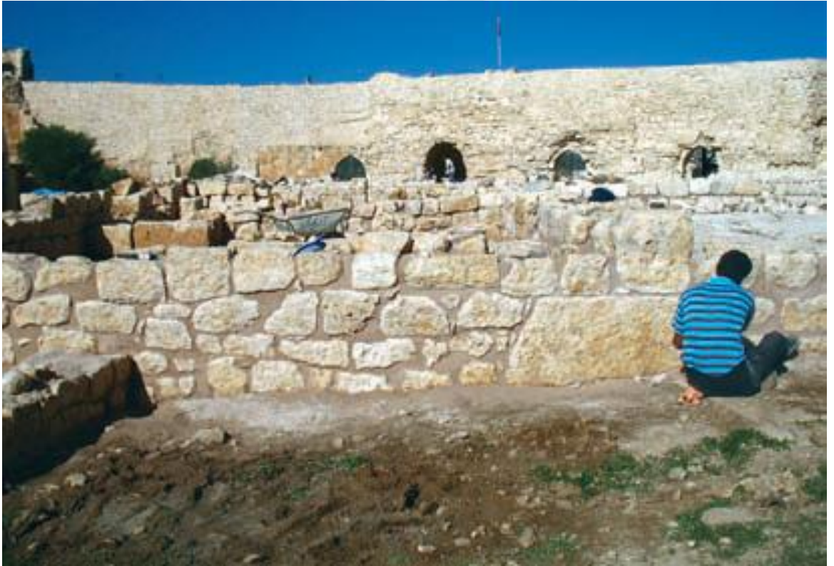
Resim 2: Mersin Kız Kalesi’ndeki kilise duvarının restorasyon çalışması.
