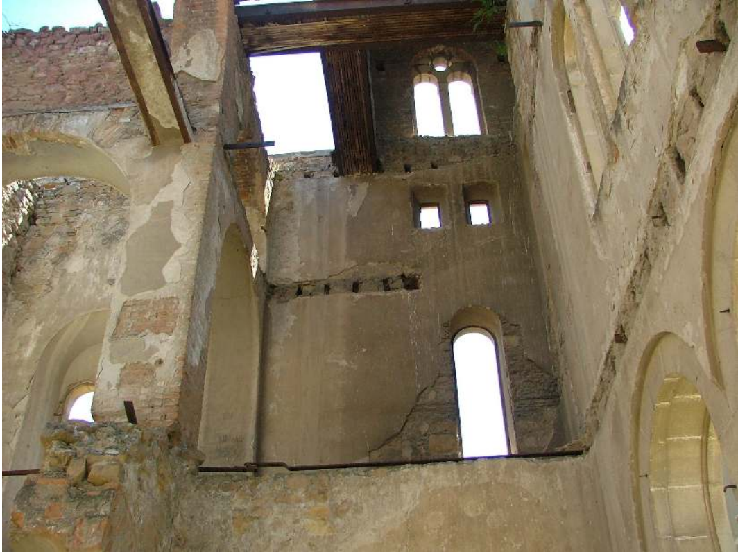
Resim 3.48 Sağ kuleye çıkan merdiven ve döşeme izleri
