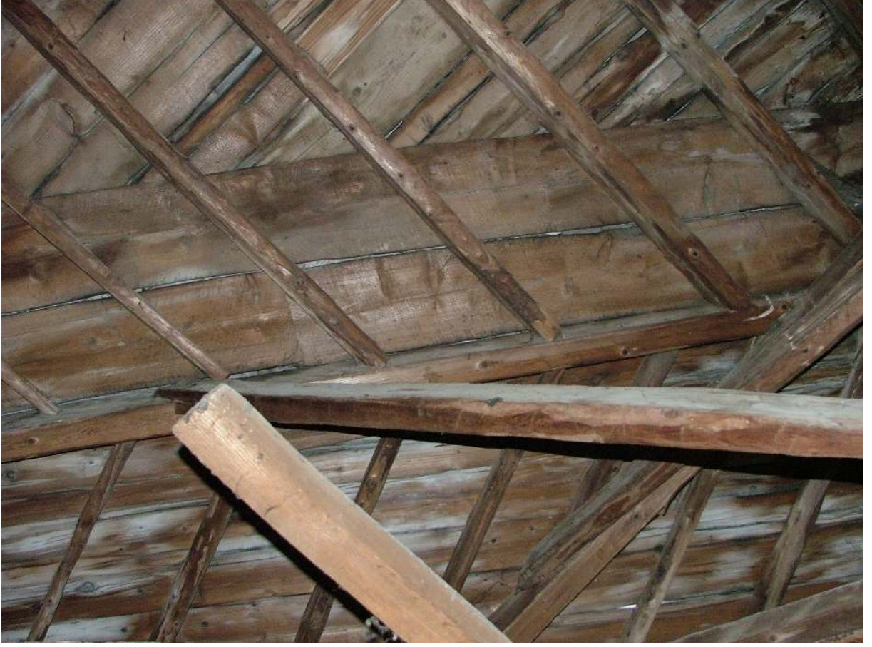
Resim 3.37 Eğime paralel kullanılan kaplama tahtası
