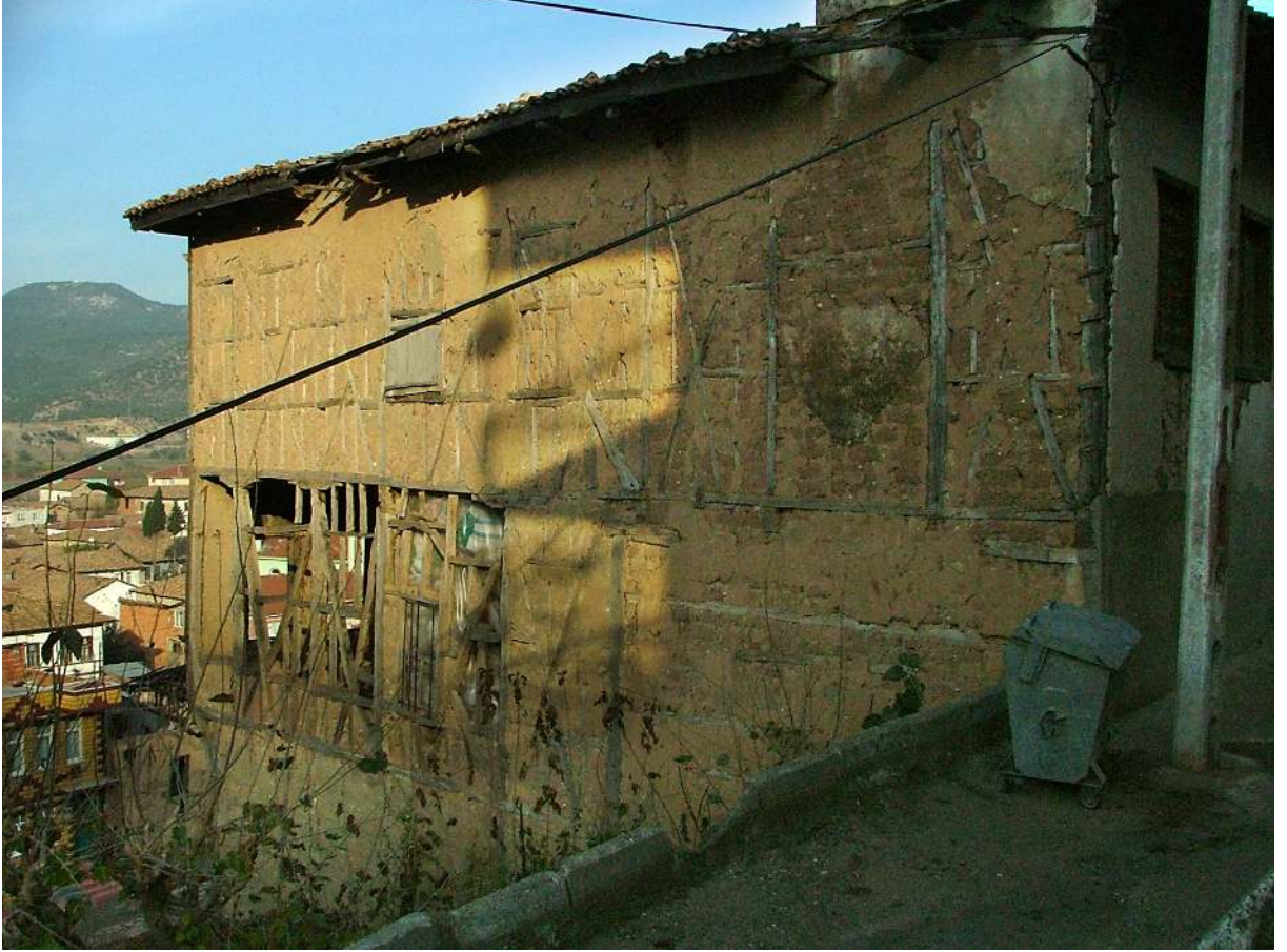
Resim 3.18 Ellezler konağı batı cephesi
