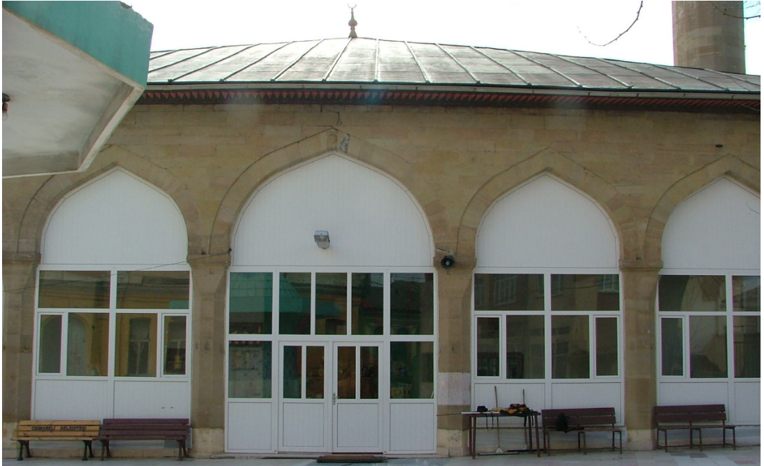
Resim 3.43 Sivri kemerlerle geçilen açıklıklar
