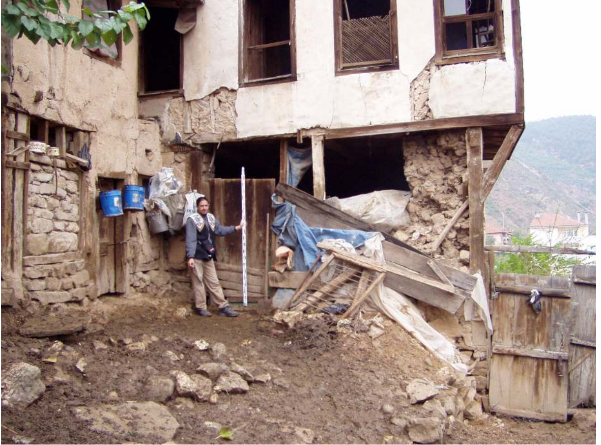
Resim 3.20 Kuzey ve gney cephesindeki deformasyon
