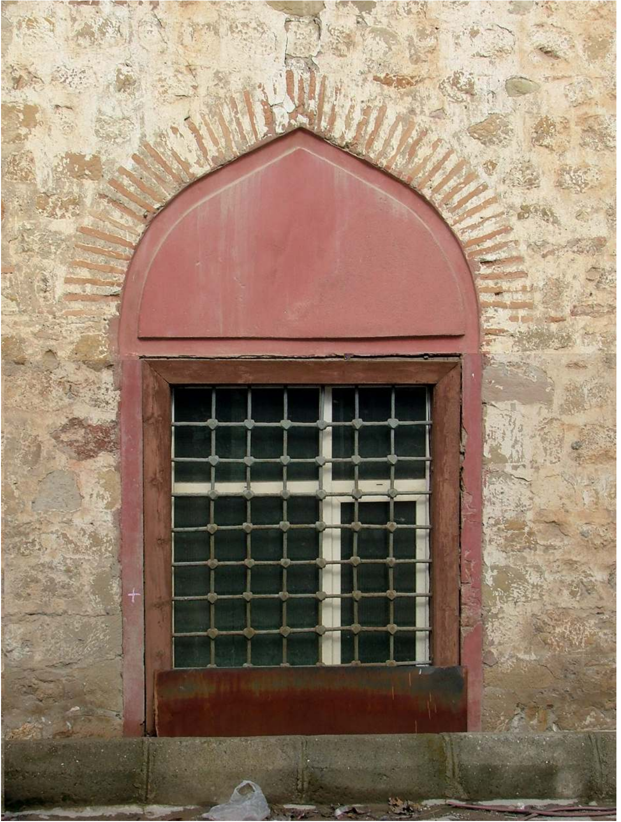
Resim 3.42 Tuğla kemerli pencere açıklığı
