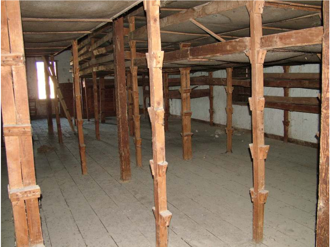
Resim 3.25 Zemin katta bulunan ahşap dikmeler
