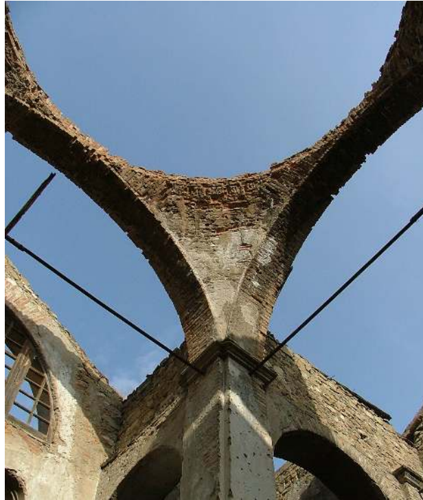
Resim 3.62 Kubbe kasnağı ve tuğla taşıyıcı ayaklar
