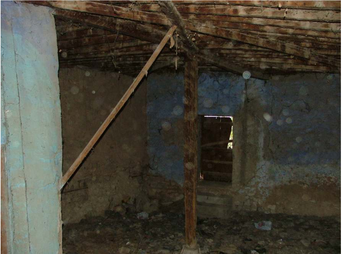
Resim 2.4 Ahşap döşemelerde kullanılan çapraz kirişlemeler
