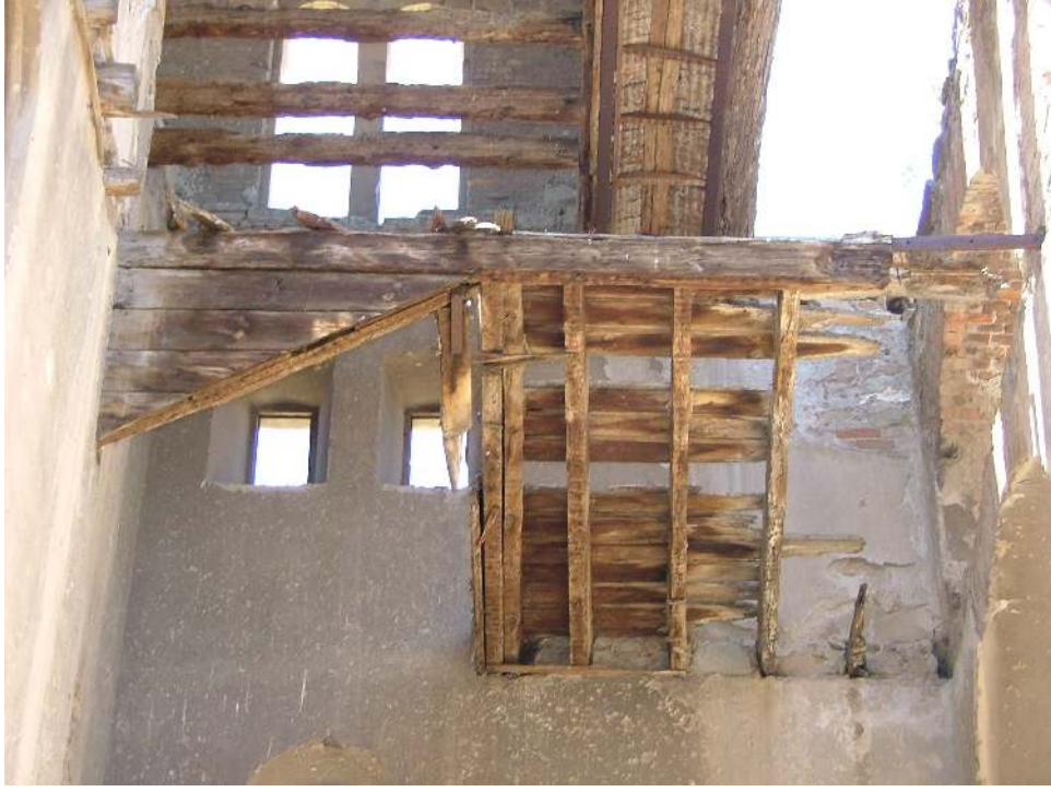
Resim 3.49 Kulelerde ahşap döşeme kalıntıları ve merdiven izleri
