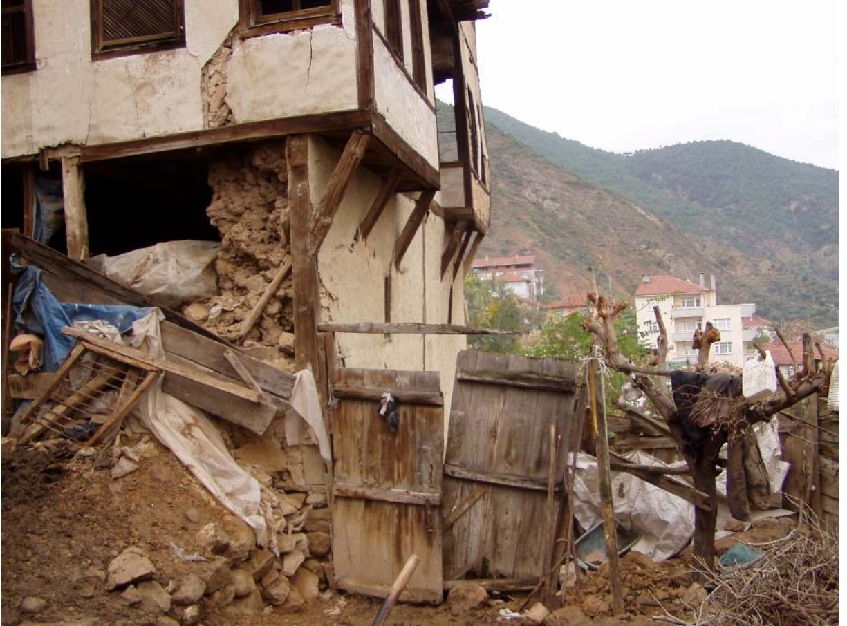
Resim 3.17 Yapının doğu cephesindeki yıkılma
