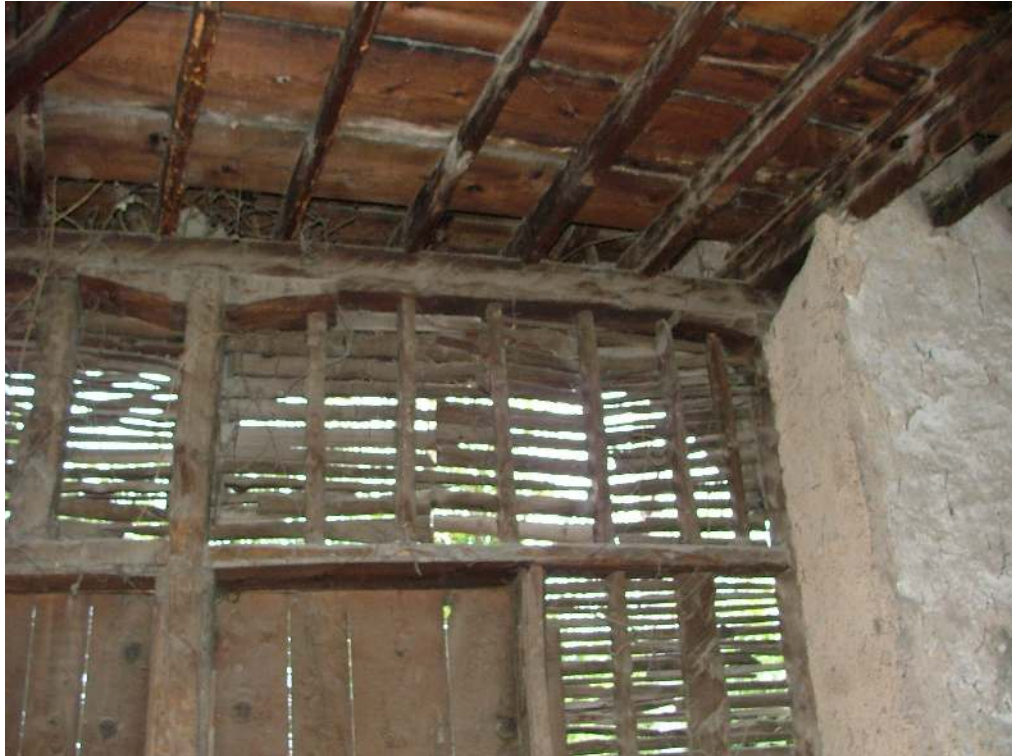
Resim 3.2 Cebecioğlu Konağı'nda tavan kaplaması yapılmamış mekanlar
