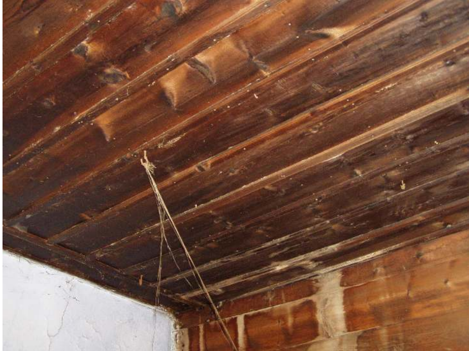
Resim 3.16 Tavan kaplaması yapılmış mekanlar (zemin kat).
