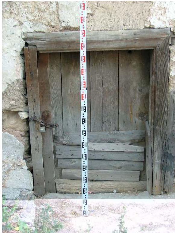
Resim 3.21 İkinci bodrum kat giriş kapısı
