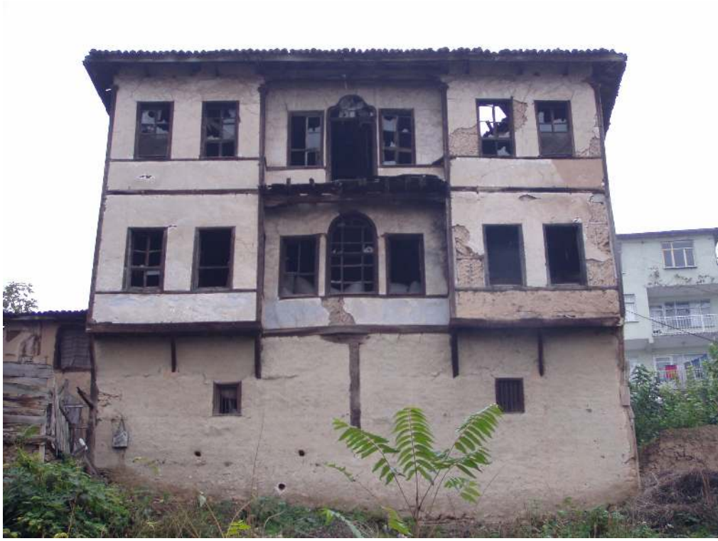
Resim 3.19 Ellezler konağı kuzey cephesi
