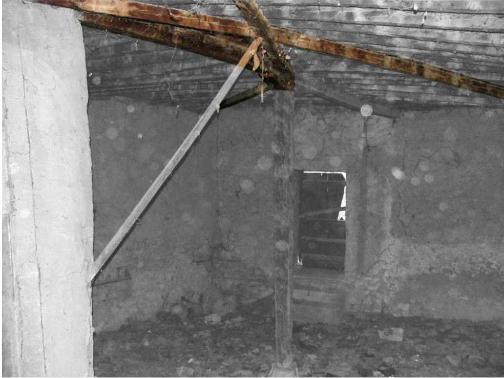
Resim 3.11 Çapraz döşeme kirişleri
