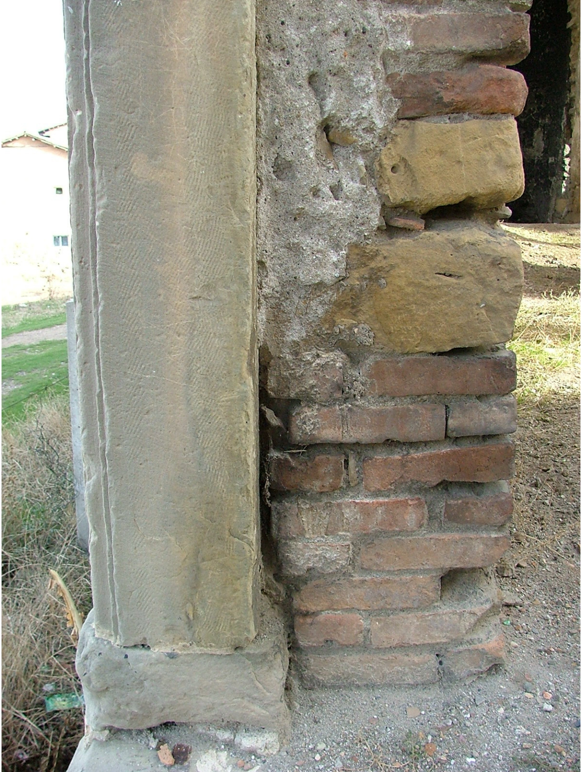
Resim 3.61 Tuğla ve Lefke taşının birlikte kullanımı
