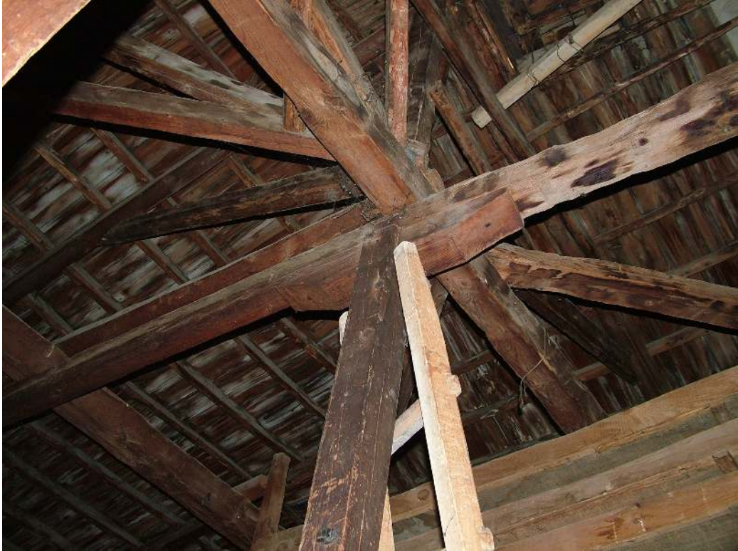
Resim 3.28 Mehmet Özden Evi çatı konstrüksiyonu
