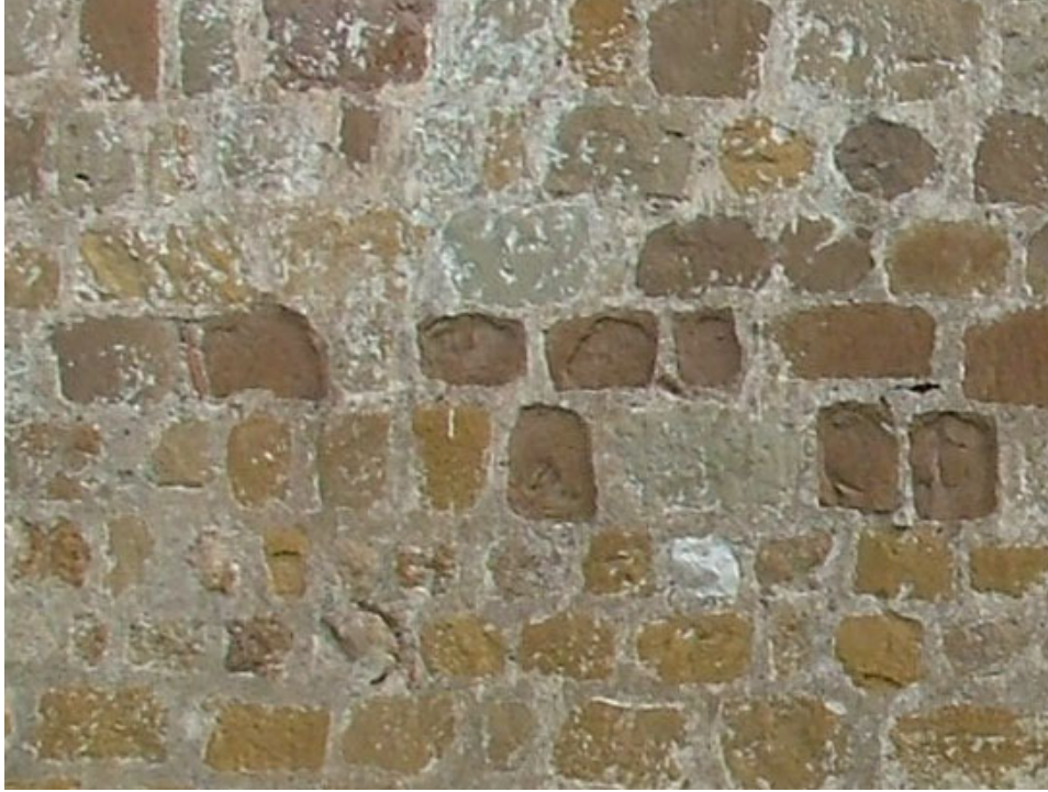
Resim 3.45 Rüstem Paşa Camii'nde kullanılan Lefke taşları
