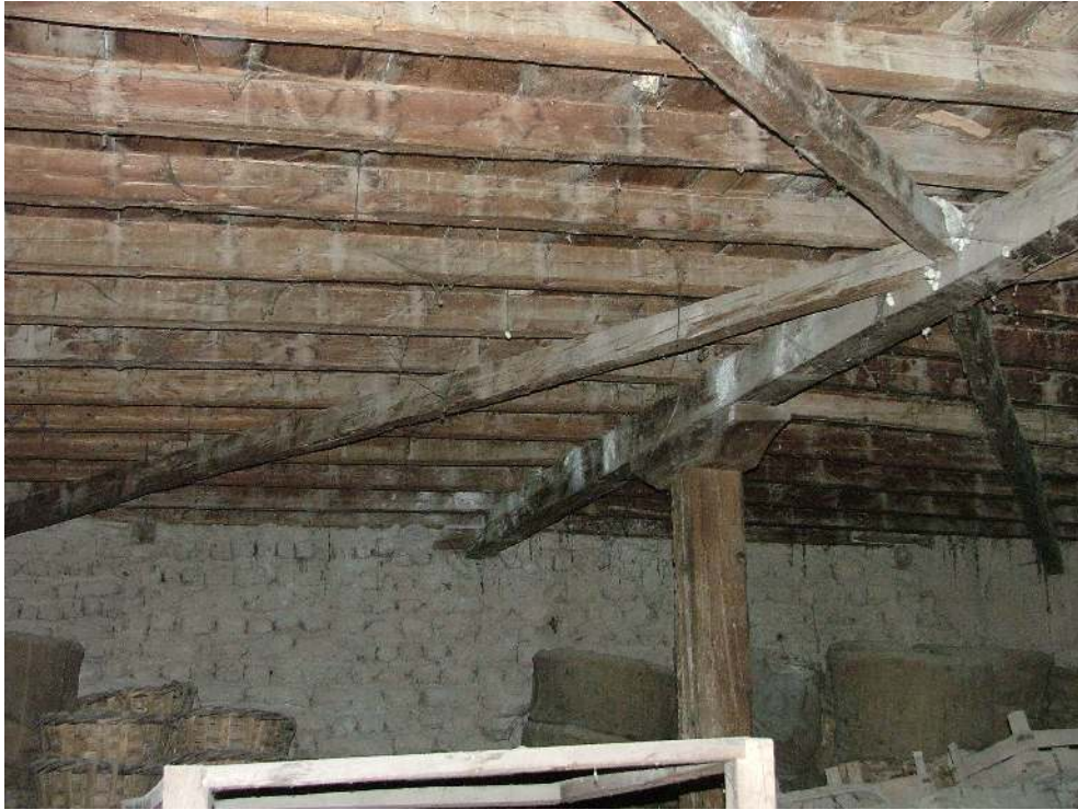
Resim 3.33 Çapraz döşeme kirişleri
