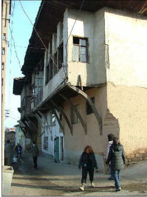
Batı cephesi ve doğuya bakış
