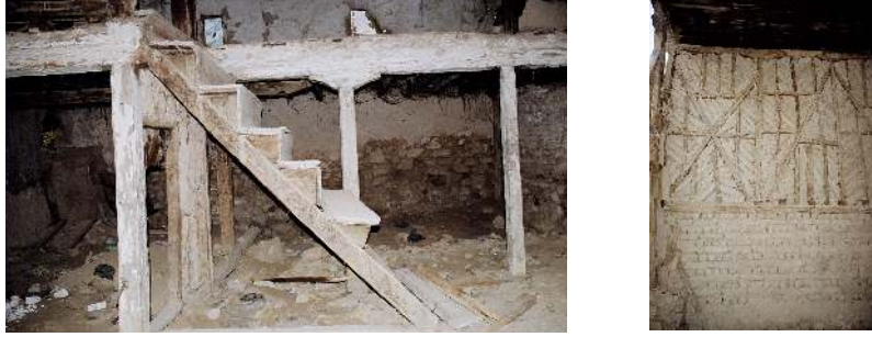
Şekil 4.11 İç duvarda ahşap karkas sistem ve merdivenlerde ahşap kullanımı
