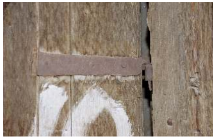
Şekil 4.15 Ahşap elemanların tesbitinde ve temel kazığı ucunda metal kullanımı
