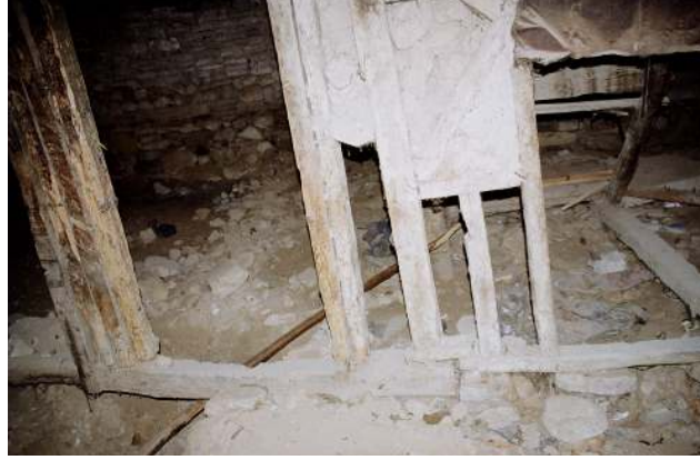
Şekil 4.14 Zemin katta moloz taş kullanımı
