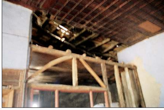
Tavan ve çatıda ahşap mlz. çürüme,kırılma...
