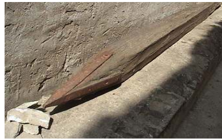
Şekil 4.15 Ahşap elemanların tesbitinde ve temel kazığı ucunda metal kullanımı
