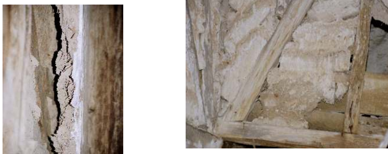
Şekil 4.13 Kıtıklı sıva ve kerpiç tuğlası
