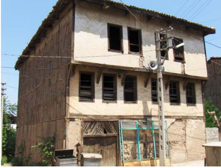
Şekil 4.3 Üst kat cephesi tamamen, sokağa doğru çıkmalı konut tipi
