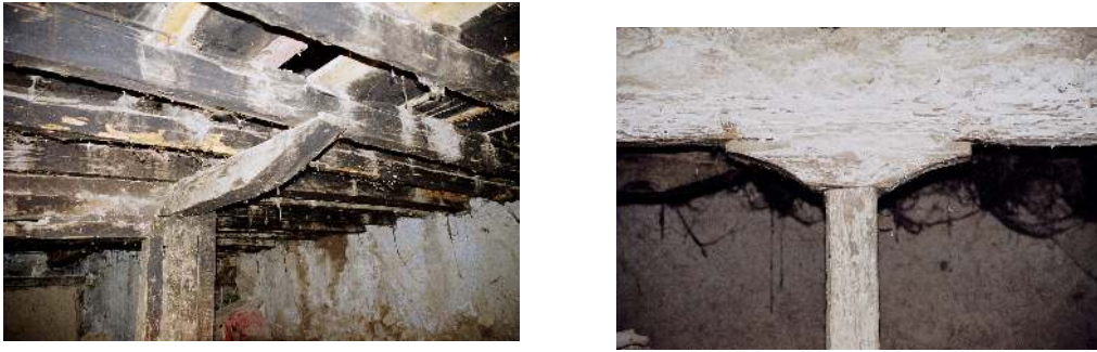
Şekil 4.11 İç duvarda ahşap karkas sistem ve merdivenlerde ahşap kullanımı
