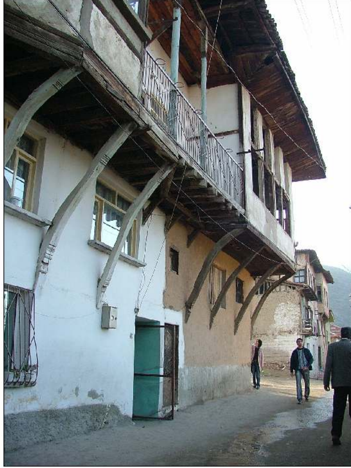
Balkon ekleyerek, kapatılan açık sofa ( ön cephe orta ve sağ kısım)
