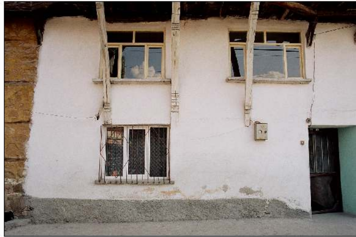
Ön cephe orta kısım zemin ve 1. kat
