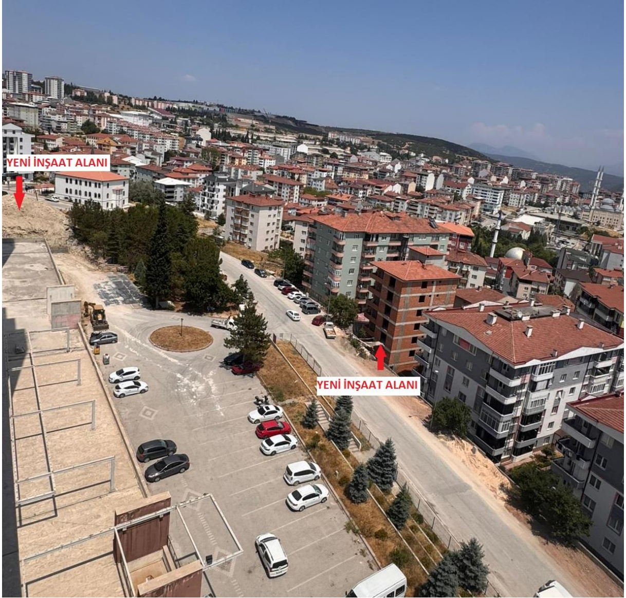
Şekil 5.3. Bahçelievler Mahallesi'nden Bir Görünüm
