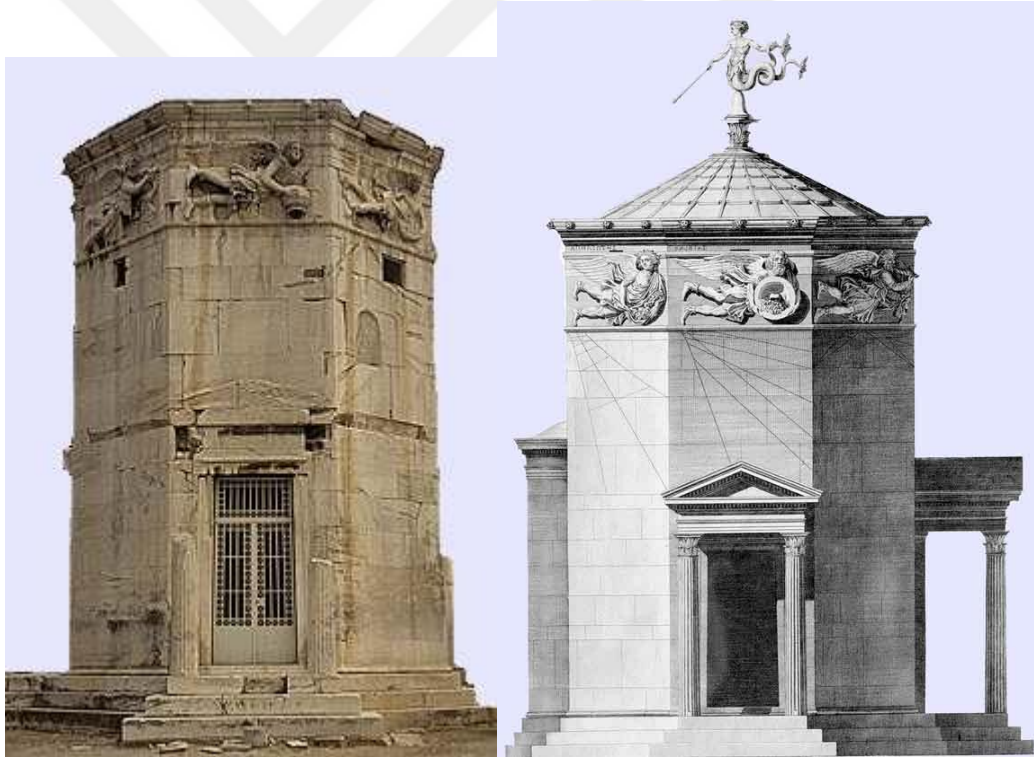
Şekil 2.20 Atina Rüzgâr Kulesi
