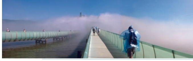
Görsel 4.4 Blur Building'e giden yaya köprüsü (http-58)
