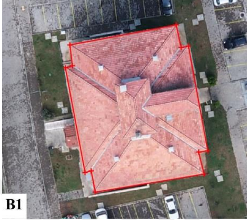
Şekil 15. İkinci çalışma alanı (B1) için bina çatı sınırlarının belirlenmesi
