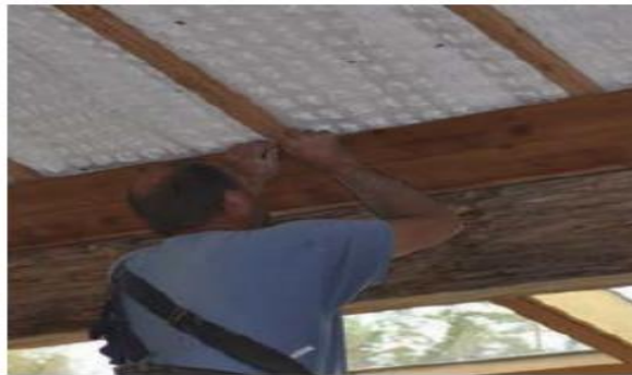
Şekil 15. Ahşap çerçeveli çatıya monte edilen FDM (URL-1)
