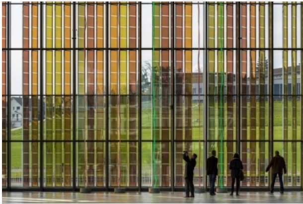
Şekil 25. Boyaya duyarlı FV hücrenin pencerede kullanımı (URL-6, 2020).
