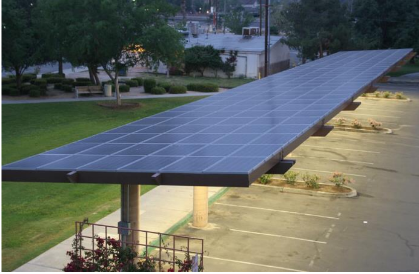
Şekil 58. Otopark alanlarında BEFV'nin gölgeliklerde kullanımı (URL-23, 2012).
