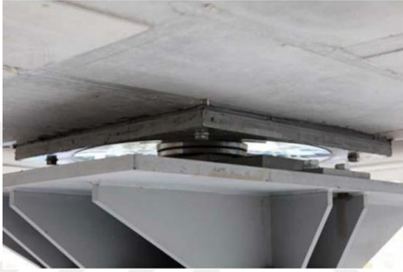
Resim 1.2 Kayıcı izolatör
