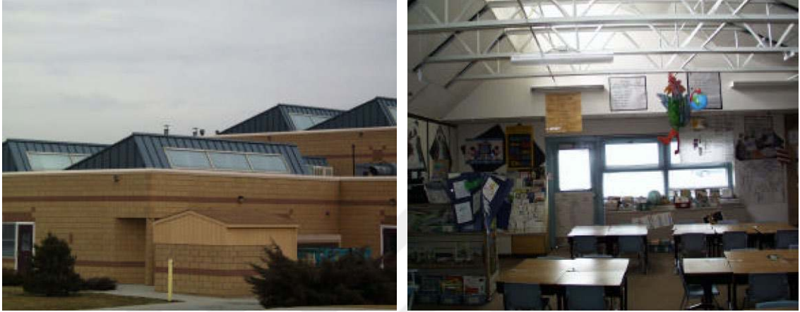
Görsel 5.5. Okulun çatı penceresi ve iç mekan aydınlatması (Heschong, 1999, s.18-19)
