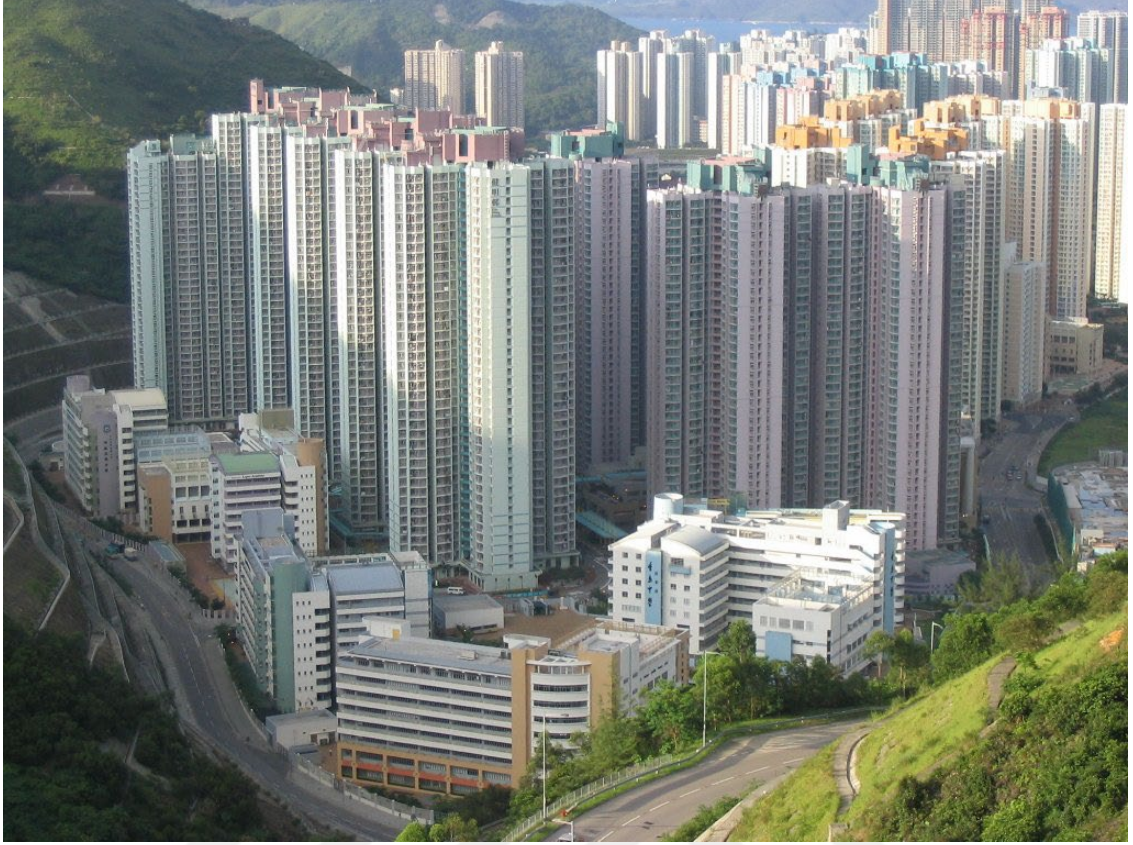
Görsel 5.1. Yüksek katlı konut binaları, Hong Kong ( http-5 )
