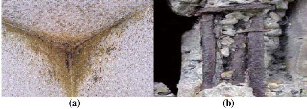
Şekil 5.10. (a) Yüzeyde (b) kesit içinde yoğuşma (Hokkacı, 2013).
