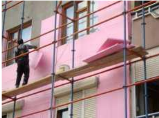
Şekil 7.1. Dıştan yalıtım uygulaması (Koçu ve Dereli, 2010).
