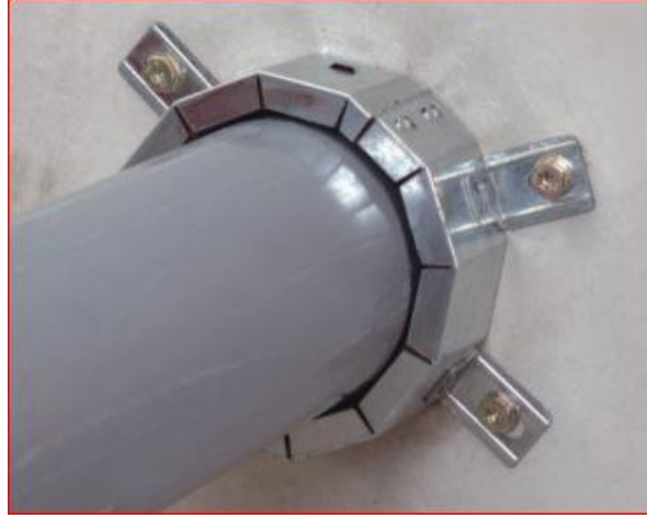
Şekil 4.25. Borularda yangın durdurucu kelepçe [44]
