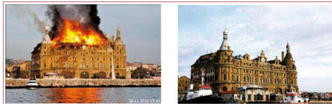
Şekil 3.11. Haydarpaşa Garı çatı yangını [17]
