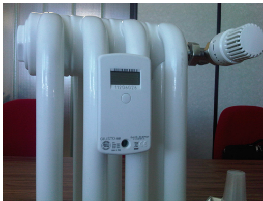
Şekil 3.2: Isı pay ölçer ve termostatik vana.
