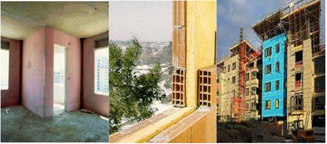
Şekil 3.2.(b). Duvarlarda yapılan yalıtım örnekleri
