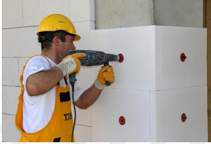
Şekil 2.21. Gaz beton yalıtım levhası uygulaması (Albinagrup, 2021)
