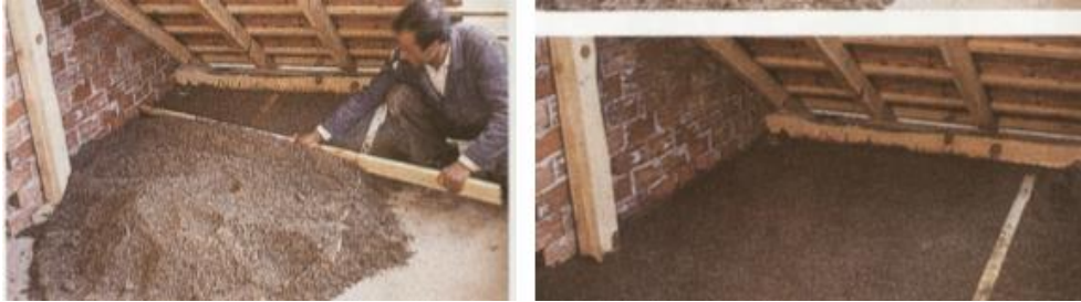
Şekil 2.20. Perlitli betonun ısı yalıtım amacıyla uygulanması (Karakoç ve ark., 2011)
