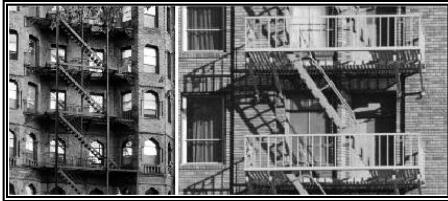
Resim 3.1. Dış kaçış merdivenleri [32]
